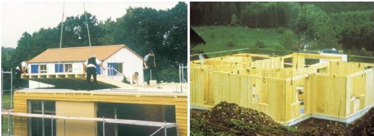
**Bild 3.1: Holztafelbau und Holzmassivbau**
