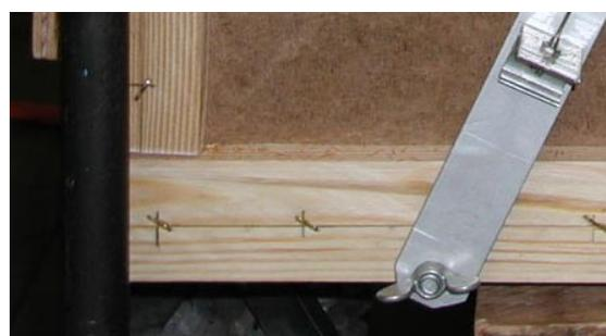
Bild 6-2: Durch Konterlatte hinterlegte Klammer
