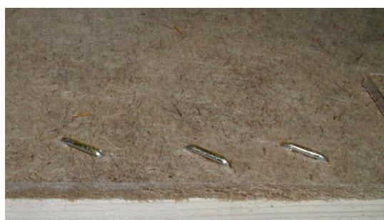
Bild 6-1 : Aufgesetzte Klammer
