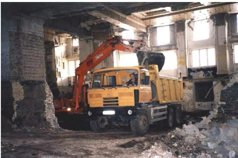
Abb.: Teilabbrucharbeiten innerhalb eines Gebäudes
