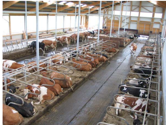
Bild 1: Pilotbetrieb eines Milchviehstalls des LfL mit Schieberanlage
