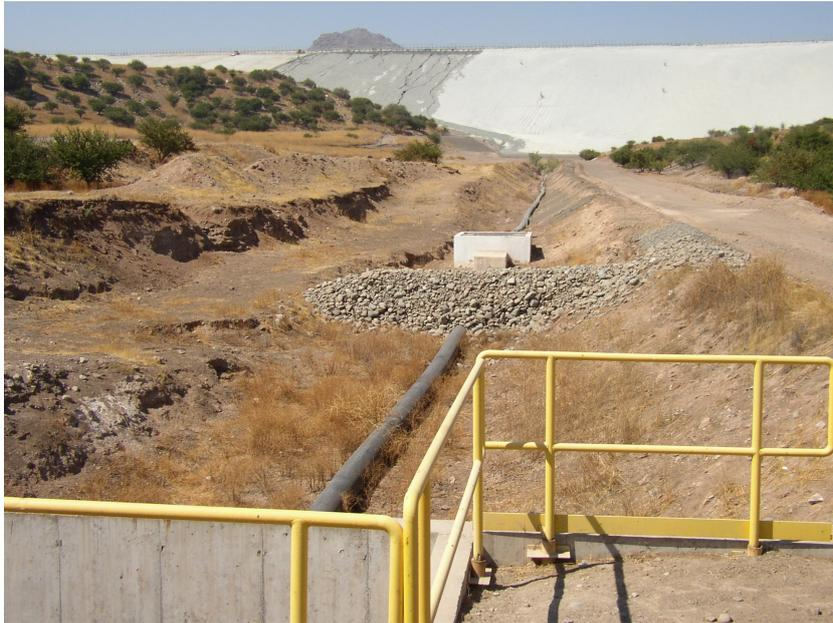
Abbildung 15.3: Staudamm aus Schlacke des Tranque (Foto: E. Boll).
