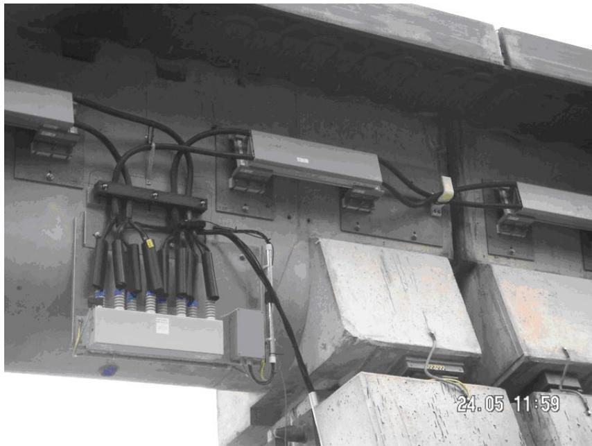
**Bild 3:** Primärseitiger Kompensationskondensator am Transrapid-Fahrweg
