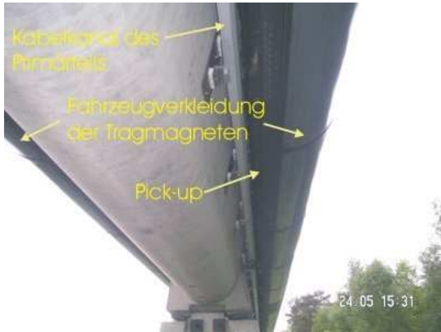
Bild 9: Blick von unten auf den Fahrwegträger mit darüber befindlichem Fahrzeug
