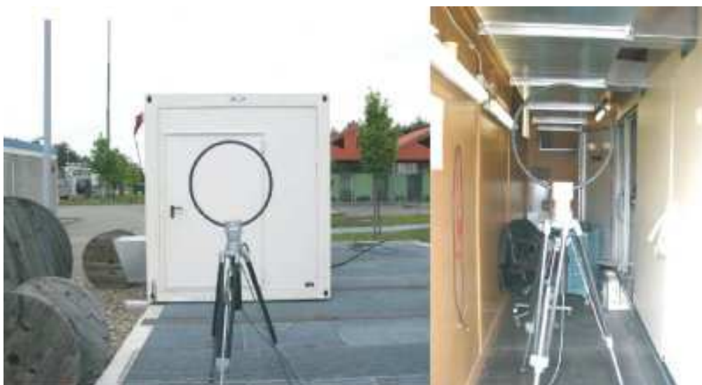
Bild 10: Einspeisecontainer (Außen- und Innenansicht) während der EMV-Messungen
