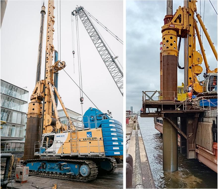
**Abbildung 24: Bohrgerät BG 55 (links) und Bohrvorgang im Kellybohrverfahren mit Bohrrohr  $\varnothing 200$  cm (rechts)**
