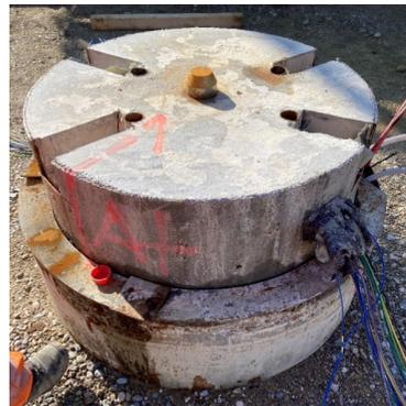
**Abbildung 20: Pfahlkopf nach der Betonage mit geschütztem Ringspalt**
