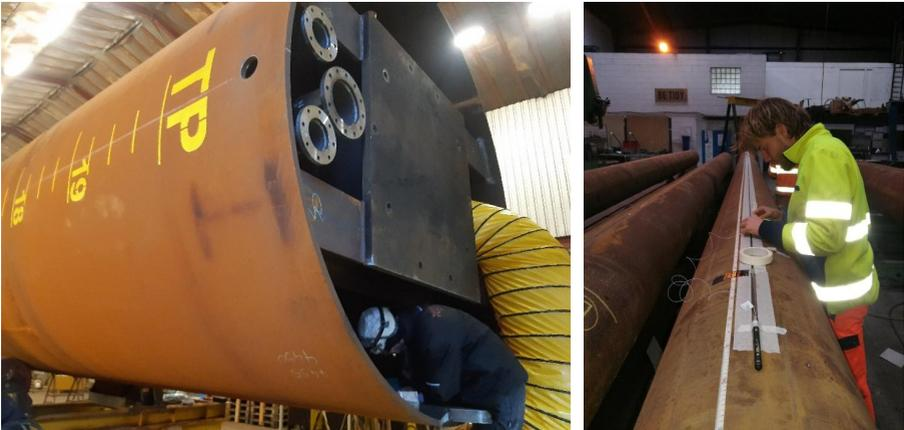
**Abbildung 9: Instrumentierung von Monopfählen mit FBG Sensoren**
