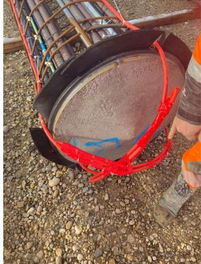
**Abbildung 18: Konisches Betonfertigteile unterhalb Kraftmessdose mit Injektionsleitungen zur Verfüllung der Kiespolsterbettung**
