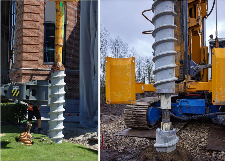
**Abbildung 3: Einbringen CPSP-Pfähle mit Kupplung**
