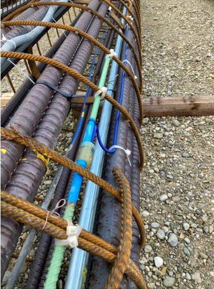
**Abbildung 15: Bewehrungskorb mit  $\varnothing 40$  Doppelstäben, Betonverformungsmessgebern, faseroptischen Sensoren und Extensometerrohren**
