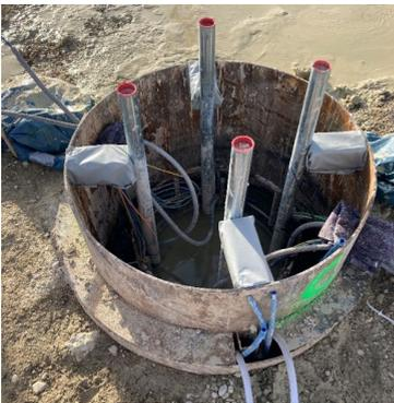
**Abbildung 19: vorbereiteter Pfahlkopf vor der Betonage**
