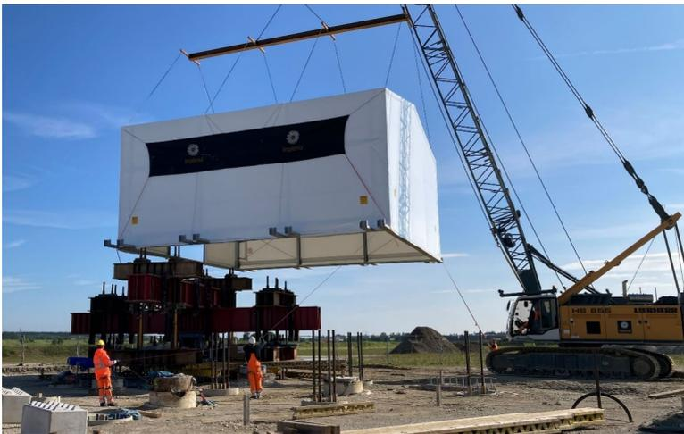
**Abbildung 22: Setzen der kranbaren Profilträgerhalle**
