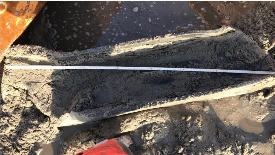
**Abbildung 7: Mithilfe eines Bohrlochgreifer geborgenes Stahlträgerhindernis (© Züblin Spezialtiefbau GmbH)**
