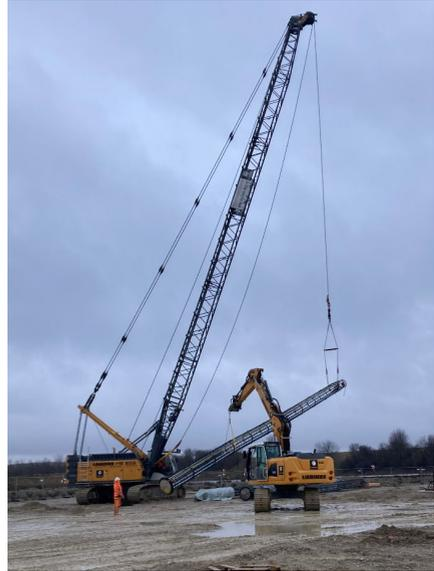
**Abbildung 16: Aufrichten der steifen Bewehrungskörbe ohne signifikante Durchbiegung**
