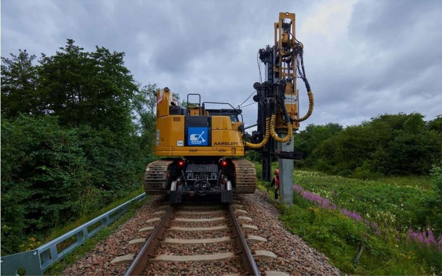
**Abbildung 7: Einbringen eines Mastfundamentpfahles**
