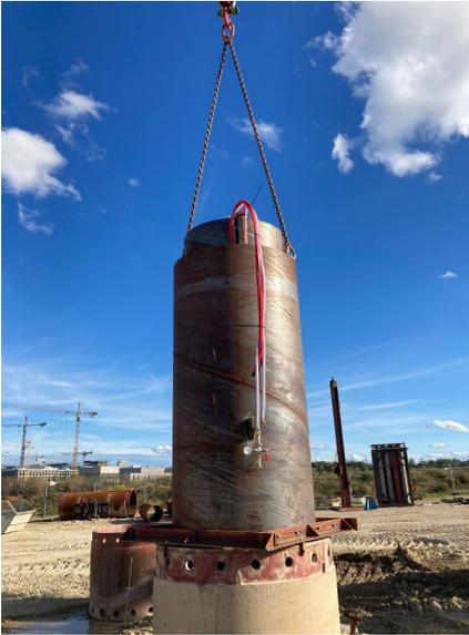
**Abbildung 11: Einsetzen des Mantelreibungsausschlusses in die Pilotbohrung mit Justiereinrichtung**
