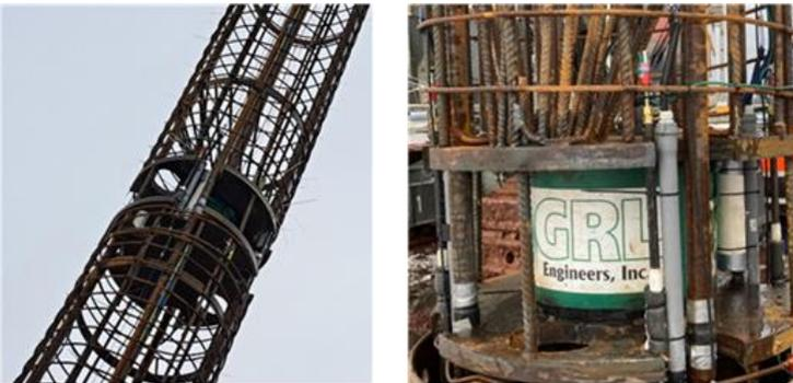
**Abbildung 4: Installation Bewehrungskorb mit Lastzellen und Messtechnik, Korbeinbau auf der Baustelle**
