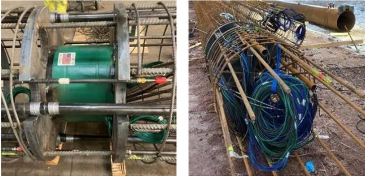
**Abbildung 3: GRL-Cell Einbau im Korb und Kabelmanagement**
