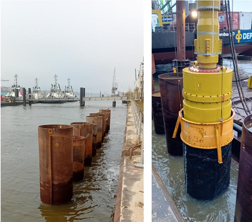
**Abbildung 26: Eingebaute Tragrohre (links) und Rammvorgang mit Rammhaube (rechts)**
