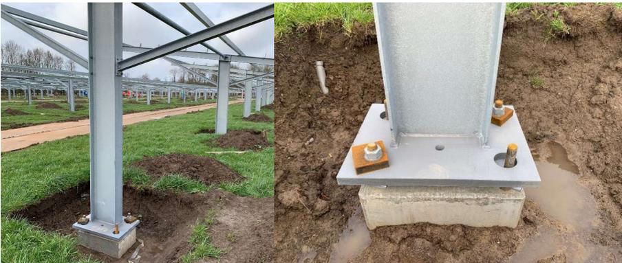
**Abbildung 9: Solarcarport Freizeitpark Mojo (NL), Stützen mit direktem Anschluss**
