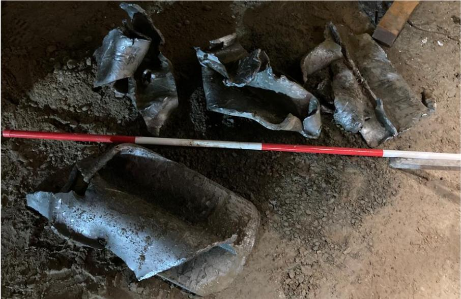
**Abbildung 5: Mithilfe einer Bohrschnecke geborgenes Stahlträgerhindernis (© Züblin Spezialtiefbau GmbH)**
