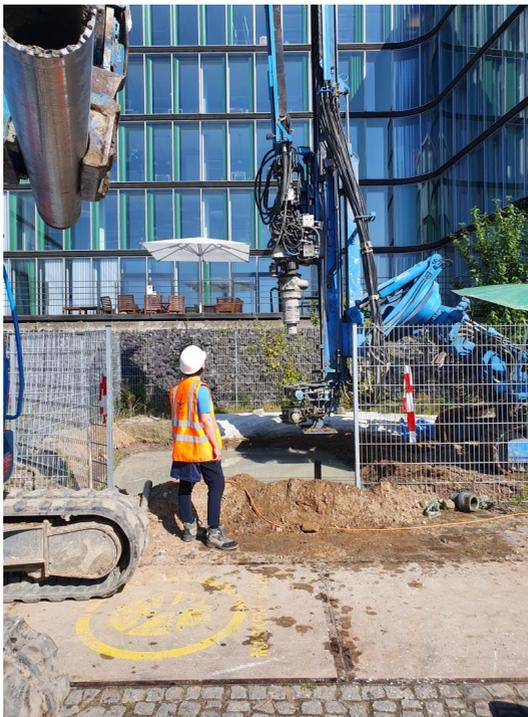
**Abbildung 19: Herstellung von Probepfählen – Mikroverpresspfahlgerät vor Haus 2**
