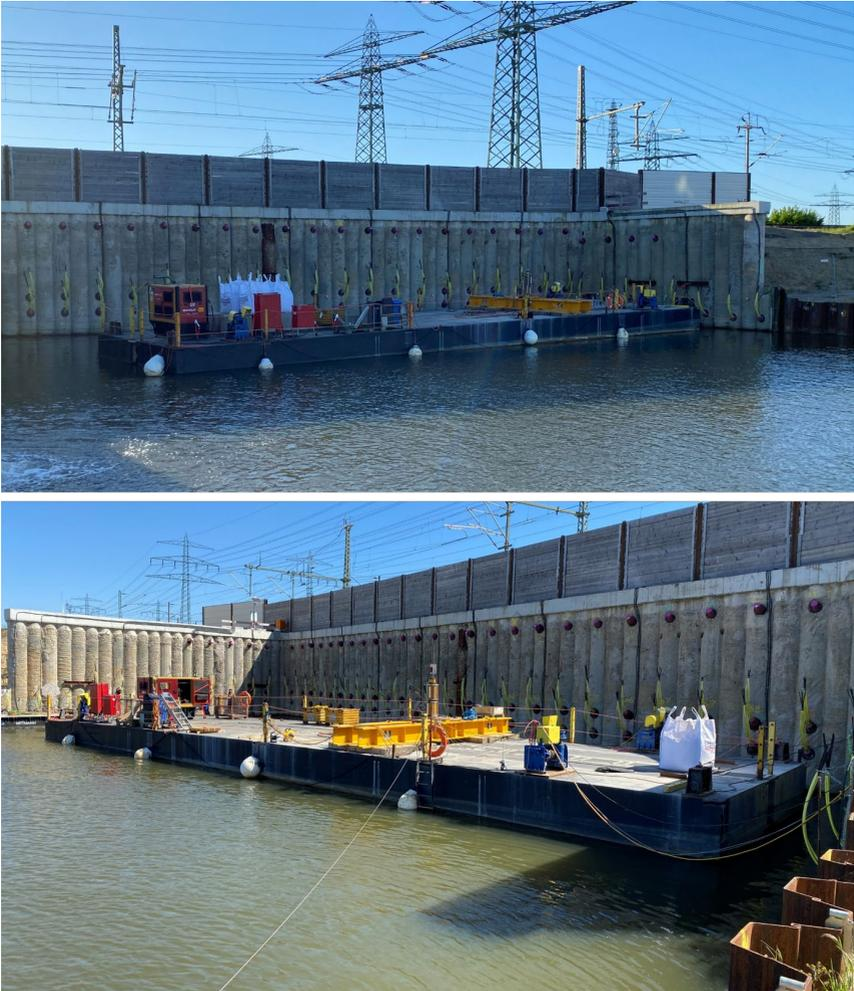
**Abbildung 11: Unvorteilhafte Pontonposition an der Baugrubenstirnseite, exzentrischer Aufbau des Reaktionssystems und hochgelegene Anschlagpunkten**
