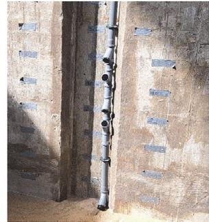
**Abbildung 7. Installation des verteilten faseroptischen Sensors in der unteren Ebene. Sensor verlegt in der Furche (links), PVC-Rohr als Schutz für den Sensor beim Übergang zur einer höheren Ebene (rechts)**
