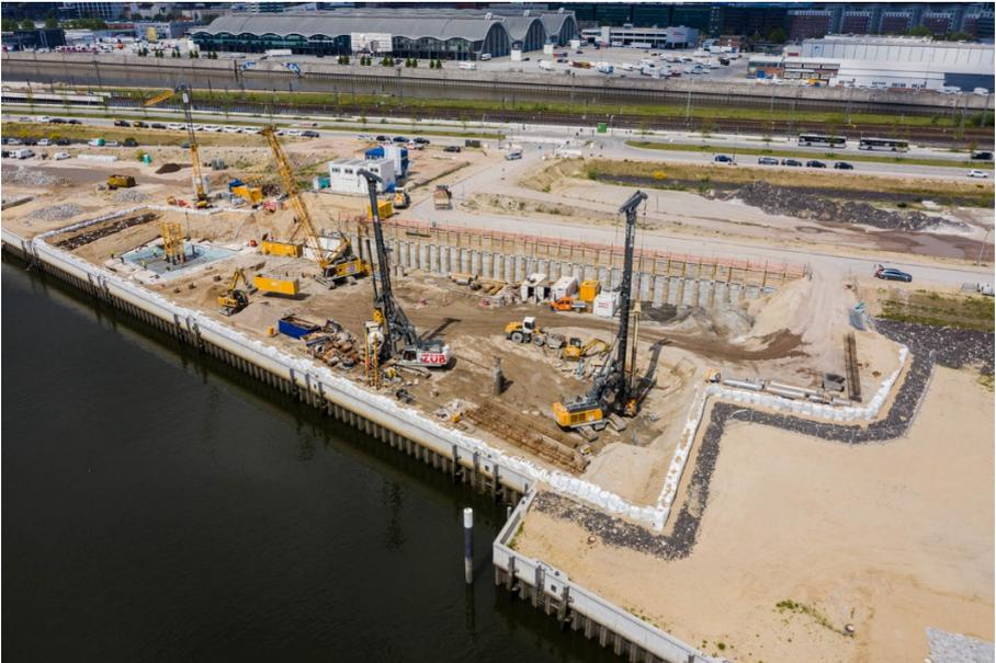
**Abbildung 8: Drohnenaufnahme des Baufelds 102 während der Herstellung der Gründungspfähle (© Sebastian Engels Fotografie)**
