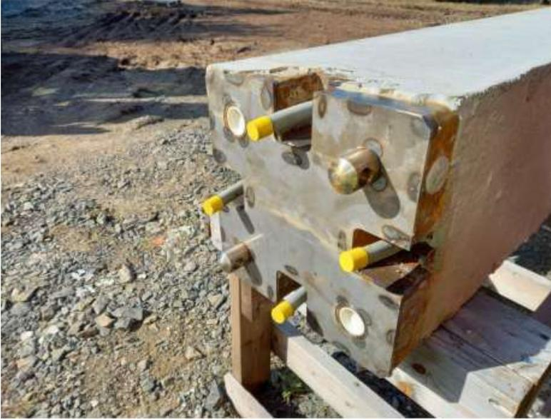
Abbildung 18: Pfahlkupplung für geothermische Leitungen
