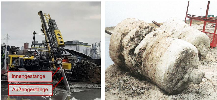
**Abbildung 8: Herstellung eines geeigneten Düsenstrahlkörpers am Steinwerder Kai (links) und geborgene Düsenstrahlkörper am Container Terminal III Bremerhaven (rechts) [5].**
