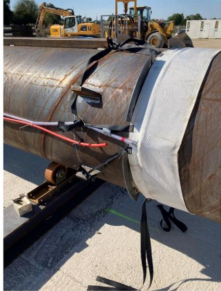
**Abbildung 10: Produktion der Stahlrohrhülsen für den Mantelreibungsausschluss (MRA-Innenrohr) mit Packer, Schläuchen, Abstandhalter etc. in einer Feldfabrik**
