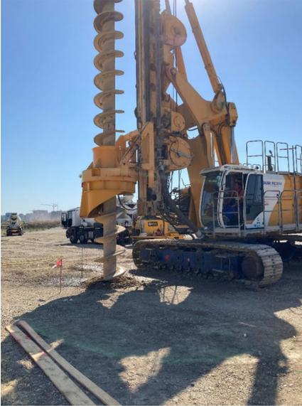
**Abbildung 9: Herstellung Reaktionspfähle  $d = 880$  mm und Bohrtiefe bis 21 m im SOB-Verfahren mit Kelly-Verlängerung**
