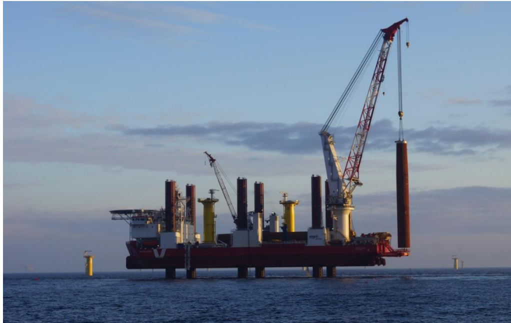
Bild 39: MPI Discovery während der Installationsarbeiten
