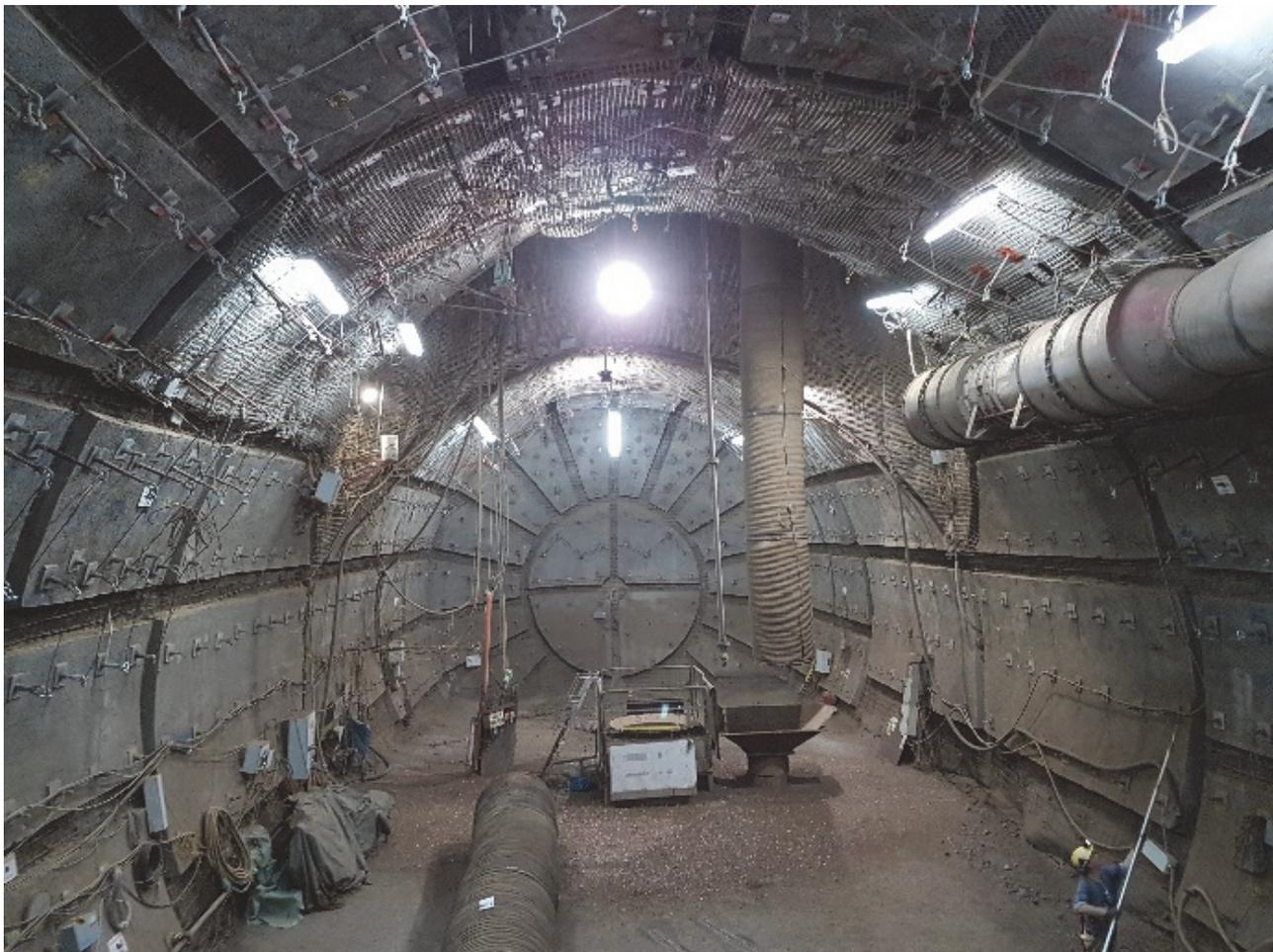
**Abbildung 5: Spritzbetonschale inklusive Systemankerung (Gleitanker) und offenen Stauchfugen nach dem Ausbruch der Strosse**
