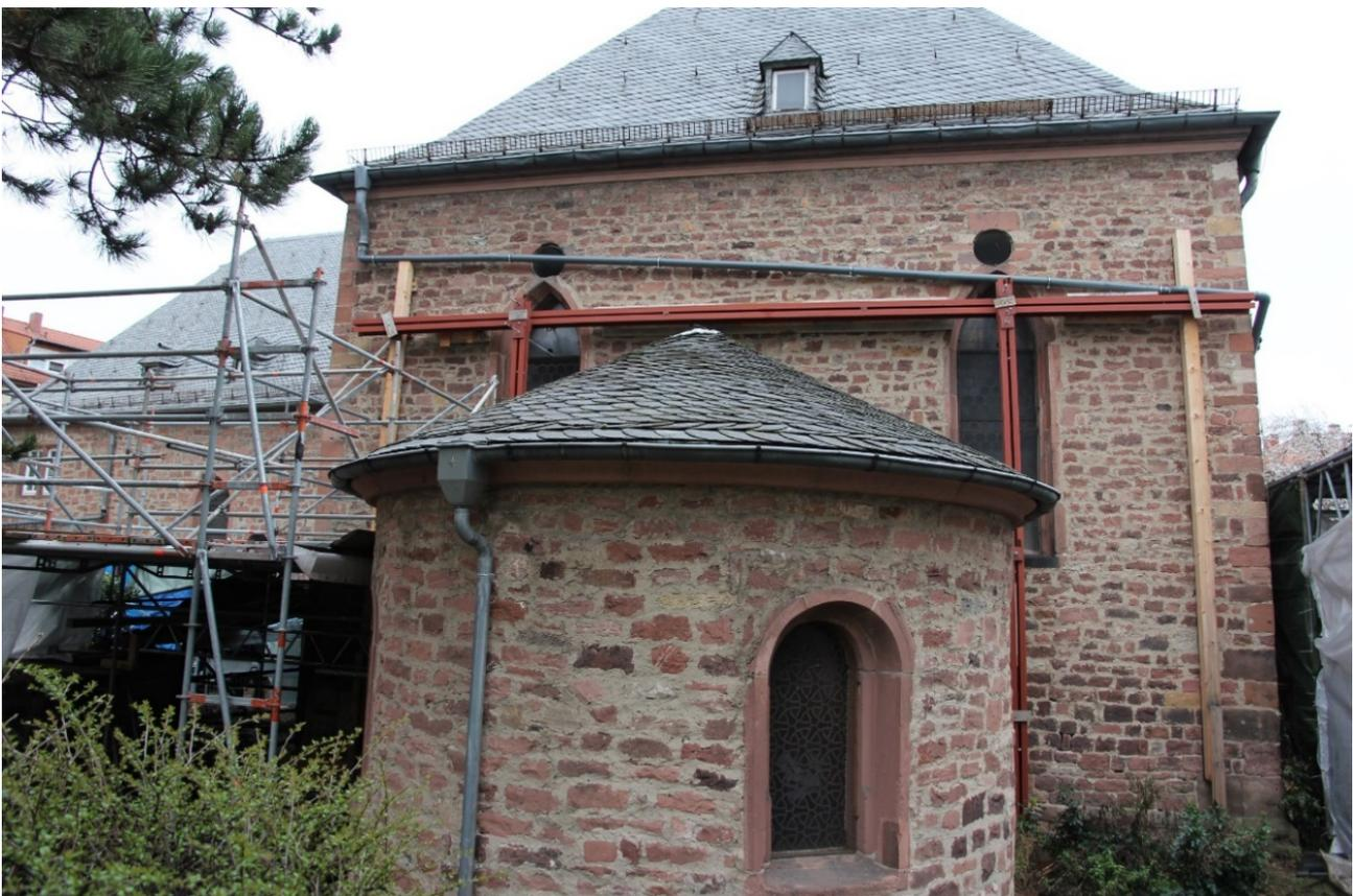
**Abbildung 3: Die konstruktiven Sicherungsmaßnahmen an der Wormser Synagoge**
