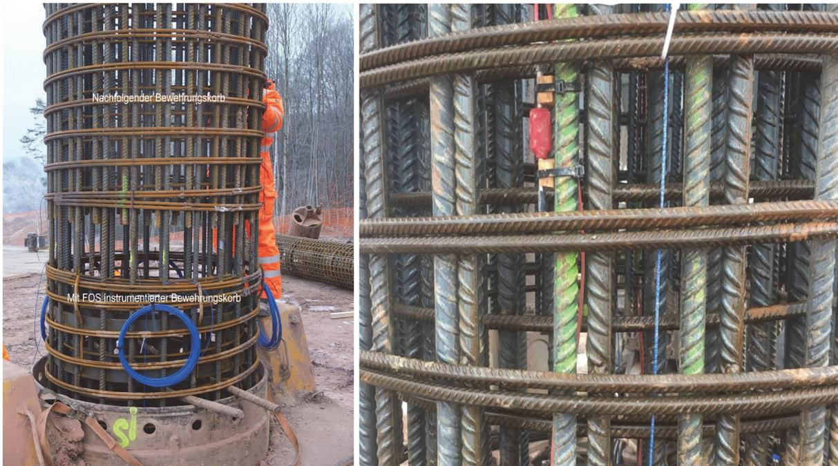
**Abbildung 12: links: Stoß zwischen zwei aufeinanderfolgenden Bewehrungskorbsegmenten über dem Bohrloch und Sensorkabel (blau), rechts: Schwingsaitensensor (rot) und faseroptischer Dehnungssensor (blau) im Bewehrungskorb © SENSICAL**
