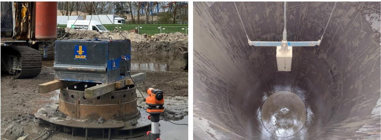
**Abbildung 3: Echolotsensor zentrisch über und im Bohrloch ausgerichtet (Quellen: DEGES, BBI)**
