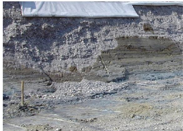
Abbildung 4: Beispiel Grenze zwischen quartären Kiesen und tertiären Schichten anhand einer Böschung in eine Baugrube (4 m Höhe) (aus Bauer et.al. 2005)
