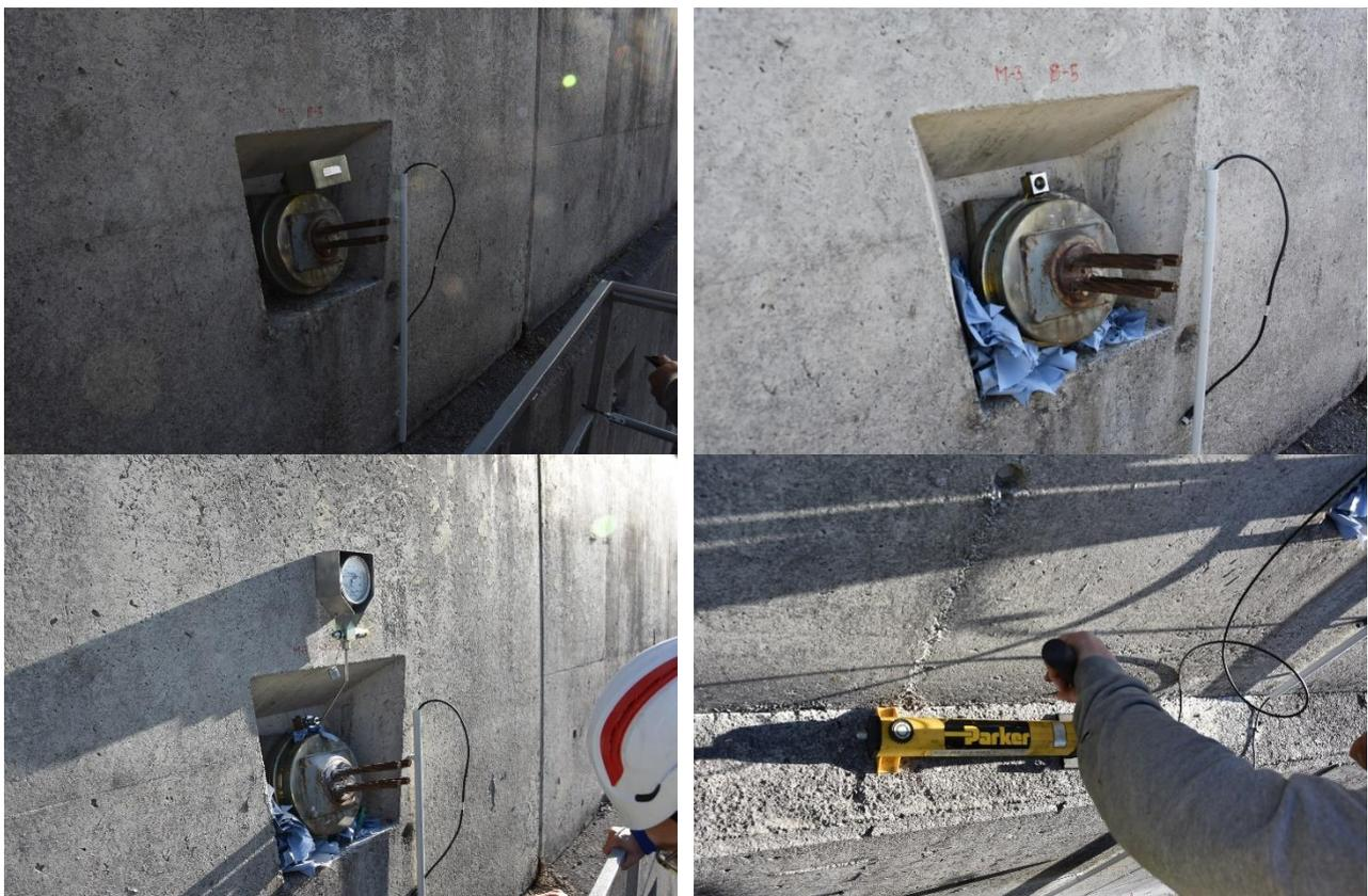
**Abbildung 14: Arbeitsschritte bei der Digitalisierung eines bestehenden und installierten Kraftmesstellers**
