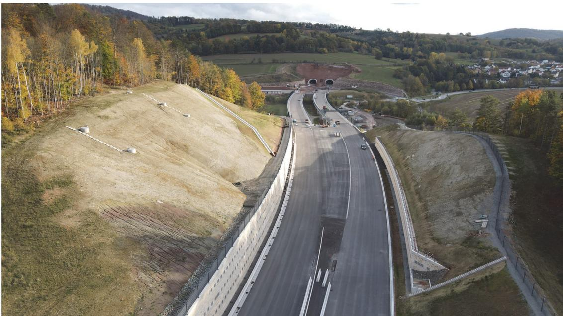
**Abbildung 1: Fertiggestellte Böschungssicherung im Bereich Heuberg mit Blick in südlicher Richtung zum Tunnel Boyneburg. Stand 11/2022**
