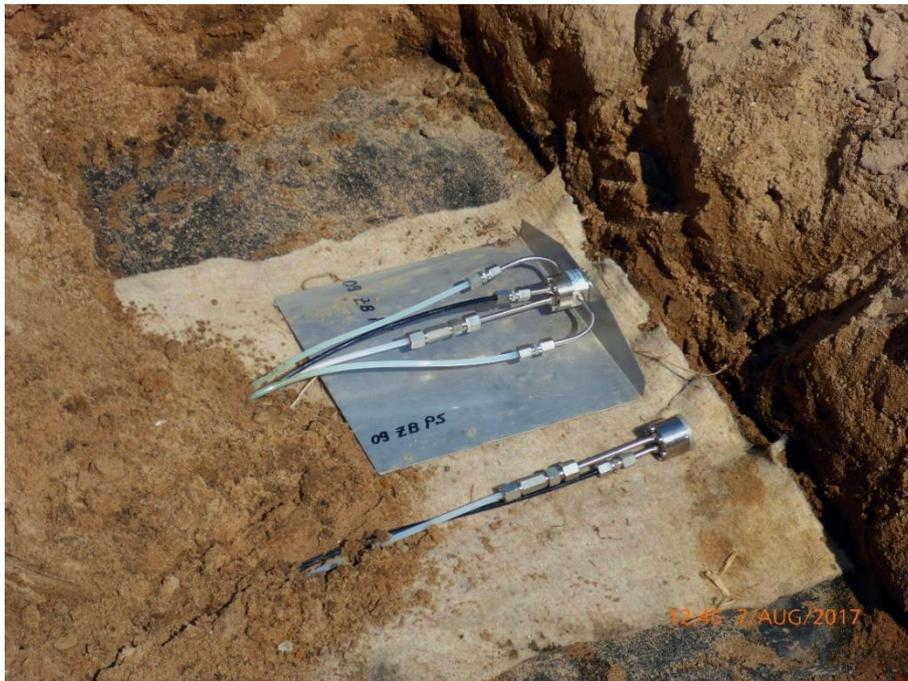
**Abbildung 10: Installation eines Setzungs- und Porenwasserdruckmessgebers auf der Kunststoffdichtungsbahn der Basisdichtung**
