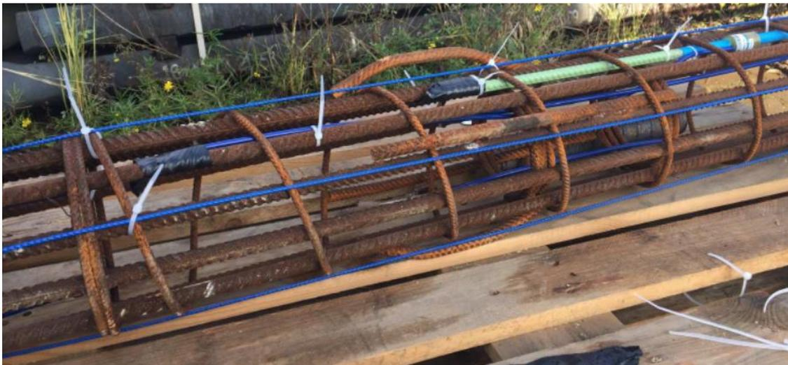
**Abbildung 10: Bewehrungskorb mit faseroptischen Dehnungssensorkabeln (Stump / GGB / GESO) [KINDLER, SCHALLER, GLÖTZL & GROSSWIG, 2017]**
