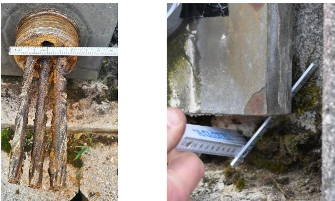
**Abbildung 4: Schäden an Zugelementen; Korrosion im Ankerkopfbereich (links); versagter Anker (rechts)**
