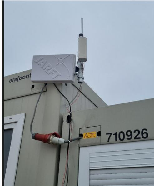
**Abbildung 8: Outdoor Gateway zum Empfangen der Daten und weiterleiten an das Baustellennetzwerk**
