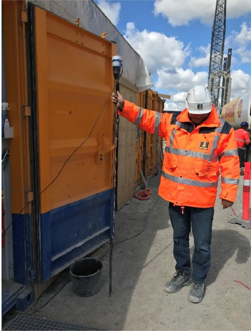
**Abbildung 5: Sensor zum Erfassen des Suspensionsspiegels**
