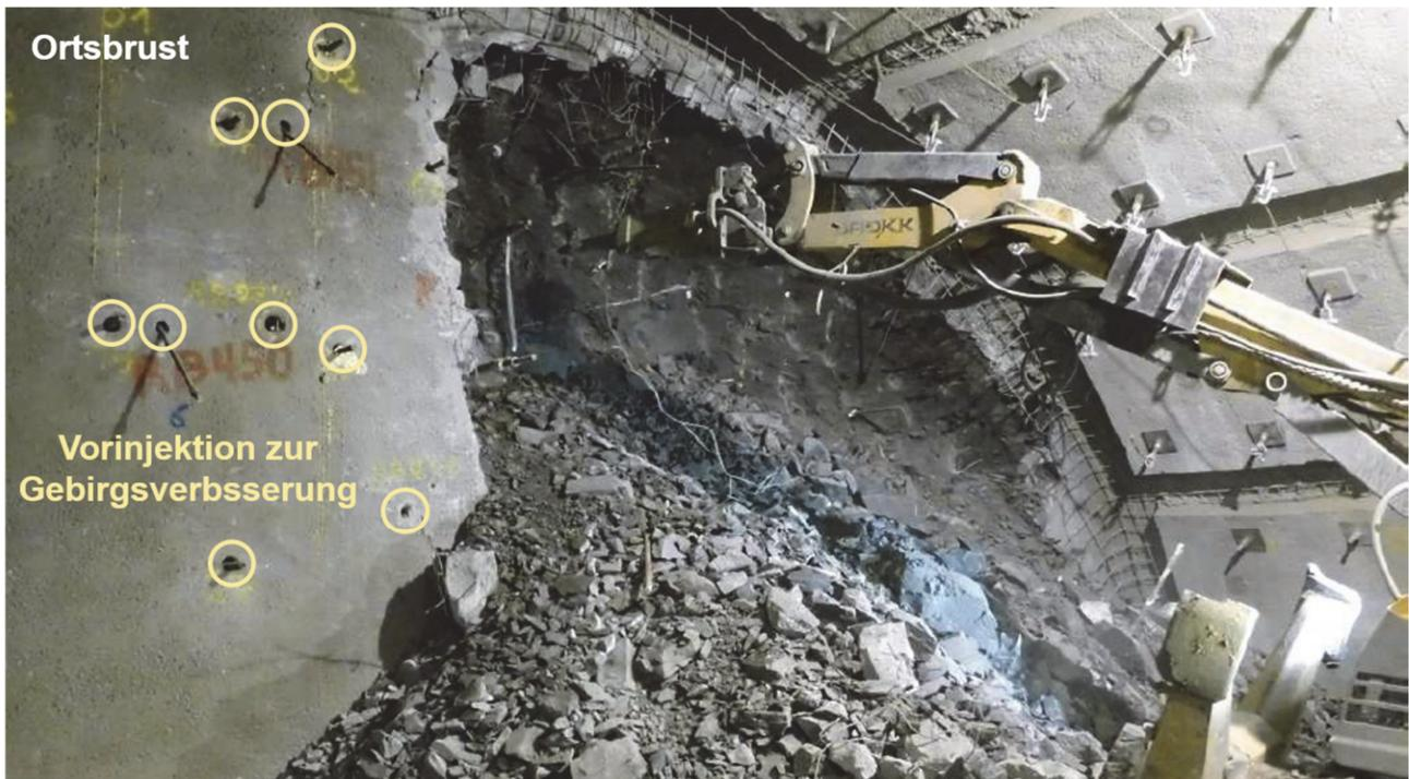
**Abbildung 10: Injektionsbohrungen, Kalottenvortrieb sowie Außenschale mit Systemankerung und Stauchfugen**
