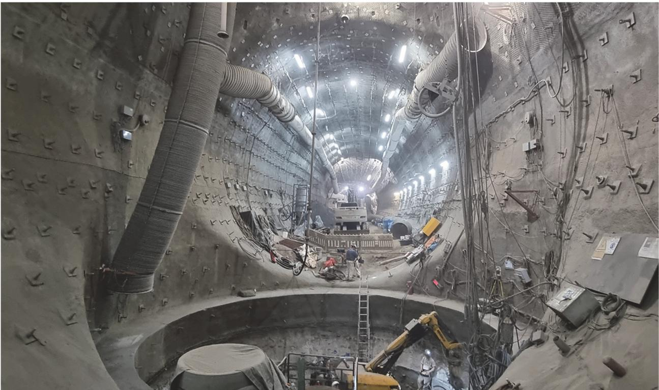
**Abbildung 13: Füllort 2. Sohle mit geschlossenen Stauchfugen und Ringschluss**
