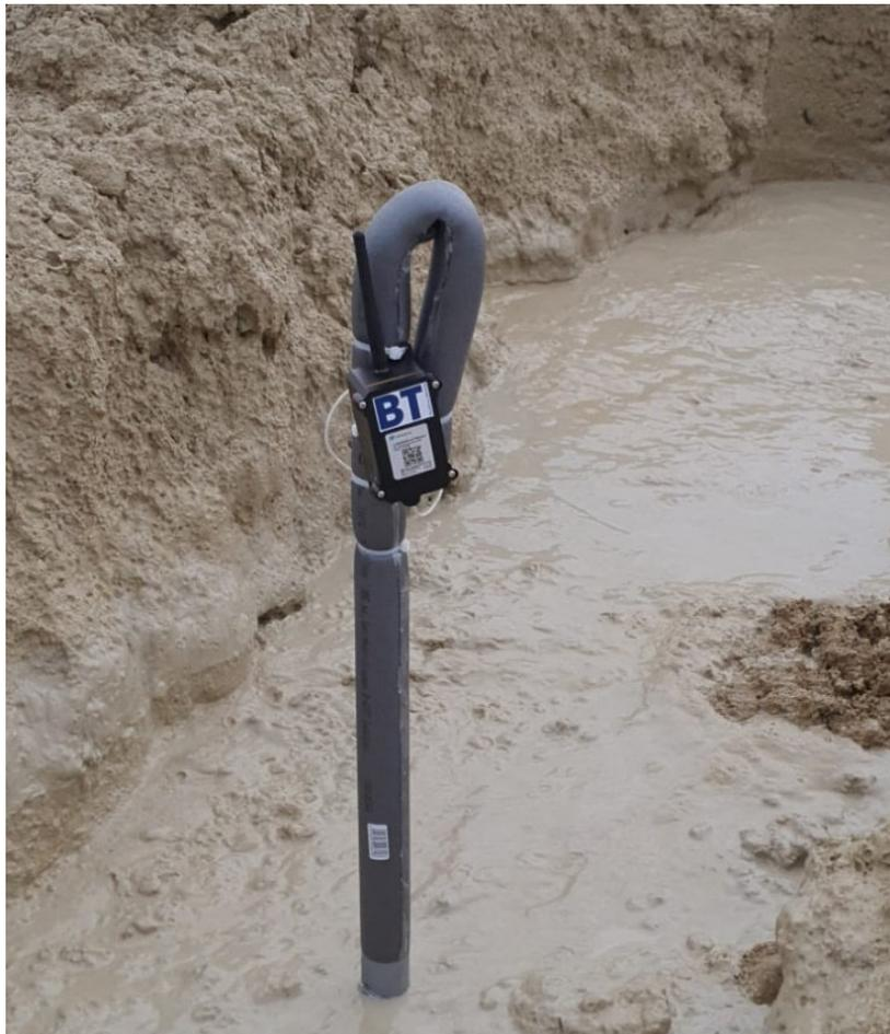
**Abbildung 7: Device zur Temperaturerfassung, welches mittels Messrohr in dem frischen MIP®-Element eingebaut wurde**
