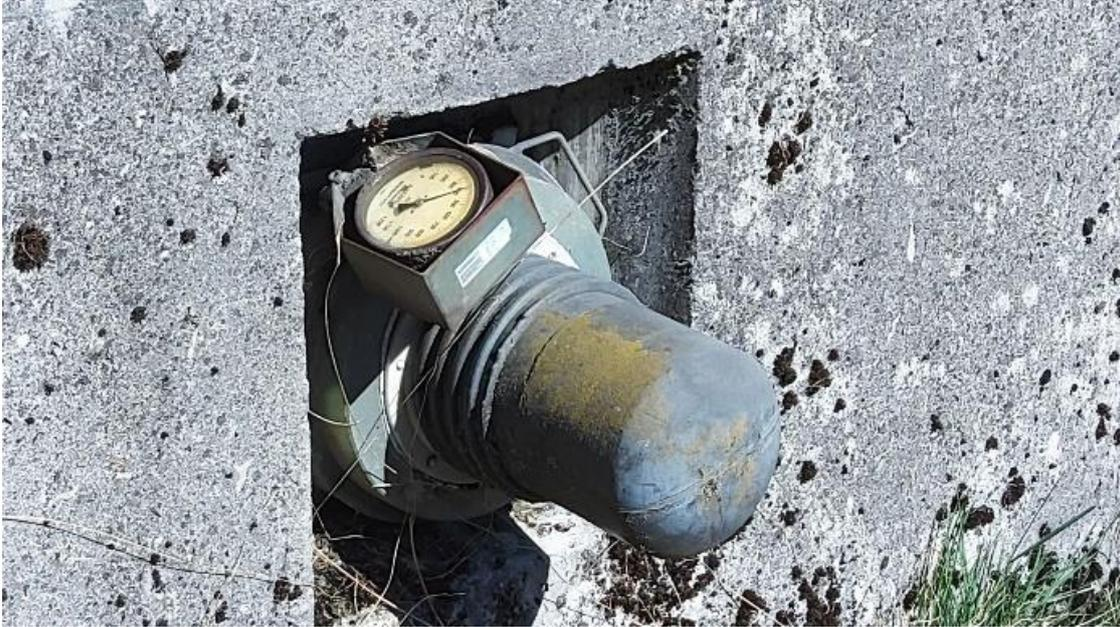
**Abbildung 7: Kraftmesseinrichtung eines vorgespannten Verpressankers**
