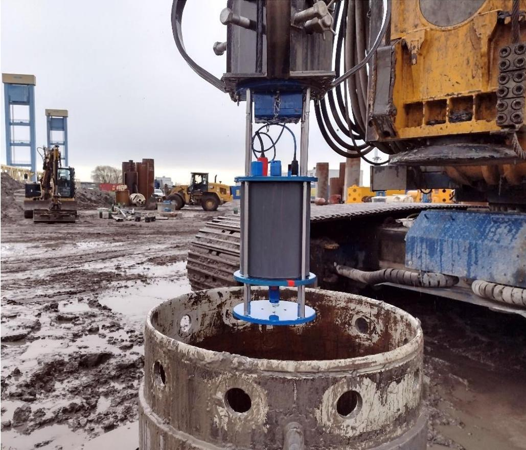
**Abbildung 6: SHAPe über dem Bohrloch an der Kelly montiert (Quelle: BBI)**
