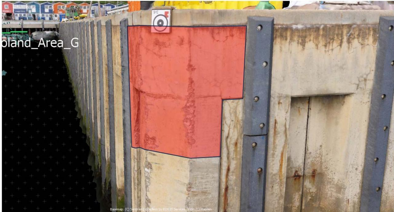
**Abb. 12: High Resolution Mesh für die Bauwerksinspektion**
