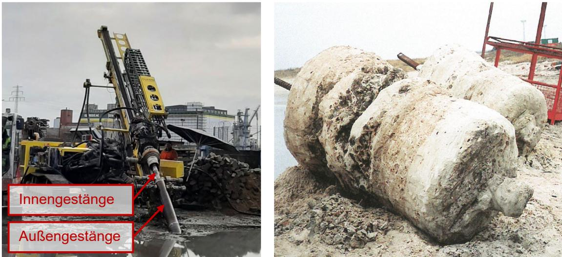
Abbildung 5: Herstellung eines geneigten Düsenstrahlkörpers am Steinwerder Kai (links) und geborgene Düsenstrahlkörper am Container Terminal III Bremerhaven (rechts) [5].
