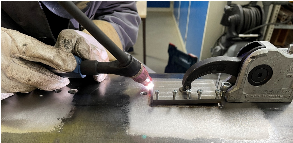
Abbildung 6-11: Anschweißen der Membran mittels WIG-Schweißverfahren
