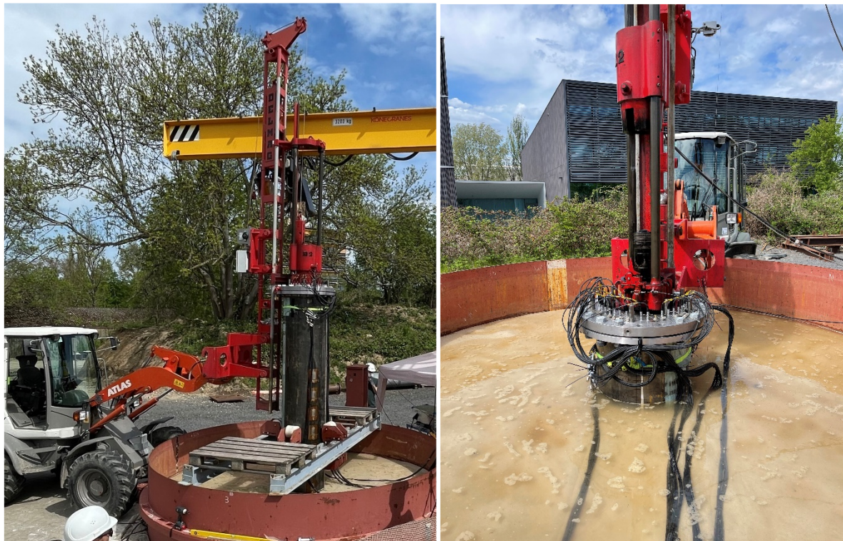
Abbildung 6-22: Installation Modellpfahl mit Delmag D2 (links mit Rammführung)
