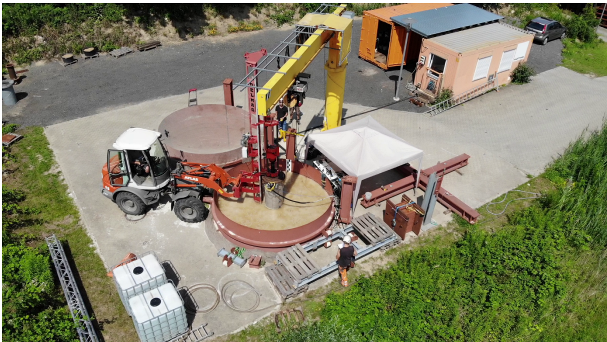
Abbildung 6-1: Geotechnischer Versuchsstand des IGG-TUBS während der Pfahlinstallation
