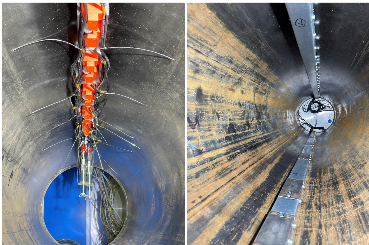
Abbildung 6-13: Befüllung Totspannungsgeber von innen (links), installiertes Cover-Profil (rechts / oben) und installierte Totspannungsgeber innen (rechts / unten)
