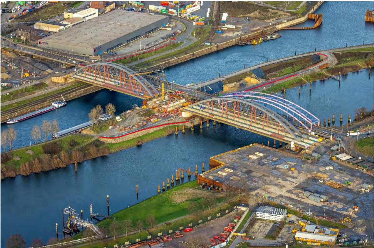
**Abbildung 10: Vormontagefläche nach Einschwimmen der Überbauten**
