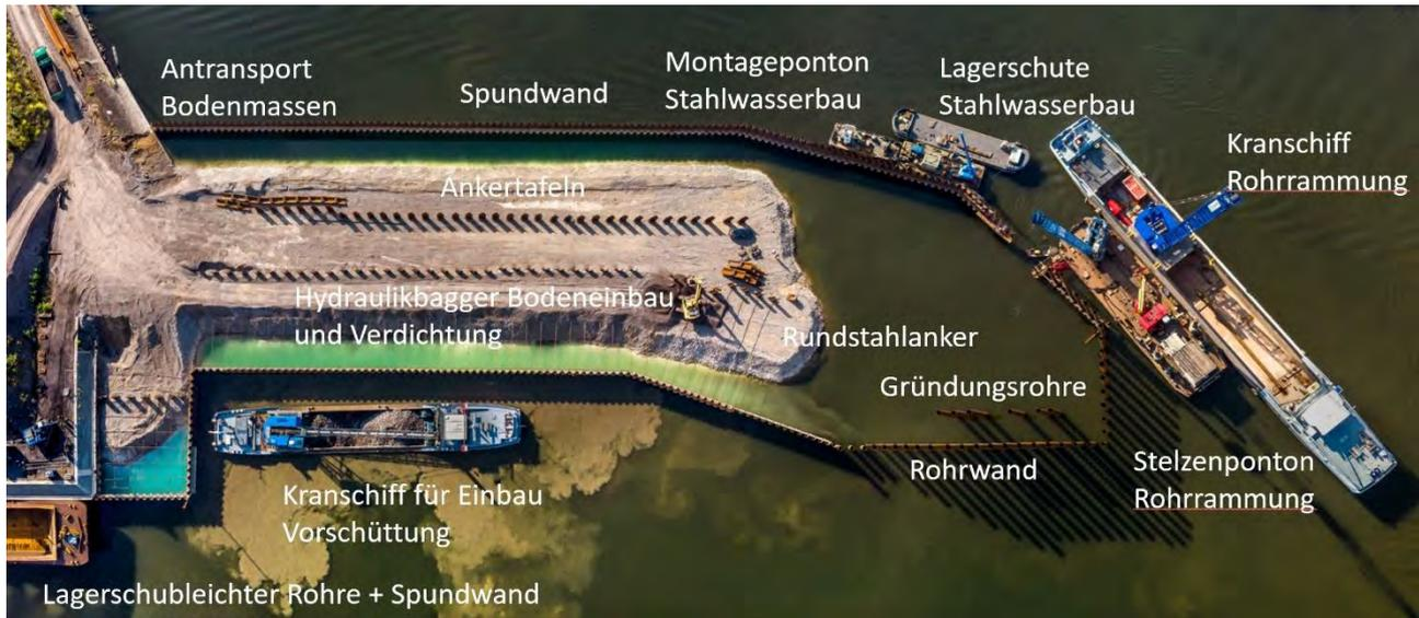
**Abbildung 11: Übersicht zu den verschiedenen Gewerken und Tätigkeiten**
