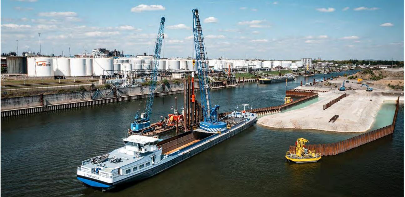
**Abbildung 6: Blick auf den teilaufgefüllten Fangedamm während der Rammarbeiten zur Rohrwand**
