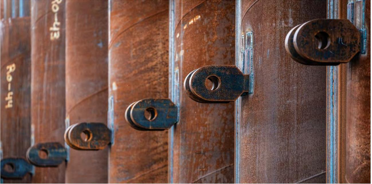
**Abbildung 8: Aufnahme für die Rückverankerungen an den Pfählen/Rohren**
