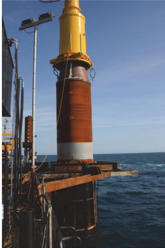
*Abbildung 1-1: Installation des Monopiles der Messstation FINO3 durch Rammung*
