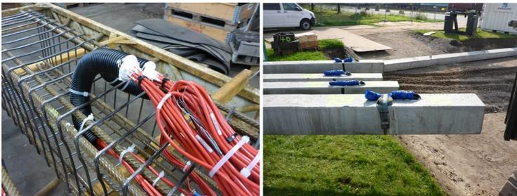
**Abbildung 13: Herausführung und Schutz Messkabel**
