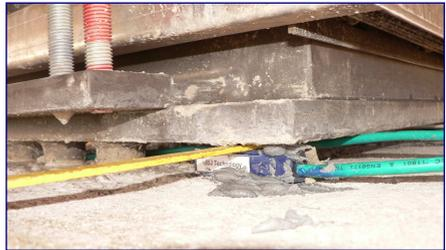
Abbildung 24: Einbau Sensor Ecklage
