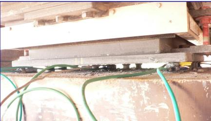
Abbildung 23: Einbau der 5 Sensoren/Lager
