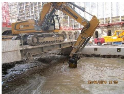
**Bild 21: Aushub der Altsubstanz unter Wasser**
