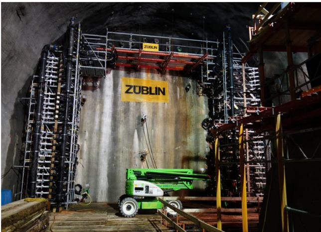
**Abbildung 10: Raumgerüst mit Soleverteiler**
