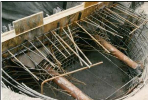
Abbildung 3 Ankerstütze Stützwand Chesa Corviglia
