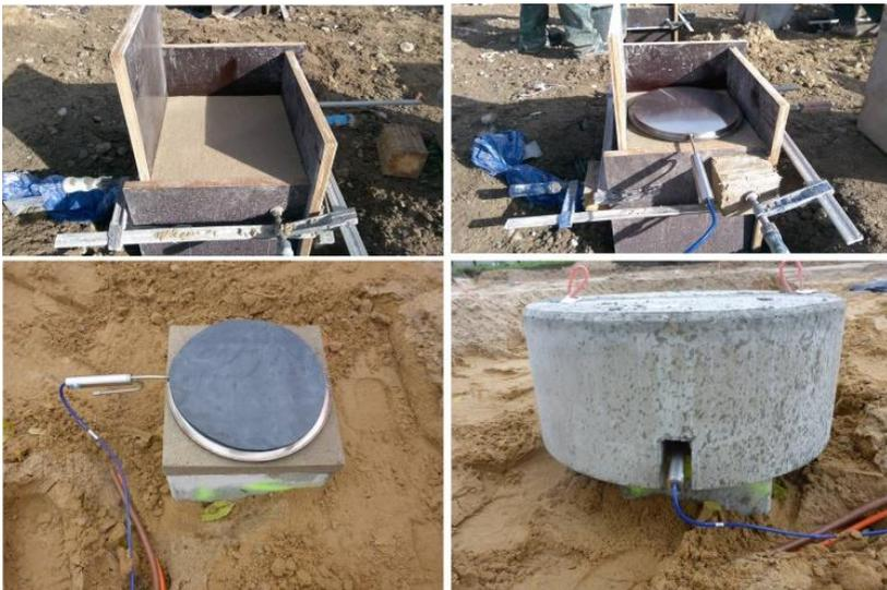
**Abbildung 11: Einbau Druckmessdosen**
