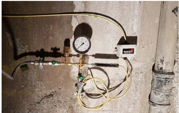
**Abbildung 8: Wasserdruckmessstelle**
