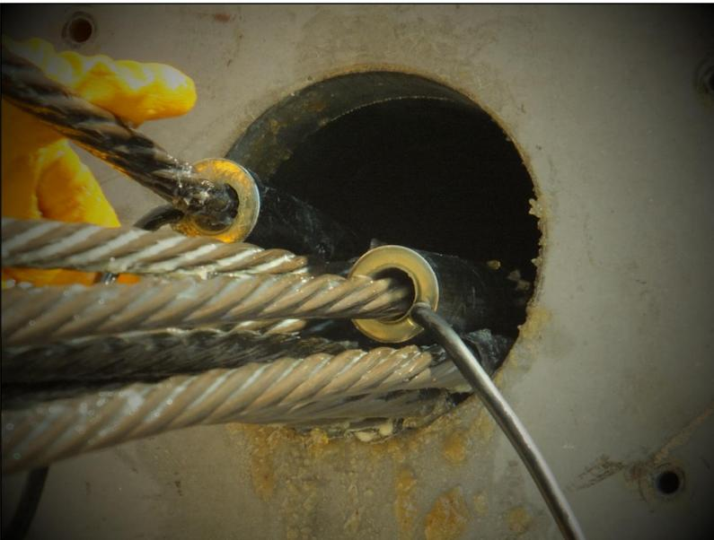
**Bild 16: Montage der DYNA Force Sensoren**
