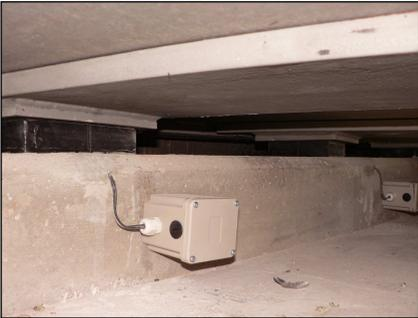
**Abbildung 15: Schutzgehäuse für Sensorstecker**
