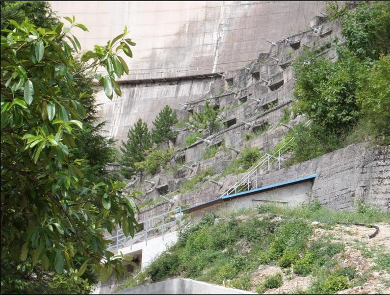
**Bild 15: Sicherung der Talsperre durch Litzenanker**
