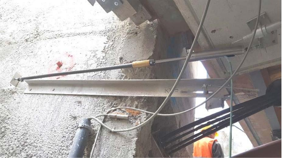
**Abbildung 7: montierter Konvergenzextensometer
