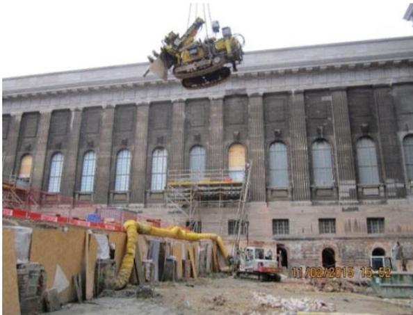
**Bild 9: Umsetzen eines Bohrgerätes mittels Turmdrehkran**
