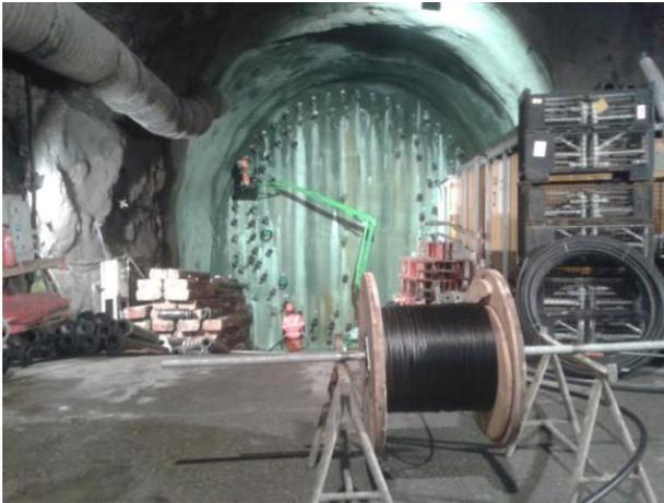
**Abbildung 13: Verlegen der Glasfaserkabel**
