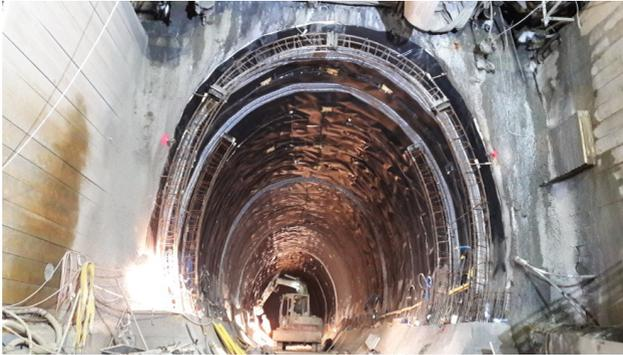
**Abbildung 12: Abdichtung und Vorbereitung der Herstellung der Innenschale**
