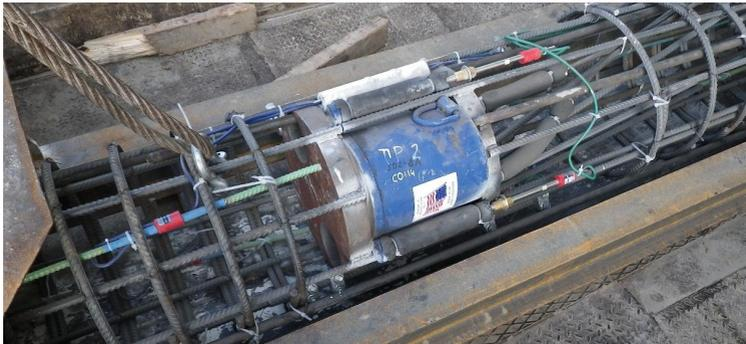
**Abbildung 7: Mit O-cell instrumentierter Bewehrungskorb**
