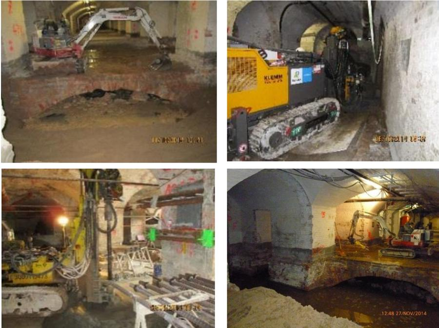
**Bild 11: Rückbau der Bodenplatte, Fundamentunterfangungen, Herstellung Mikropfähle**
