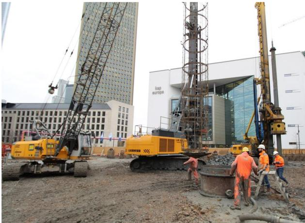
**Abbildung 7: Absetzen des instrumentierten Bewehrungskorbs**
