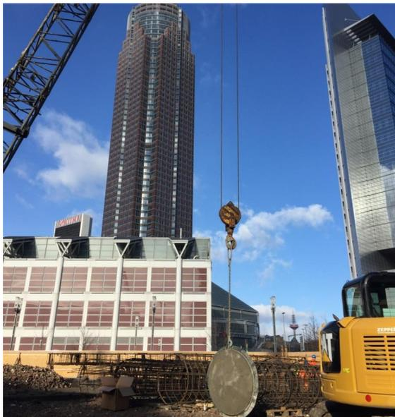
**Abbildung 6: Bewehrungskorb instrumentiert mit Kraftmessdose am Pfahlfuß**
