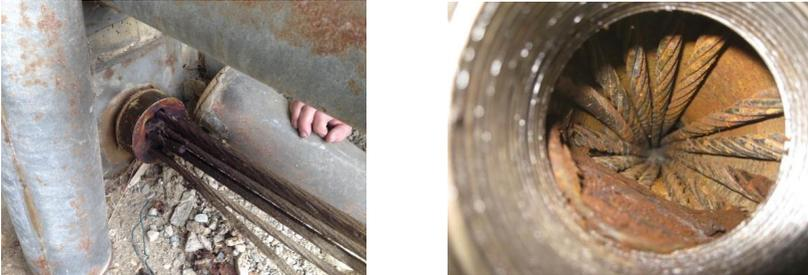
**Abbildung 4: Korrosionsschäden im Kopfbereich von Ankern; Links: Schadensbild am Ankerkopf eines Litzenankers; Rechts: Korrodierte Drähte eines Litzenankers [BURTSCHER et. al., 2017]**
