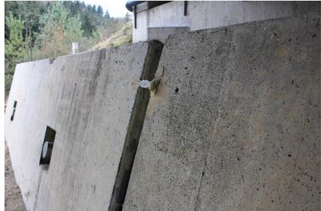
Verkipfung oder Verschiebung der Vorderseite einer Gewichtskonstruktion
