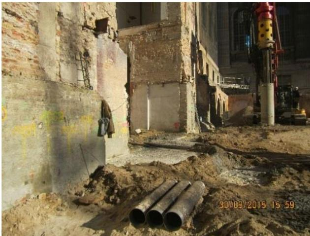
**Bild 17: Tiefenberäumung der Hindernisse mit einem Großbohrgerät**
