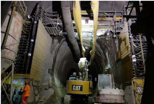
**Abbildung 11: Tunnelvortrieb aus der Kaverne**
