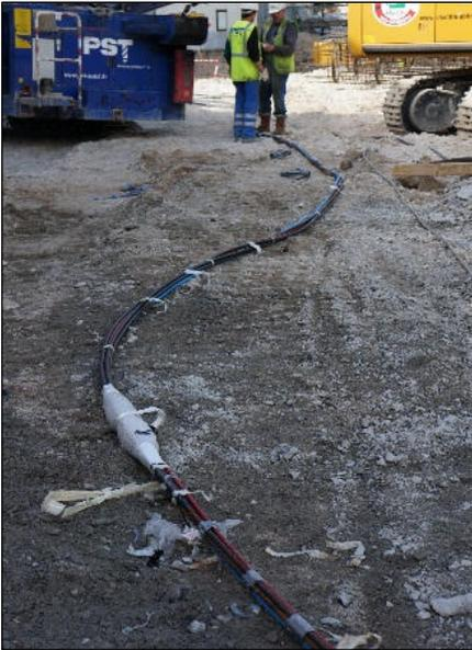
**Bild 11: Messanker vor dem Einbau ins Bohrloch**
