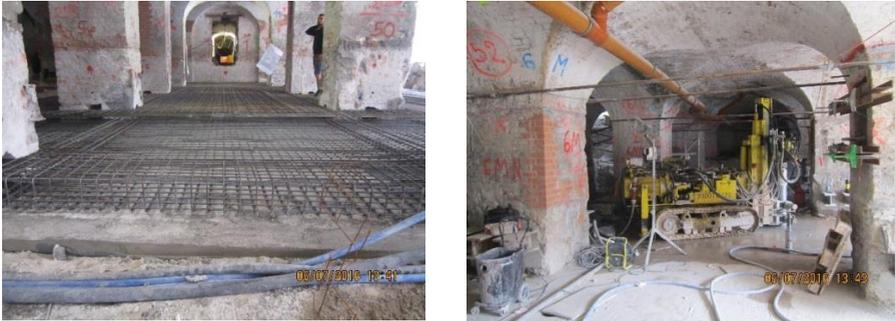
**Bild 25: Herstellung der bewehrten Sicherungssohle sowie anschließende Mikropfahlherstellung**
