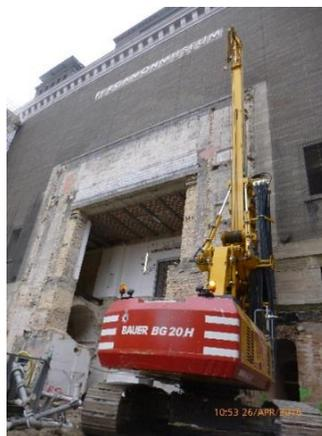
**Bild 20: Ausführung der Bohrpfehlwand unter Einsatz des Auskernbohrgerätes**
