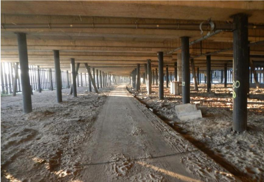
**Abbildung 2: Untersicht Bestandsbauwerk K30 - Stahlbetonüberbau auf Stahlrohrpfählen**
