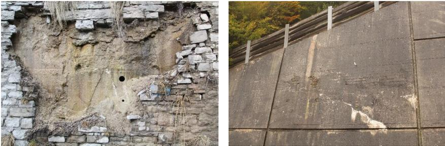
**Abbildung 3: Oberflächenschäden; Links: Abplatzungen der Vorsatzschale einer Gewichtsmauer; Rechts: Korrosionsschäden an der Oberflächenbewehrung und Betonabplatzungen**
