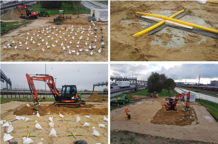
**Abbildung 10: Einbau hydrostatische Linienvermessung**
