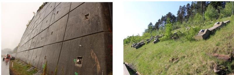
**Abbildung 5: Links: Kleinteilige, geankerte Konstruktionen; Rechts: Ankerbalken**
