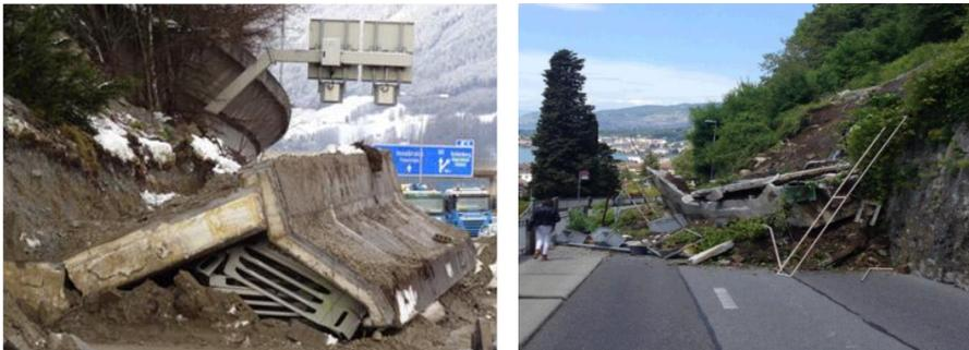
Abbildung 1: Schadensfälle an Stützbauwerken; Links: Verbruch einer Winkelstützmauer an der A13 Brennerautobahn [MARTE et. al., 2014]; Rechts: Einsturz einer Stützmauer bei Glion [OPAN E., 2017]
