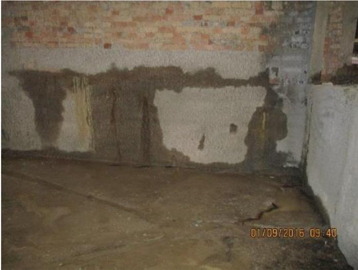
**Bild 12: Stark durchlässige Bestandsfundamente**
