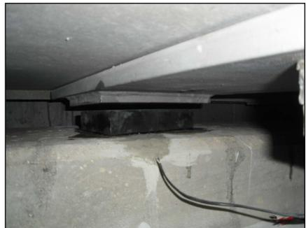
**Abbildung 14: Elastomerlager eingesetzt**
