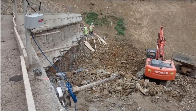
Abbildung 1: Verankerung, Ankerkraftmessgeber und Wireless-Datenlogger
