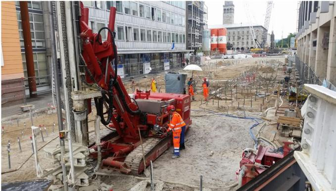
**Abb. 4: Parallele Bohr- und Injektionsarbeiten**
