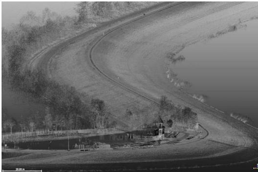
**Abbildung 12: Vergrößerte Ansicht der Punktwolke des östlichen Hauptbeckendamms**
