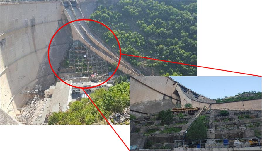
**Abbildung 11: gesicherter Felshang mit vorgespannten Ankern**
