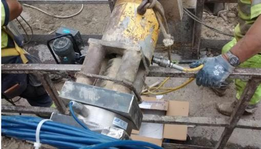
**Abbildung 3: Vorspannung eines Ankers mit Ankerkraftmessgeber**
