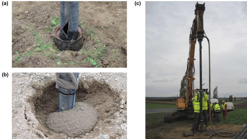
**Abbildung 2: (a) Rammschuh (Fußkappe) mit angesetztem, erstem Rohrschuss und Betonaustrittsöffnung, (b) Detailaufnahme des Pfahls ( $\varnothing$  118 mm) mit umgebenden Verpressgut (Betonmörtel) und installiertem faseroptischem Sensorkabel, (c) Pfahl im Zuge der Herstellung**
