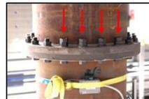
**Abbildung 6: Auswirkung von gelockerten Schrauben am Flansch**
