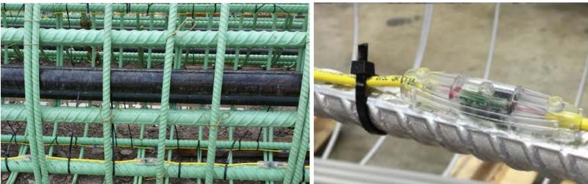
**Abbildung 5: Thermal Wire® an der Bewehrung**
