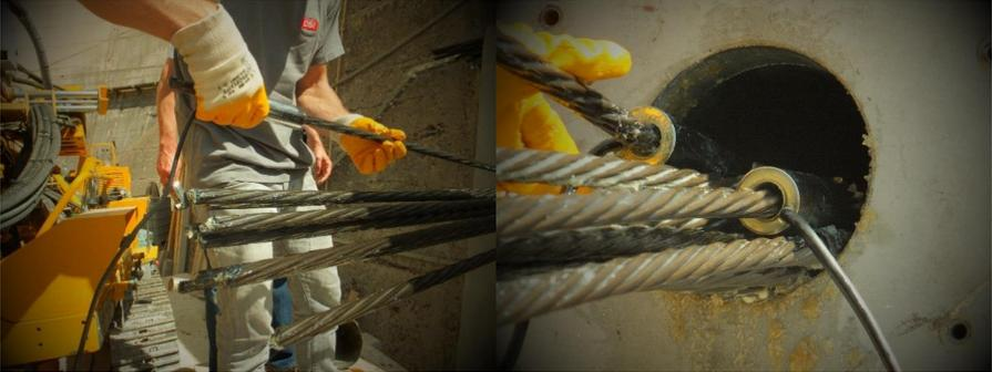
**Abbildung 12: Einbringen der DYNA Force® Sensoren auf die Litzen**
