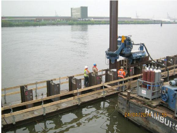
**Abbildung 18: Einbau der Füllbohlen mittels Presse**
