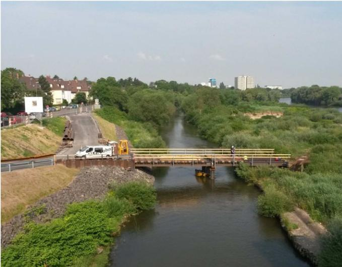
**Abbildung 17: Montage des Fahrbahnbelags aus Baggermatrazen (Bongossi)**
