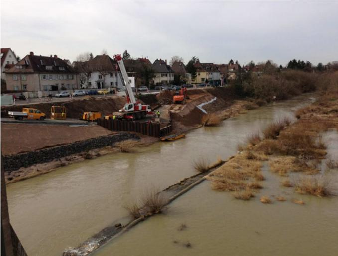
**Abbildung 14: Herstellung des Brückenwiderlagers als rückverankerte Spundwand
