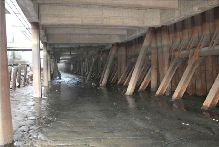
**Abbildung 2: Vorgesetzte HWS-Anlage am Verladepier der Fa. GTH.**
