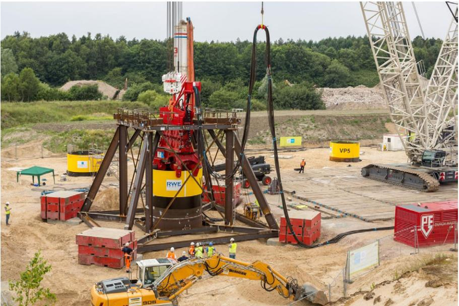
Abbildung 3: Einbringen der Rohre
