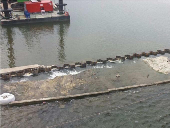
Abbildung 23: Eingebaute Spundwand
