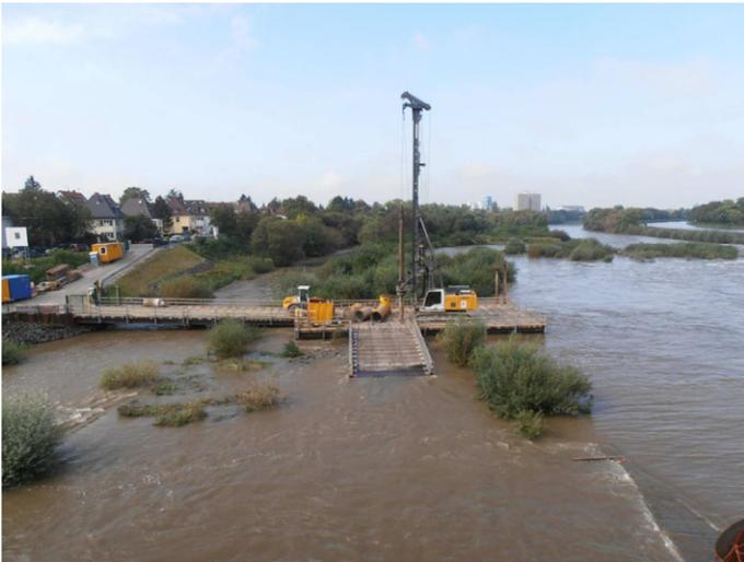
**Abbildung 19: Fertiggestellte Brücke, Verladeplattform und Abfahrtsrampe**
