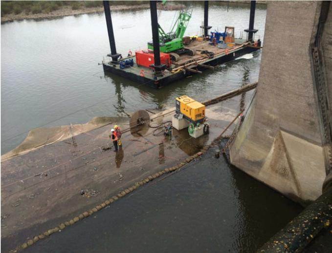
Abbildung 22: Sägeschnitte im Beton zur Erstellung des Rammgrabens
