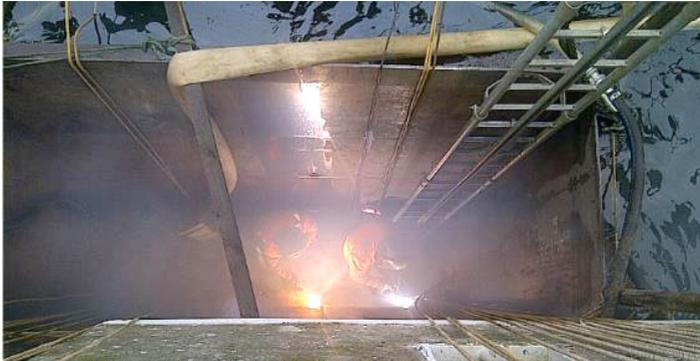
**Abbildung 16: Schweißer im Caisson bei der Arbeit [RALF KRÖGER, TAUCHER KNOTH, 2013]**
