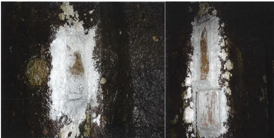
**Abb. 14: Mittels UW-Metal® applizierte Stahlbleche**
