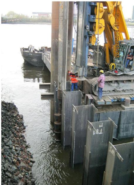
**Abbildung 19: Geräteeinheit für Lockerungsbohrungen im Bereich der Füllbohlen**
