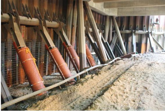
**Abbildung 8: Spundwand- und Pfahlverstärkungen durch Einschweißen von Stahlträgern.**
