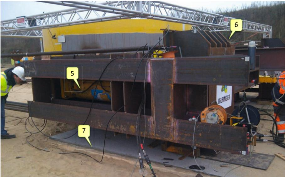
**Abbildung 11; Blick auf die Traverse mit den Hydraulikzylindern**
