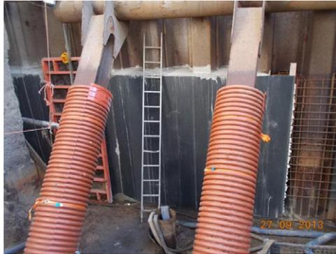
**Abbildung 7: Einbetonieren der Stahlkonstruktion von NN -0,1m bis NN -2,9m.**
