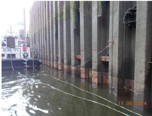
**Abbildung 6: Wasserseitige Spundwandabdichtung durch aufgeschraubte Stahlbleche.**
