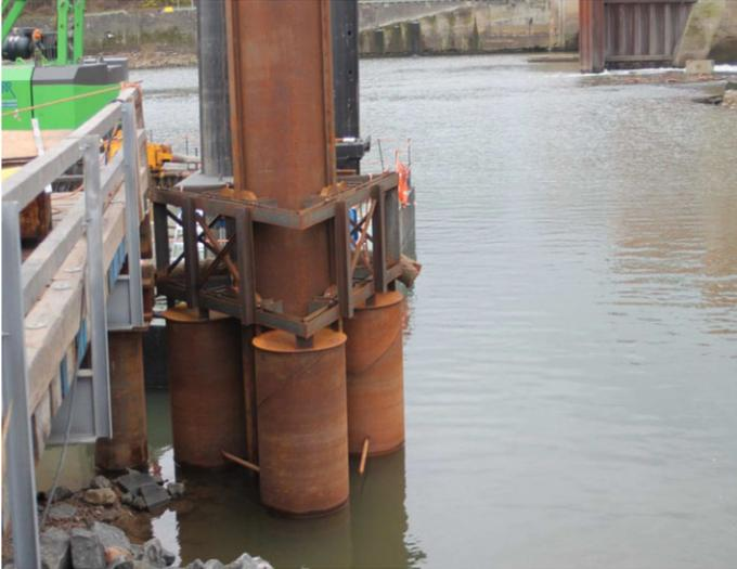
**Abbildung 20: Vertäudalben mit Schwimmpollern an der Verladeplattform und an der Trennmauer**
