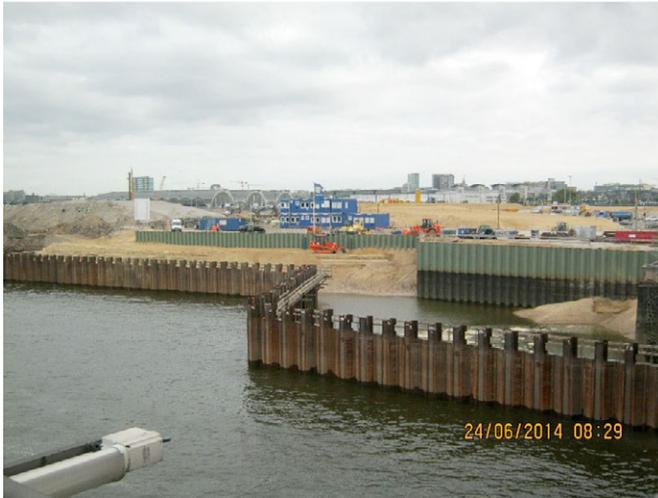
**Abbildung 20: Fertiggestellte kombinierte Spundwand**
