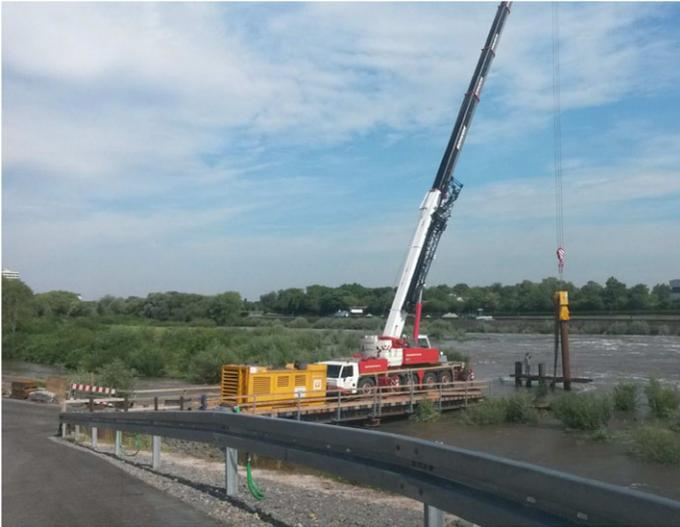
**Abbildung 18: Herstellung der Gründung der Verladeplattform mit Stahlrammpfählen**
