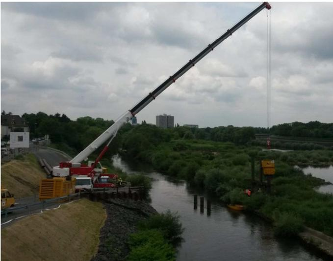
**Abbildung 15: Herstellen der Brückengründung mit Stahlrammpfählen**
