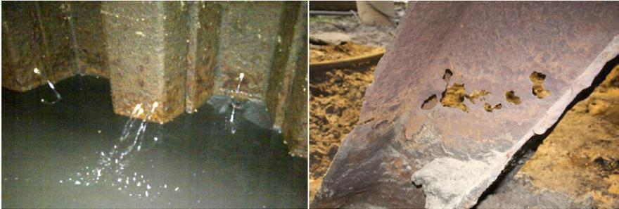
**Abbildung 4: Links: Spundwandkorrosion mit tlw. vollständiger Durchrostung. Rechts: Durchrostung eines Rückverankerungspfahls. Höhenlage der Korrosion bei ca. NN -1,5m.**
