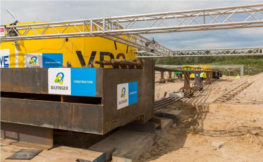
**Abbildung 12: Quertraverse Widerlagerseite**
