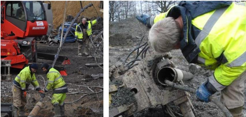
Abbildung 7: Einführen des Stahltraggliebes und einfüllen von Zementleim
