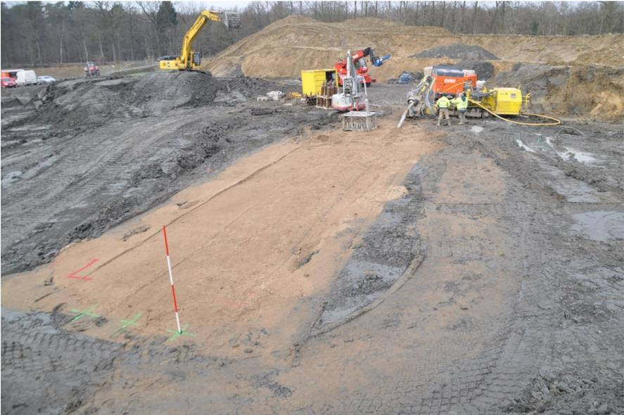
Abbildung 5: Bohrarbeiten in – Sand / Kies und Ton
