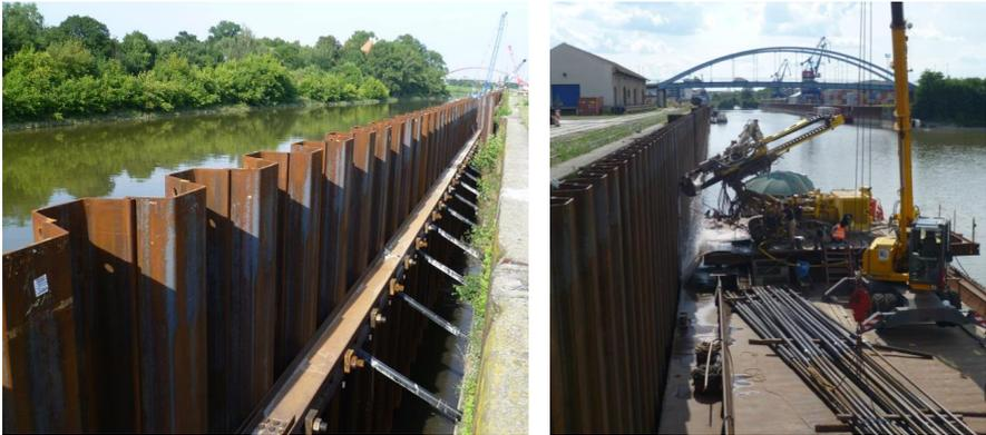
Abbildung 15: Uferwand Hafen Riesa mit TK-ASF Bohrverpresspfahl
