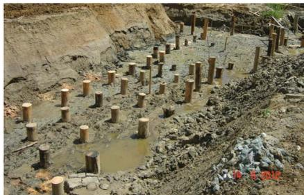
Abbildung 13: Ausgeführte Fundierung aus Holzpfählen (Durchlassbauwerk Zickenbach)
