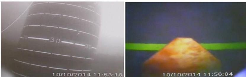
Abbildung 11: Monitoring der Rammung durch UW Kameras
