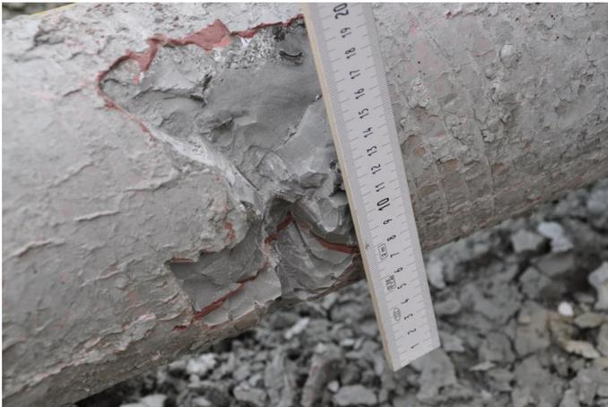
Abbildung 11: Nachinjektion im bindigen Boden
