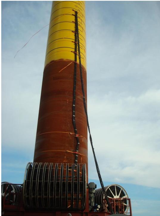
Abbildung 3: Vom Bauunternehmen ausgeführte Kabelführung während der Rammung
