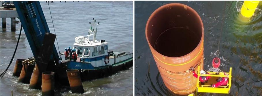
Abbildung 4: Zugänglichkeit des Pfahls für die Montage von Sensoren beim Nachrammen
