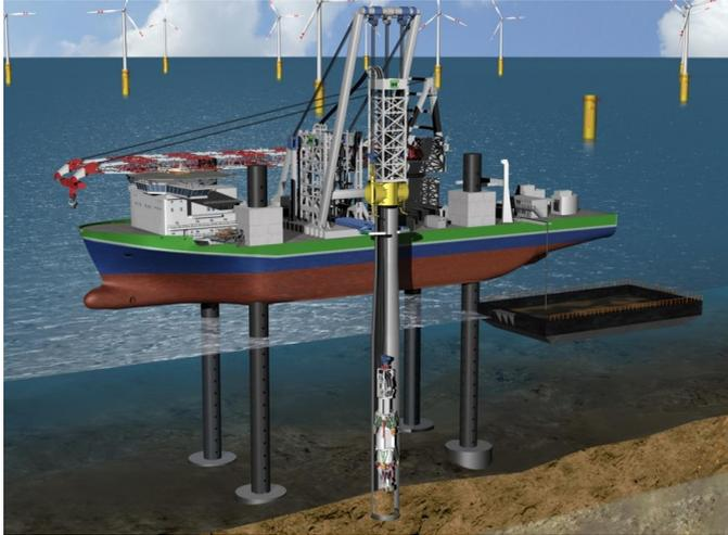
Abbildung 5: Abgelassene Maschine im Pfahl
