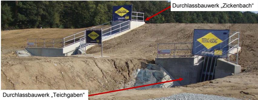
Abbildung 1: Fertiggestellte Durchlassbauwerke des Rückhaltebeckens
