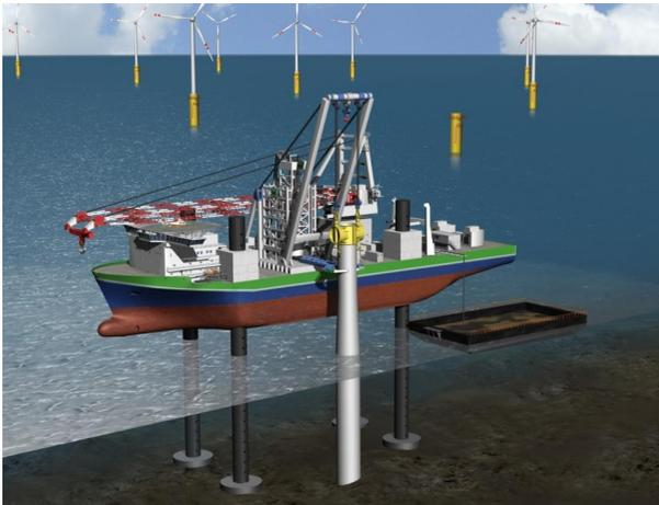
Abbildung 4: Abgesetzter Monopfahl
