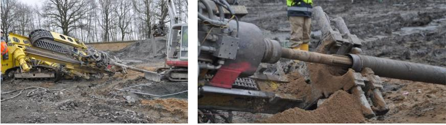
Abbildung 6: Bohrarbeiten mit Klemm KR 806-4, Bohrwinkel 10°;
