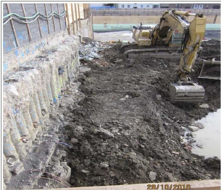
Abbildung 3: Aushub nach Bohren u. Einbau der 1. Ankerlage
