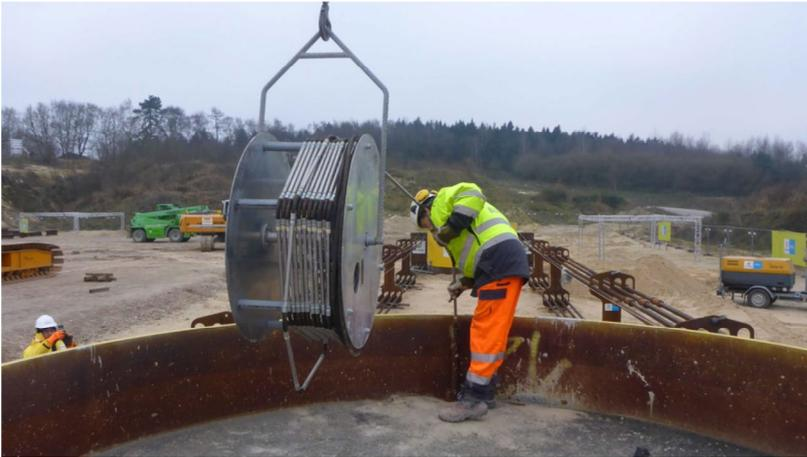
Abbildung 15: Einbau des 50 m langen SAA-Ketteninklinometer
