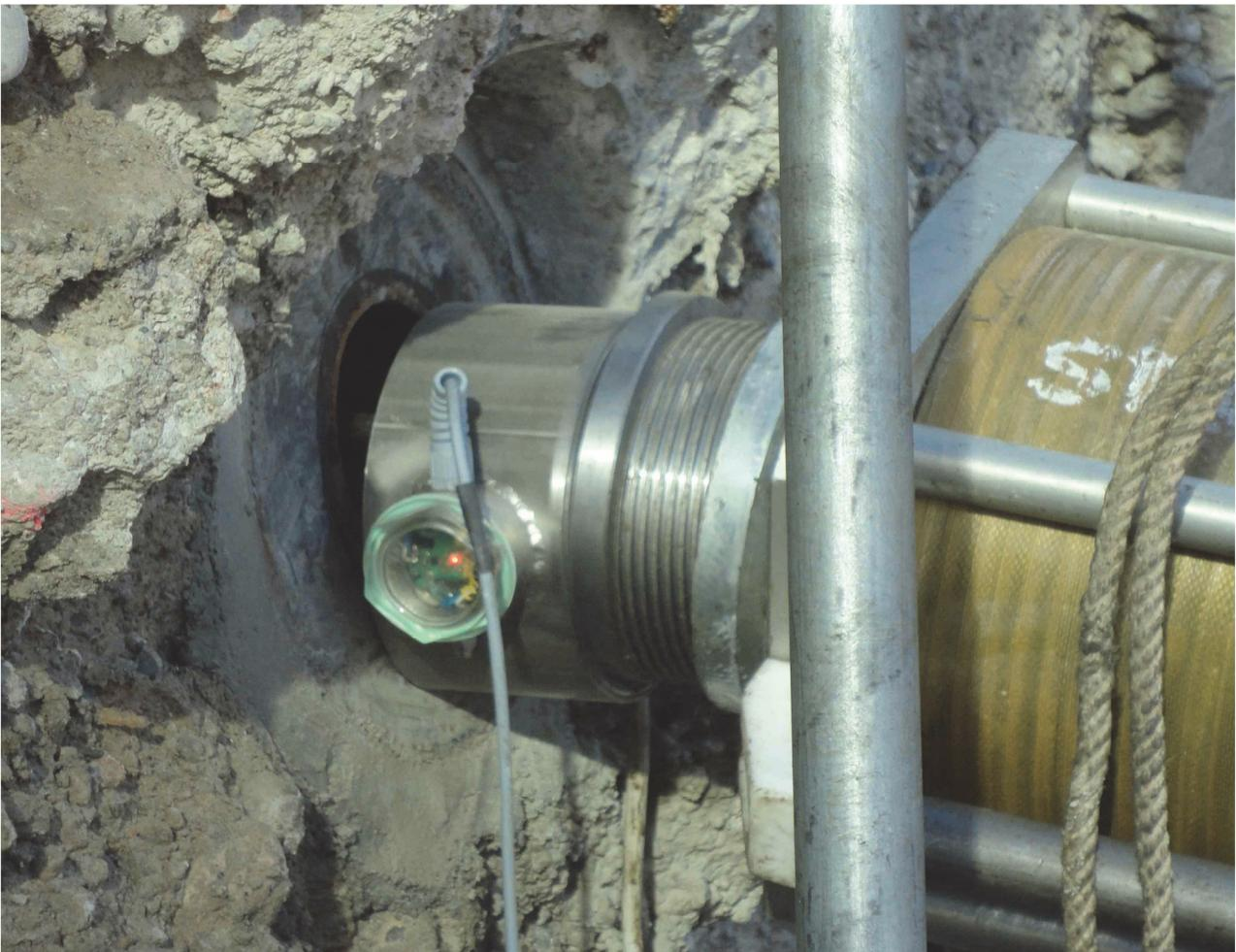
**Abb. 12: B-KMD-1200 beim Einbau mit Unterlast (rote LED)**
