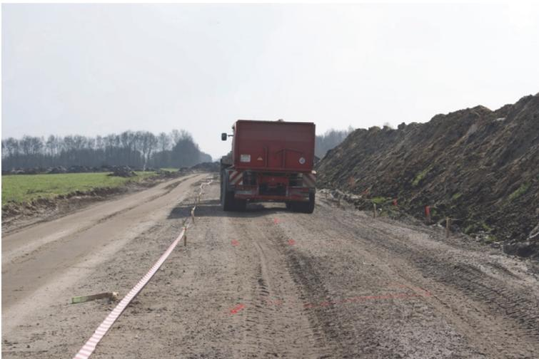
Abbildung 5: Ausgebildete Fahrspuren ohne signifikanten Einfluss auf die Nutzbarkeit
