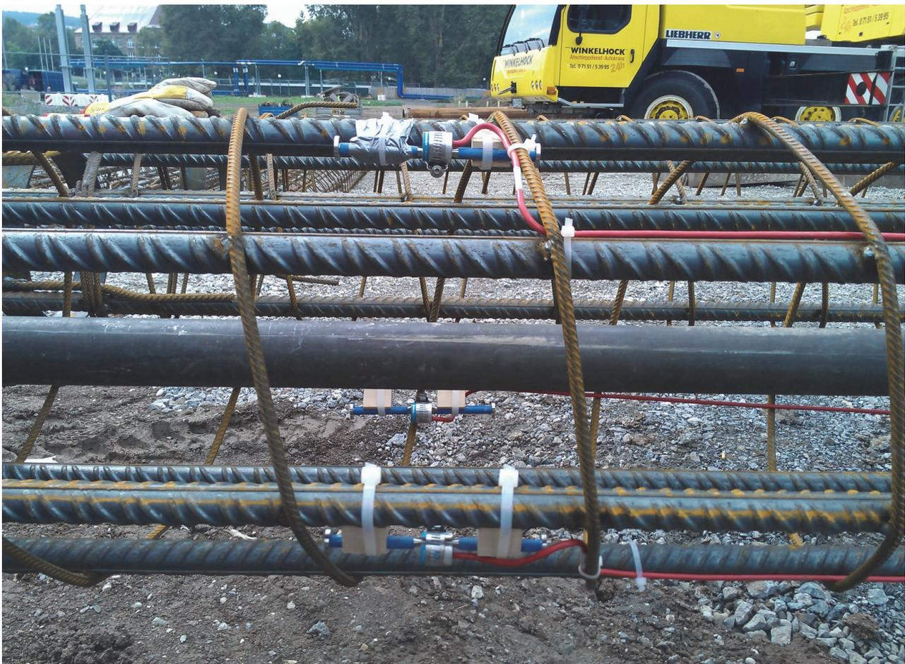
Bild 8: Bewehrungskorb mit Dehnungsaufnehmern
