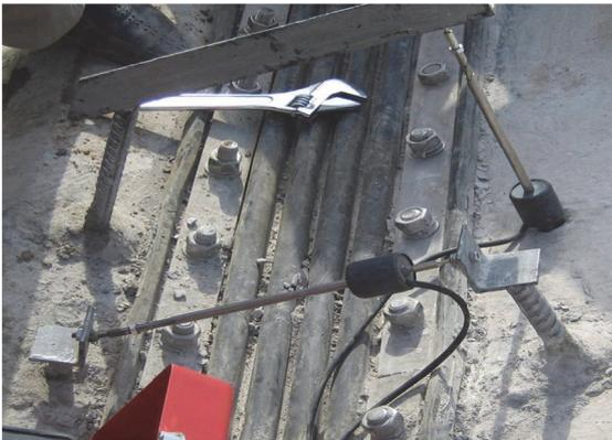
Abbildung 5: Einbau von Fugenspaltensensoren (Richtung 2JM1-a und 2JM1-c) an der Fuge zwischen Gründungsplatte und Betonoberflächendichtung
