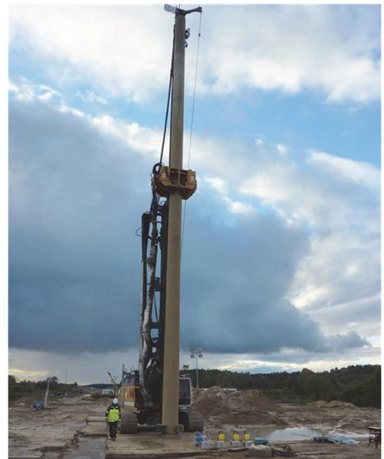
Abb. 5.8: Hydrostatische Linienvermessung der Messebenen nach dem Ziehen des 30 m langen Verdrängungsrohres
