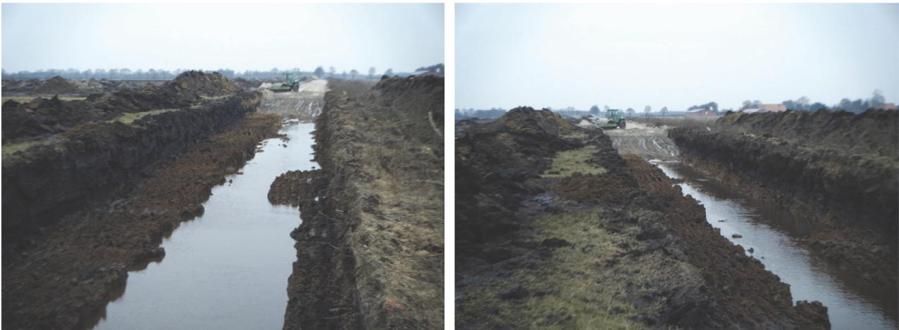
Abbildung 1: Ausgeführtes Bodenersatzverfahren für die Hauptzugangswege zum Windpark
