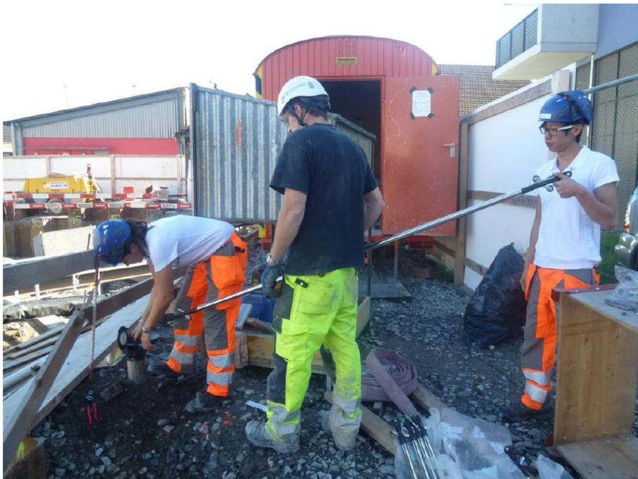
**Abbildung 11 Installation einer Inklinometer-Messkette**
