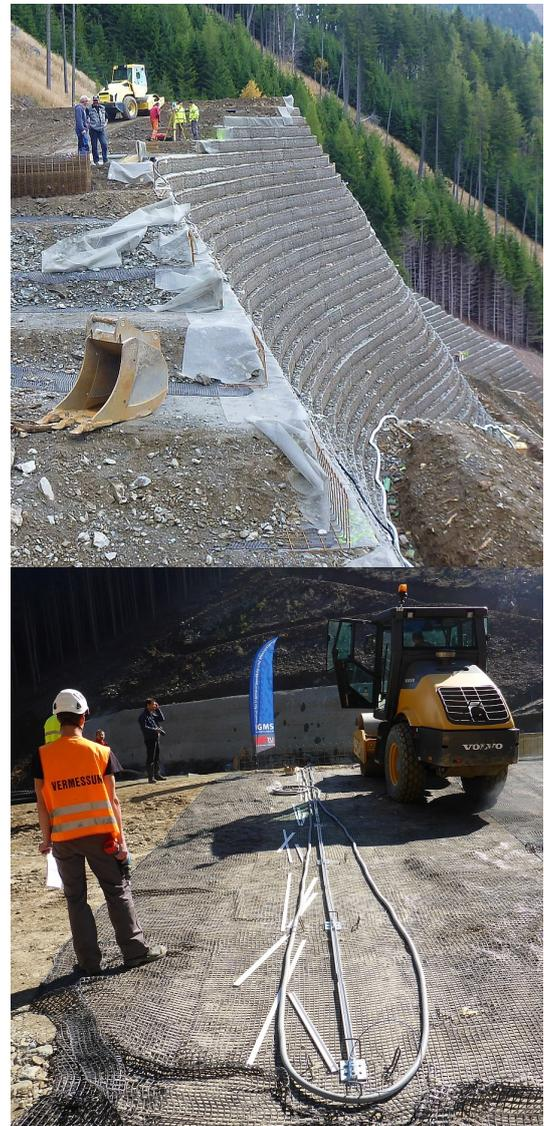
Abb. 1: Bewehrte-Erde-Stützkonstruktionen mit faseroptischem Messsystem
