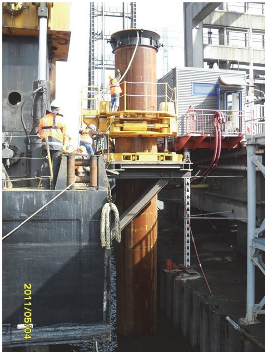
**Abb. 10: Einbau der Baugrubenelemente in abgeteufte Bohrungen direkt neben dem bestehenden Widerlager**
