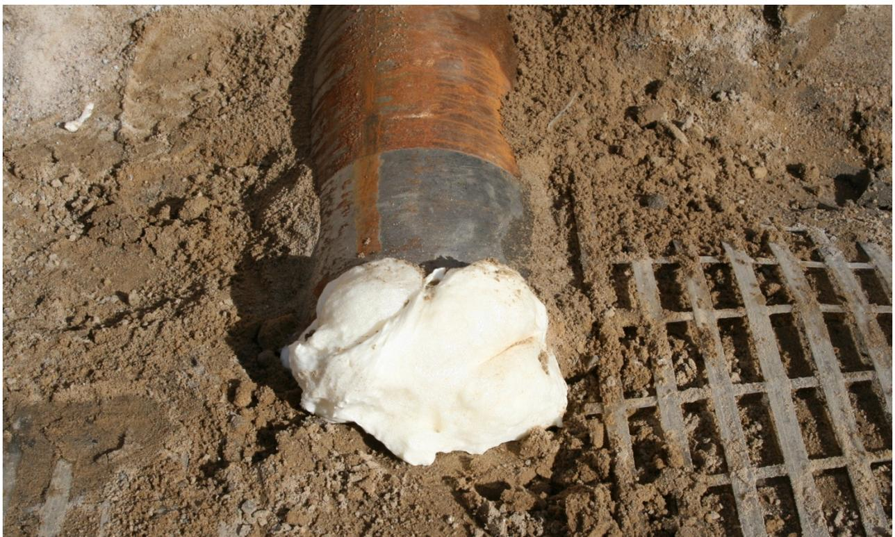
Abb. 12: Verdämmtes Schutzrohr vor Neuverfüllung
