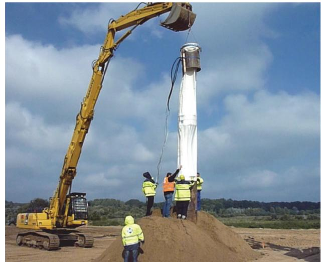
Abb.5.5: (Bild links) Umfangsmessung mit Seilzugsensoren auf mehreren Ebenen des GEC
