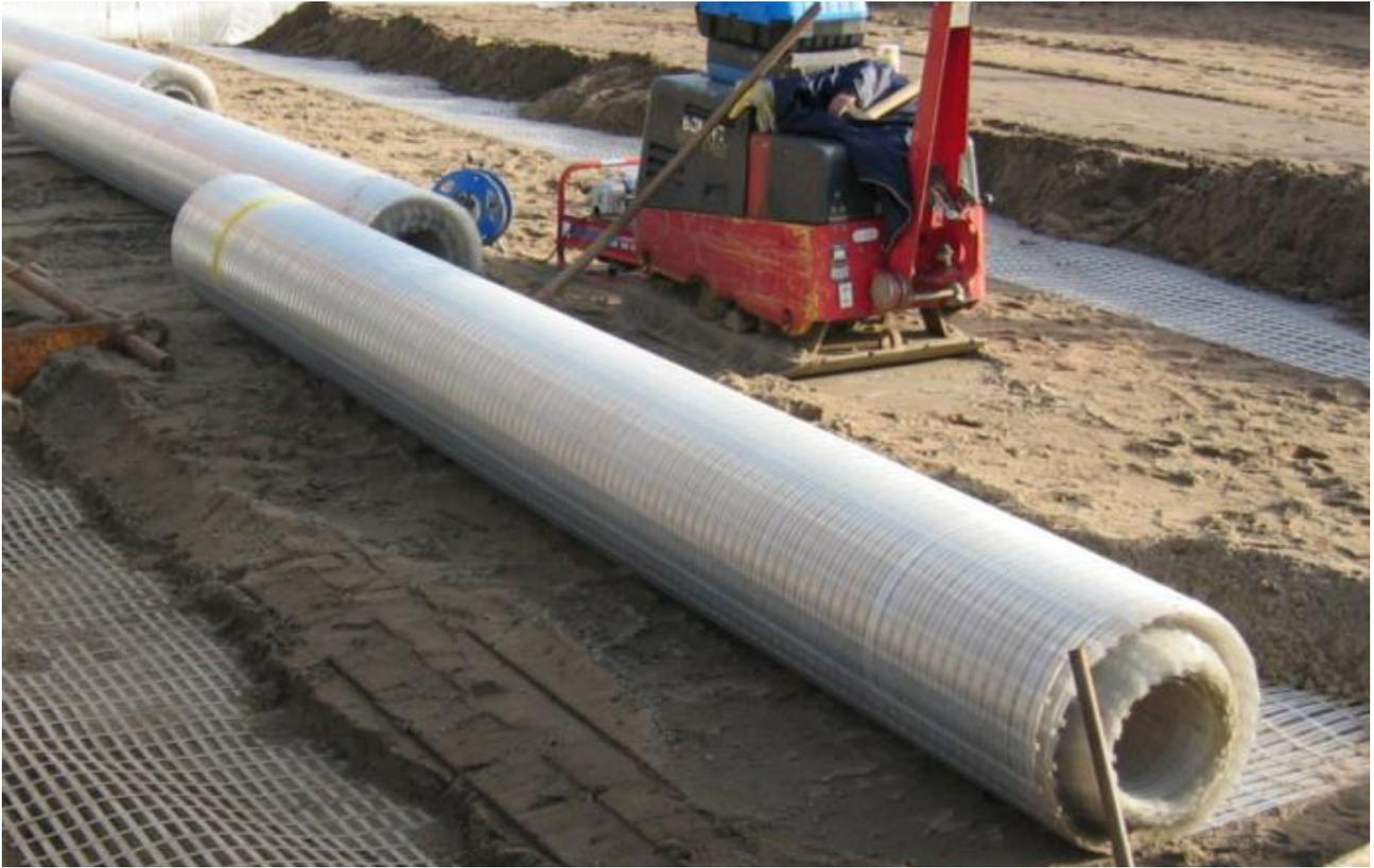
Abb. 5: Einbau der mittleren Geogitterlage zur Längsbewehrung
