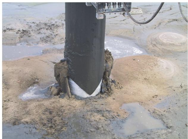
Abb. 4.2: Herstellung mit dem Verdrängungsverfahren
