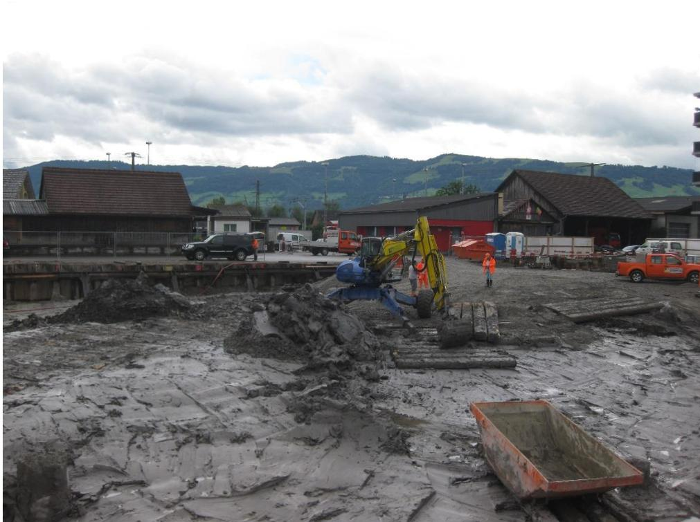
**Abbildung 10 Aushubarbeiten mit sehr leichten Geräten**
