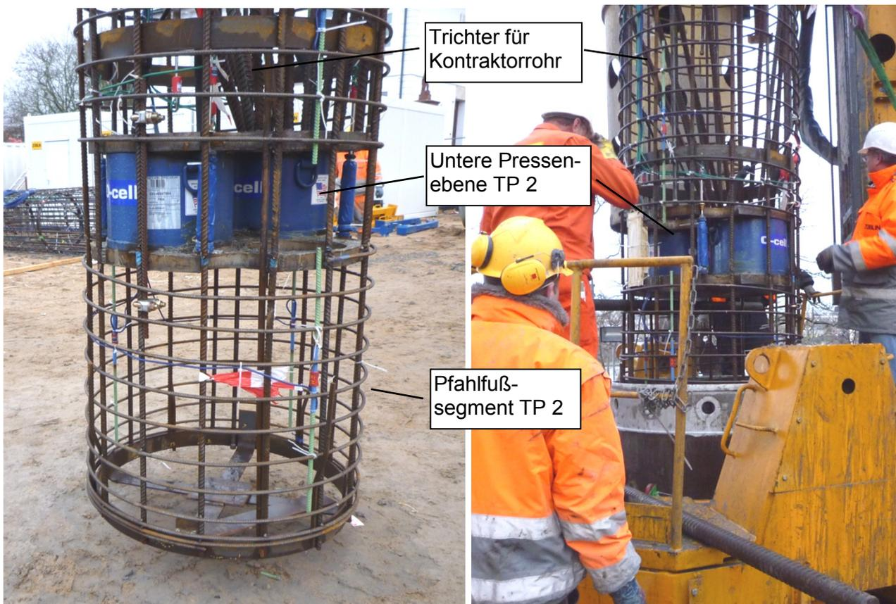
Abb. 6: Instrumentierter Probepfahl TP 2, untere Pressenebene und Fußsegment, kurz vor (links) und während des Einbaus (rechts)
