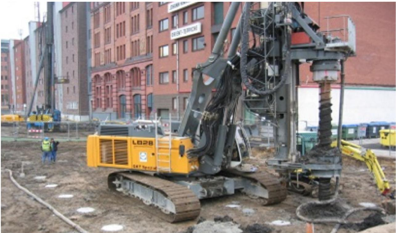
Abb. 3: Herstellung der Teilverdrängungsbohrpfähle (Quelle: WEIHRACH ET AL. (2010))
