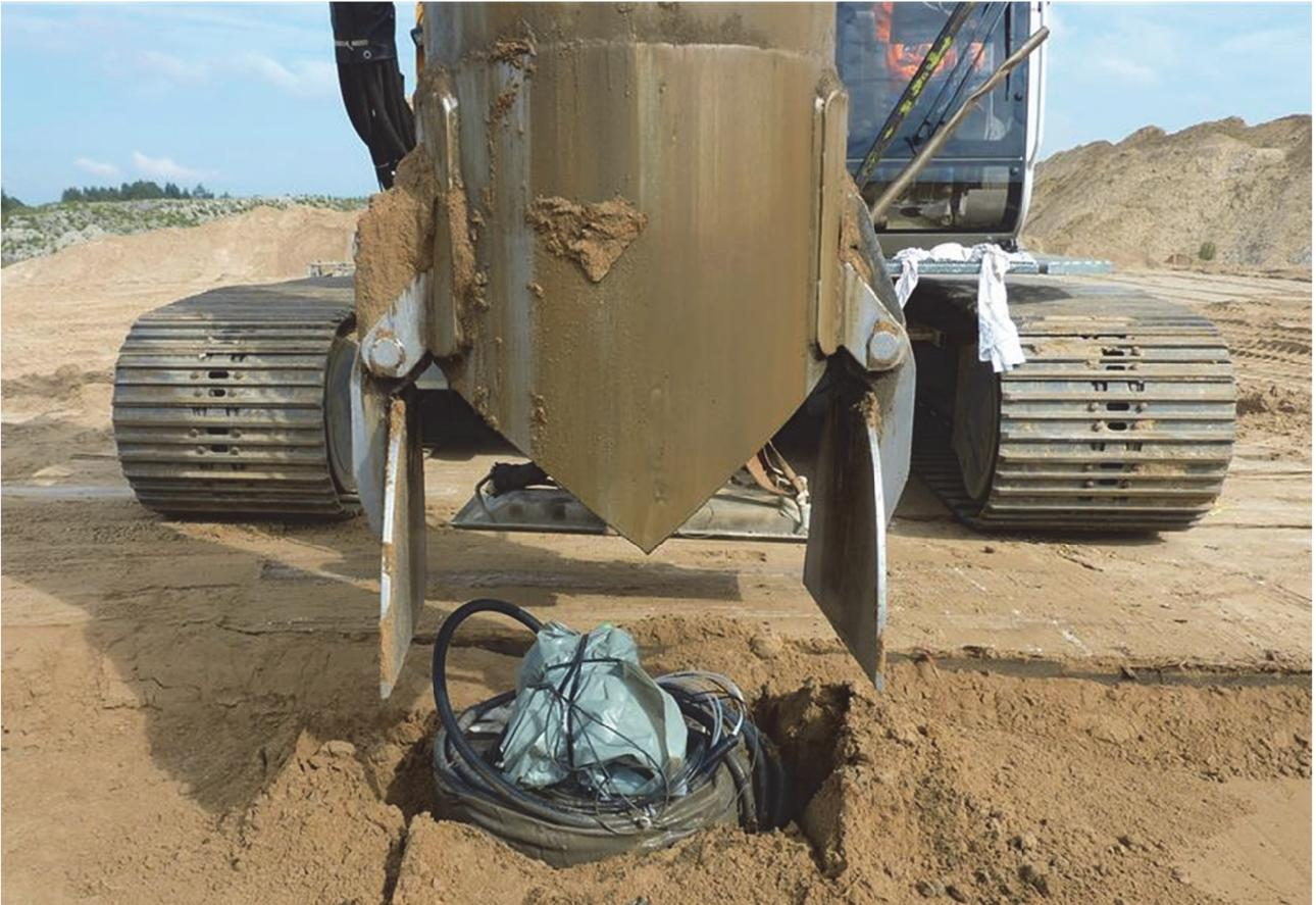
Abb. 5.7: Kontinuierliche Erfassung des Säulenumfangs aller Messebenen auch während des Ziehens des Verdrängungsrohres
