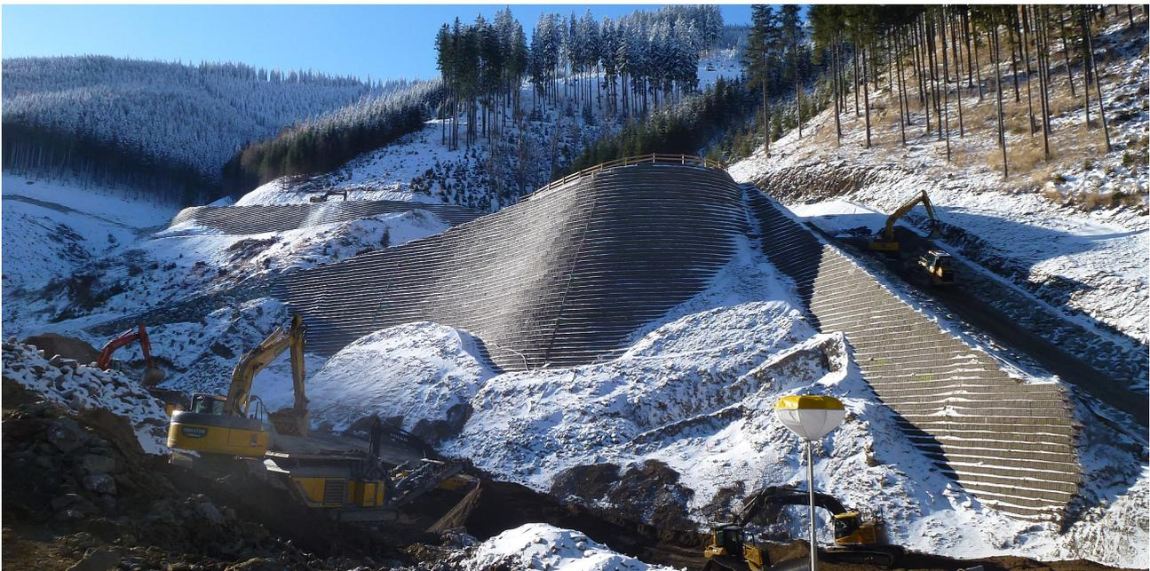
Abb. 4: Bewehrte-Erde-Stützkonstruktionen – Bachverlegung in die Talflanke (links hinten), Auffahrtsrampe (Mitte) und Steilstück der Bachverlegung (rechts vorne)
