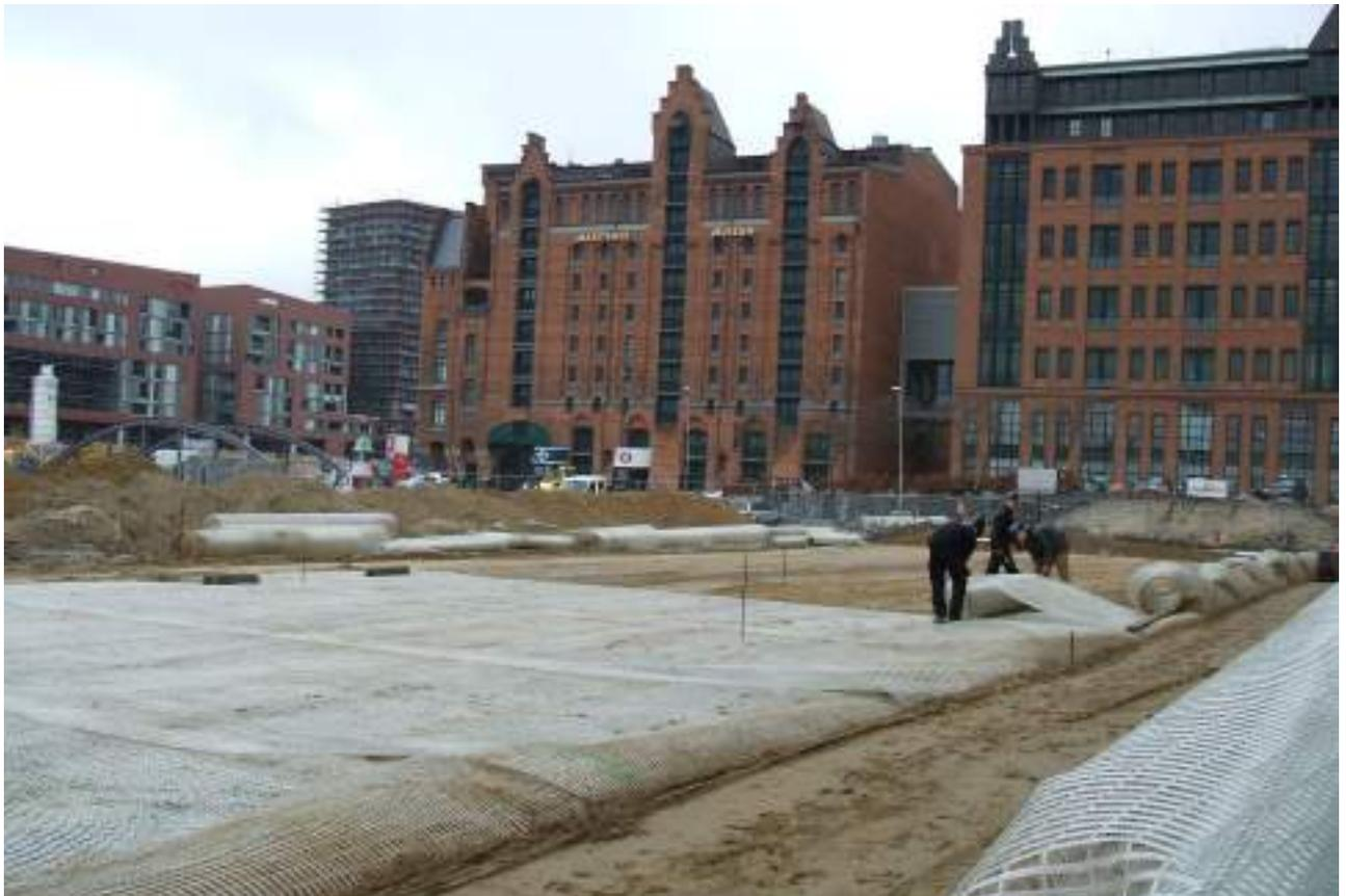
Abb. 6: Schließen des Querbewehrungspolsters durch Einlegen der oberen Lage
