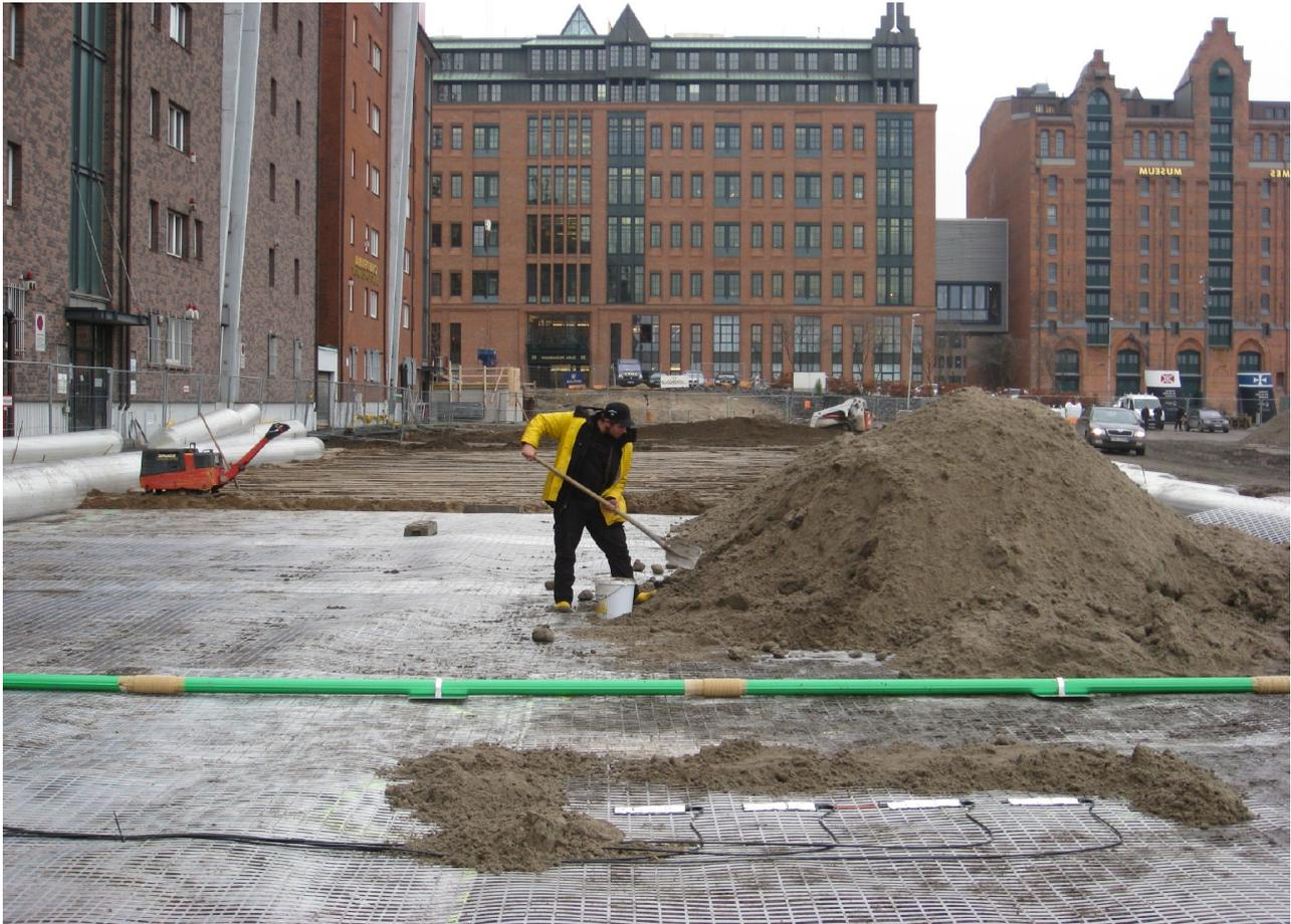
Abb. 10: Lage des Inklinometerkanals auf OK der unteren Querbewehrungslage
