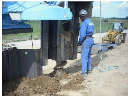
Abbildung 7: Crush Piler, Spundbohle eingefädelt, Schnecke gräbt sich im Spundwandtal in das Erdreich
