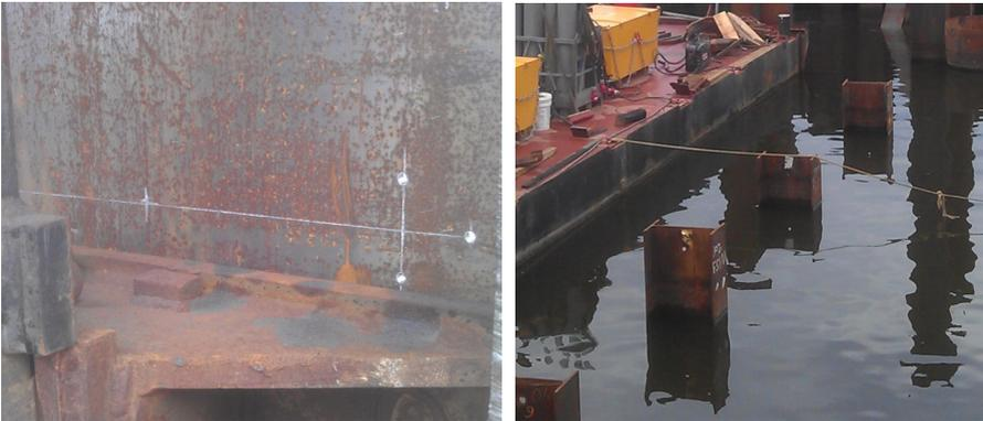
Abbildung 3: werkseitige Bohrungen an einer Tragbohle (links),
