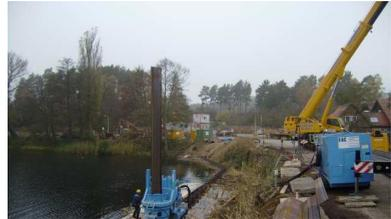
Abbildung 8: Spundwandpresse auf dem Wasser, Aggregat und Hebegerät landseitig
