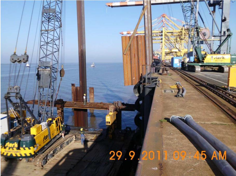
Abbildung 12: Parallel arbeitende Seilbagger an der Kaje
