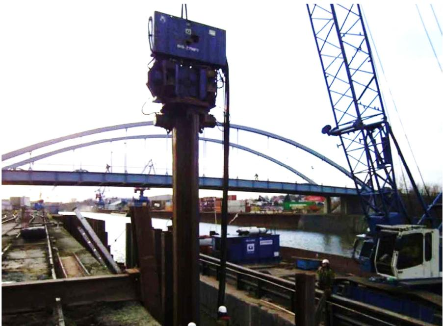
Abbildung 8 Einsatz des Vibrators
