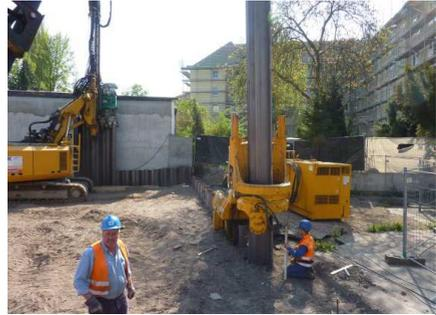
Abbildung 10: Mäklergeführte Spundwandpresse dicht am Gebäude, selbstschreitende Spundwandpresse im Vordergrund
