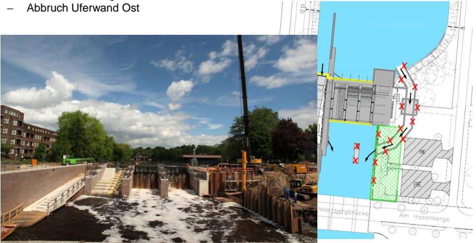
**Abbildung 12** Skizzierte Bauphase 6 und Bild „Einbau Uferwand Ost“
