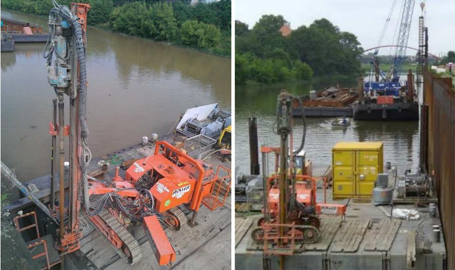
Abbildung 10 und 11 Bohrgerät für Sprenglöcher / Bohrarbeiten für die Sprengungen und Nachschlagen der Bohlen
