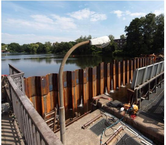
**Abbildung 8** Skizzierte Bauphase 2 und Bild der nördliche Spundwand
