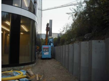
Abbildung 12: Geringe Arbeitsbreite, Hydraulikaggregat zwischen neuer Spundwand, Spundbohlen werden vom Hydraulikbagger mit Sortiergreifer auf der anderen Seite zugereicht
