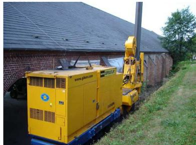
Abbildung 9: Spundwandpresse mit Aggregat auf der Spundwand, Hebegerät auf anderer Gebäudeseite
