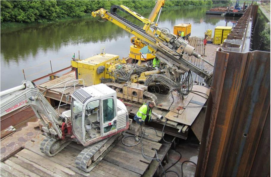
Abbildung 23 und 24 Pfahlbohrarbeiten
