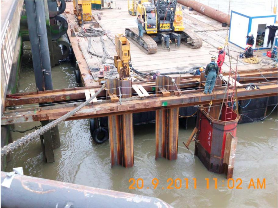
Abbildung 9: Ansetzen des Taucherfahrstuhls an DB
