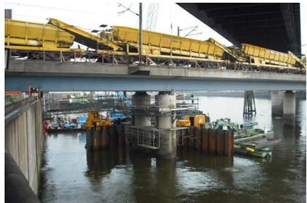
Abbildung 11: Spundwandpresse unter beschränkter Höhe, die Spundbohlen mussten in drei bis vier Stößen eingebracht werden
