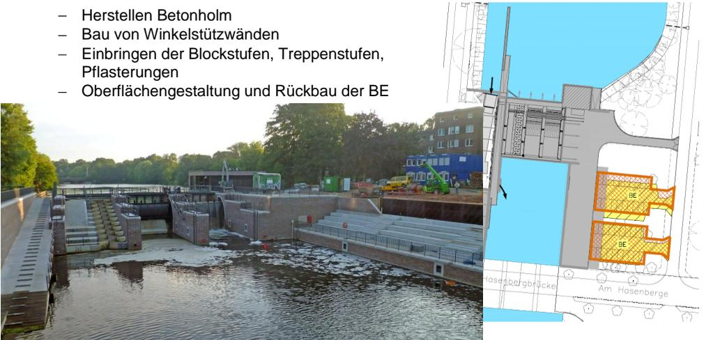
**Abbildung 13** Skizzierte Bauphase 7 und Bild „Treppenanlage“
