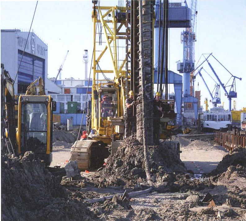
Das enge Pfahlraster, speziell im Bereich 3, sowie die Trassen der Spundwandverankerung lassen wenig Raum zum Reagieren auf Hindernisse im Baugrund. In enger Abstimmung mit Planer und Prüfengeieur werden aber für alle auftretenden Schwierigkeiten Lösungen gefunden.
