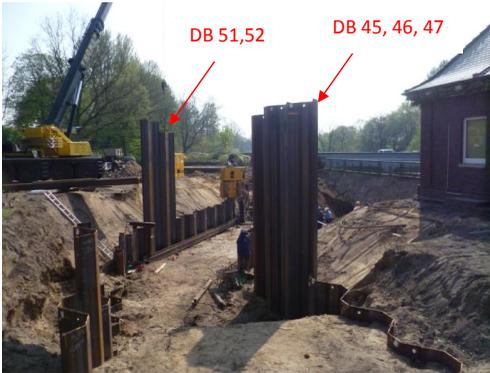
**Spül- bzw. Speiseleitung** aus Stahl für das Ohlsdorfer Schwimmbad verlief. Diese Leitung fand sich jedoch nicht in alten Plänen und war somit ein weiterer Überraschungsfund. Die Leitung konnte nicht vollständig aus der Rammtrasse entfernt werden, sodass die bereichsweise mit Beton verfüllt wurde. Die geringere Endtiefe der Bohlen musste statisch berücksichtigt werden.
