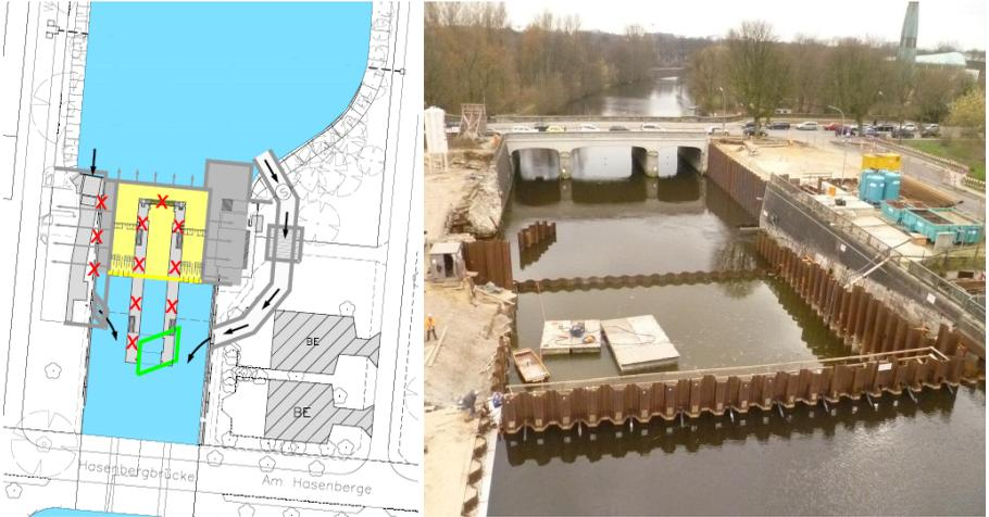
**Abbildung 10** Skizzierte Bauphase 4 und Bild der fertig umpundeten Baugrube
