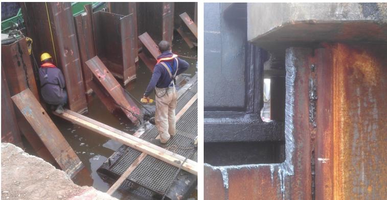
Abbildung 2: Probelastung an einer Tragbohle mit einbindenden Füllbohlen (links), angeschweißte Füllbohle an Tragbohle (rechts)
