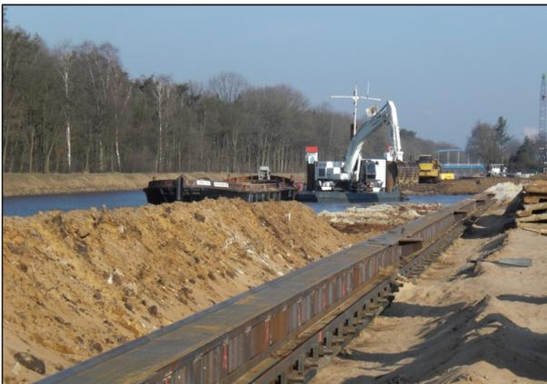
Abbildung 6: Nassbaggerarbeiten, fertiggestellte Spundwand
