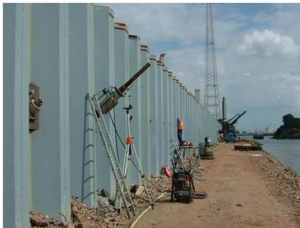
Abbildung 11: Zugprüfung am Bauwerkspfahl (Abnahmeprüfung)
