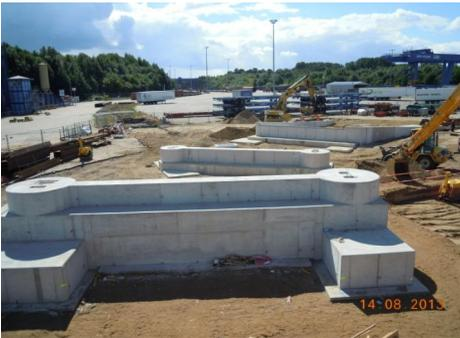
Bild 6: Fundamente Oberdeckrampe
