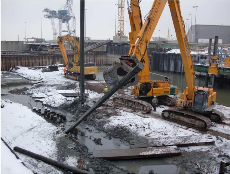
Abbildung 4: Pfahlschneider und Hilfsbagger in der Kaiserschleuse
