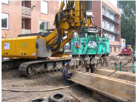
Abbildung 2: Mäklergeführte Presse, Spundbohlen an Knebelketten angeschlagen
