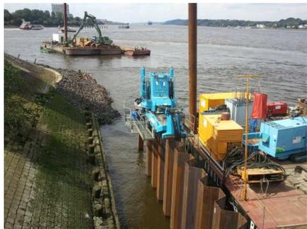
Abbildung 13: Spundwandpresse „im“ Wasser, ca. 5 bis 8 m über Baugrund
