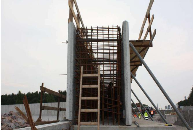
Abbildung 14: Herstellung der Schutzwand mit Betonfertigteilen
