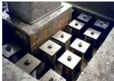
Abbildung 10: Nachgründung eines Brückenpfeilers, Highway I-80 El Cerrito Viaduct, Albany, California
