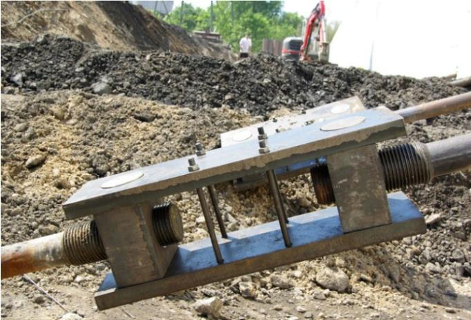
Abbildung 6: Gelenkiger Anschluss an die Stahlbetonwand vor der Ausrichtung
