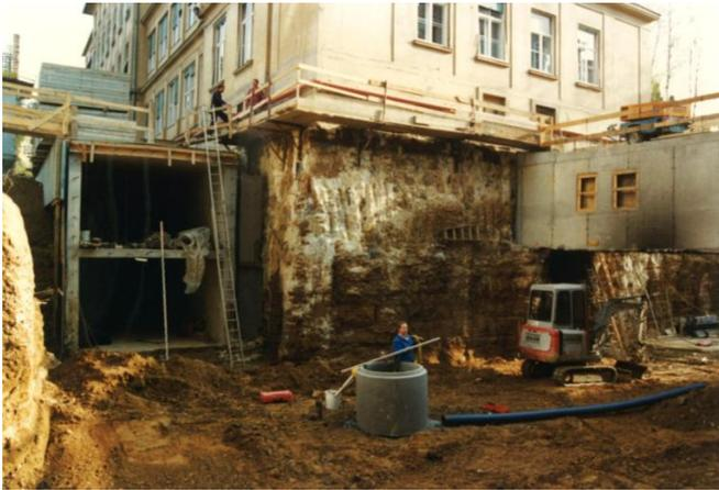
Abb.5 Unterfangung des Bestands und Sicherung von Kollektoren
