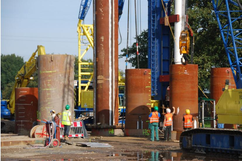
Abbildung 11: Rammung der Testpfähle
