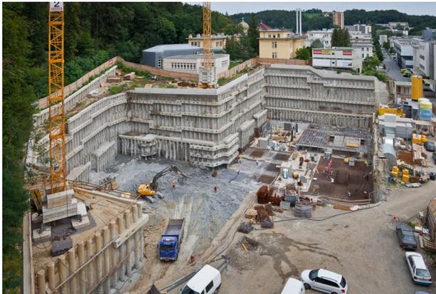
Abb.6 Baugrube mit Bohrpfählsicherung auf Endtiefe des Aushubs
