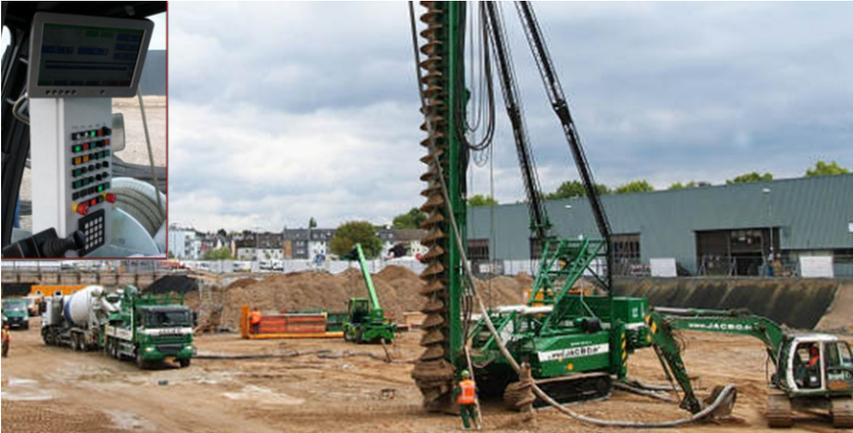
Abbildung 4: (Bohrgerät mit Kontrolleinheit)
