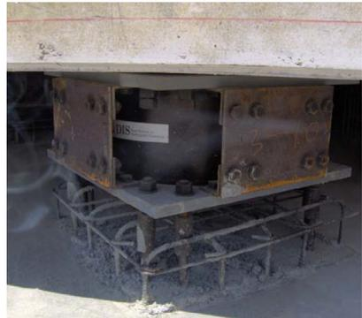
Abbildung 8: DIS Seismic Isolator
