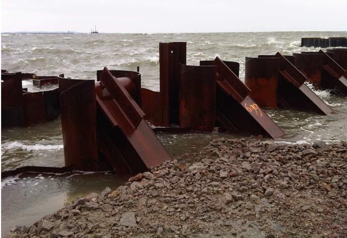
Abbildung 3: Schrägpfahlanschluss
