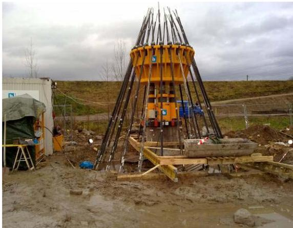
Abbildung 7: Belastungskrone Einzelpfähle (während des Aufbaus).
