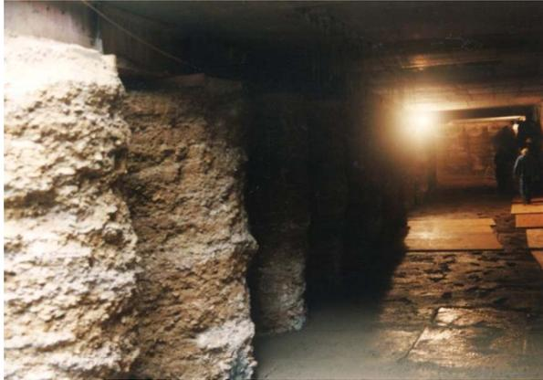
Abb.3 Temporäre Düsenstrahlsäulen im Aushubzustand
