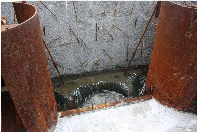
Abbildung 13: Fertigteilelemente am Spundwandkopf
