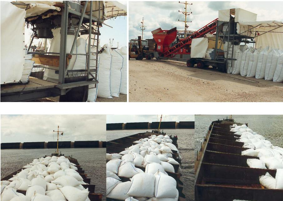
Abbildung 3: Befüllung und Einbau von 48000 Sandcontainern zur Kolkstabilisierung am Eidersperrwerk 1993 (*Heibaum, 1994; Schlie, 1999; Werth & Heerten, 2010*)
