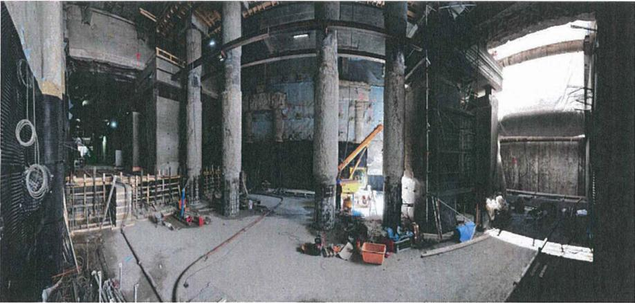
**Bild 8: Panoramablick im Unterfahrbereich ; rechts (Süd) Startbaugrube; links erste Betonierabschnitte der Tunnelsohle**
