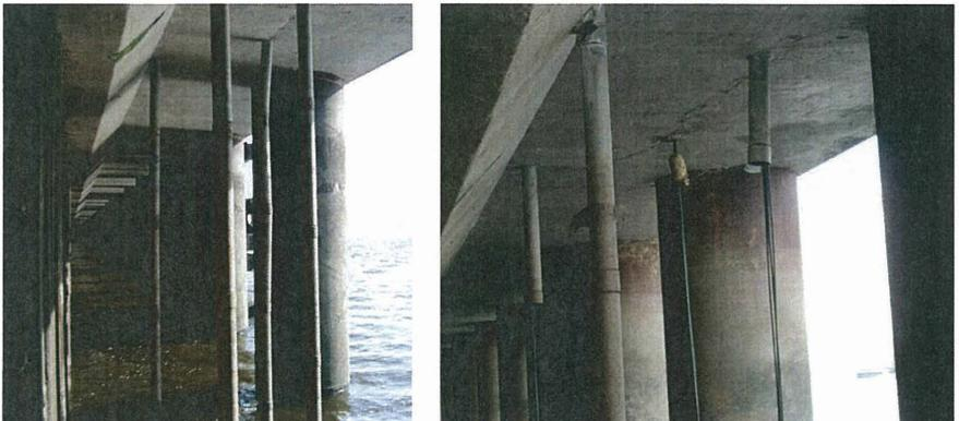
Abb. 6: Verrohrte Kabelführung während der Abbaggerung (intakt und kollabiert)
