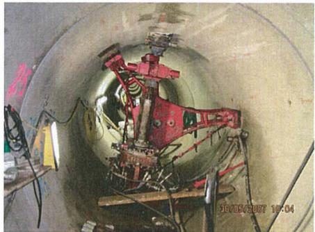
**Bild 4: Herstellung der Vereisungsbohrungen aus dem Hilfsstollen (Rohrvortrieb)**
