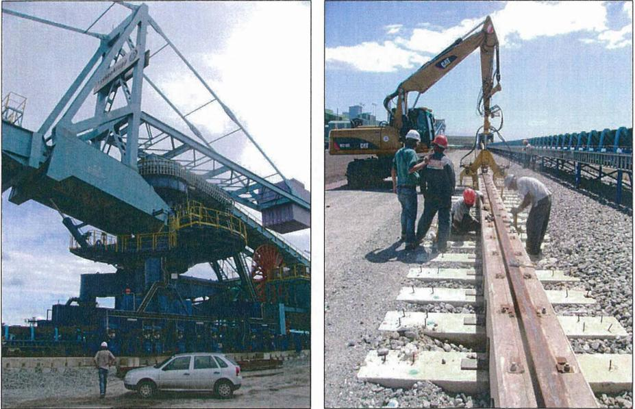
**Bild 8** *Aufbau der Stacker/Reclaimer und erste Nachstopfarbeiten am optimierten Schiene-Schwelle-System*
