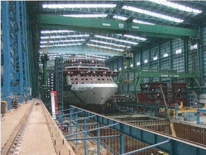
Bild 17: Dockhalle nach Rückbau der alten Giebelwand
