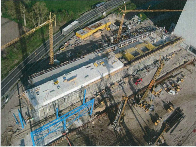
Bild 12: Herstellen der Seitengebäude in Stahlbetonskelettbauweise
