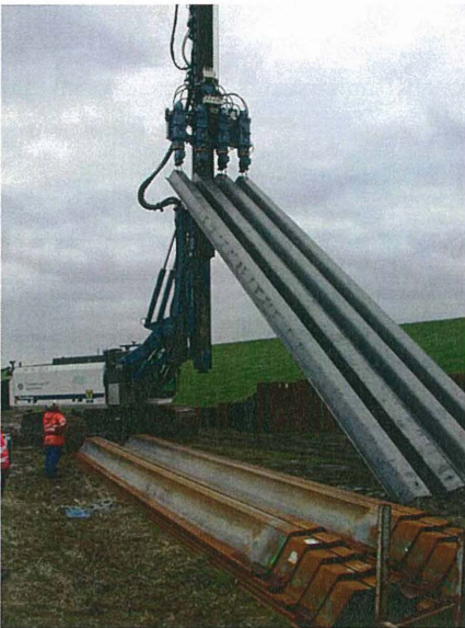
Abbildung 10: Spundwandarbeiten bei Deich-km 21+400
