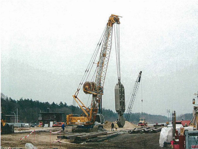
Bild 16 (Dichtwandgreifer im Einsatz)
