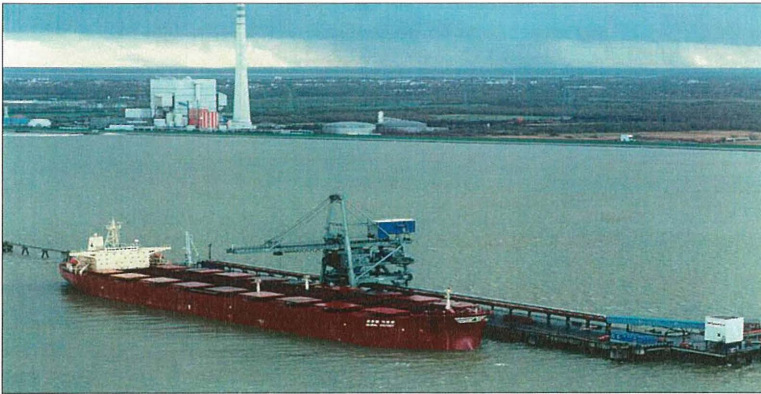
Abb. 9 Niedersachsenbrücke; Ausbau für Cape Sizer
