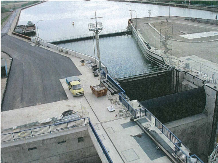
Bild 6: Schleuse Uelzen II - Obertor, oberwasserseitiger Kammerrevisionsverschluss, oberwasserseitiger Schleusenrevisionsverschluss
