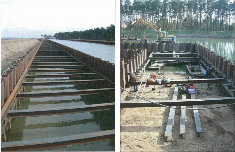
Abbildung 4: Aussteifung Fangedamm, Fotos Ausführung
