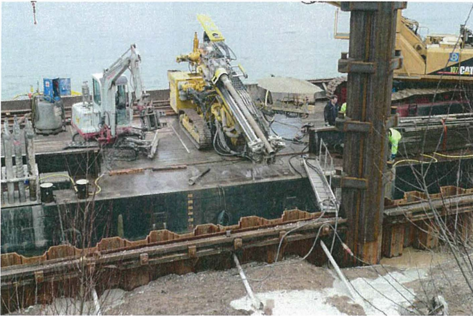
Bild: Ankerbohrarbeiten am Hafen Walsum
