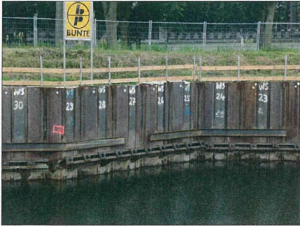
Abbildung 10: Verankerung Baugrube, Fotos Bauausführung
