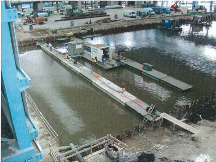
Bild 10: Taucherpontons während der Reinigung der Gründungsträger
