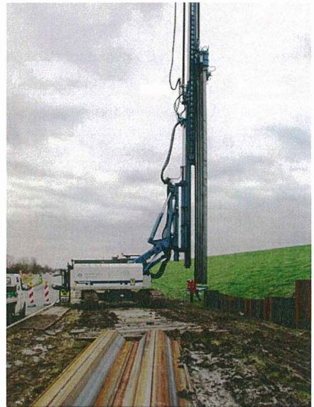
Abbildung 10: Spundwandarbeiten bei Deich-km 21+400
