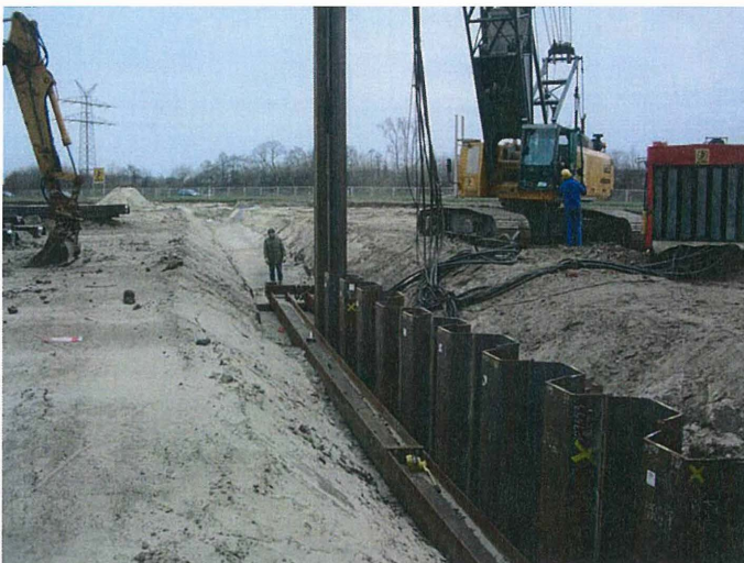
Bild 6: Einbringen der Spundwände
