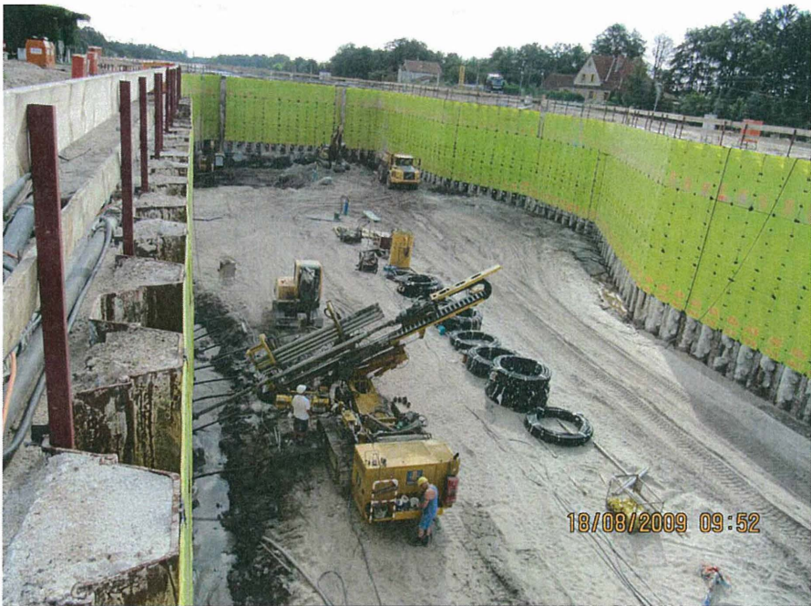
Bild 17 (Ankerarbeiten in der Baugrube)
