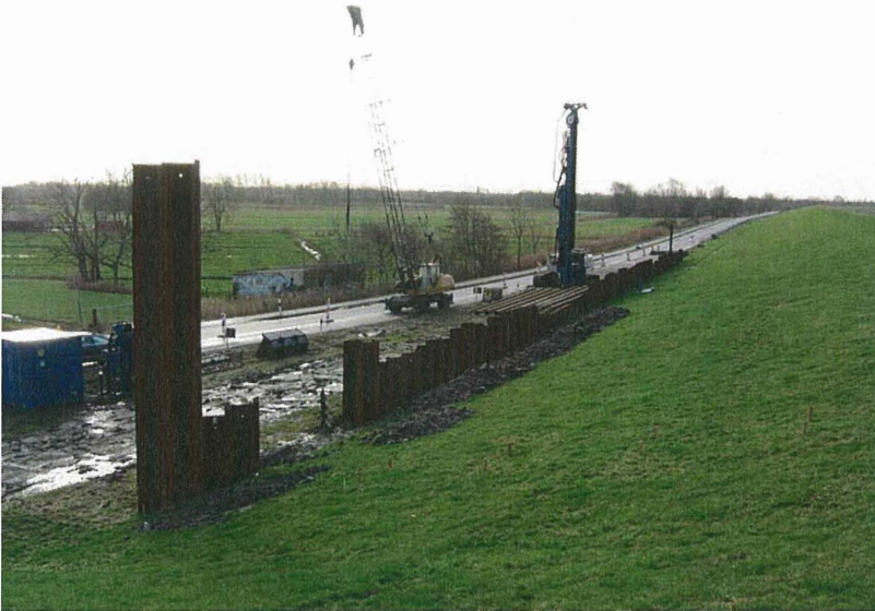
Abbildung 9: Spundwandarbeiten bei Deich-km 21+400
