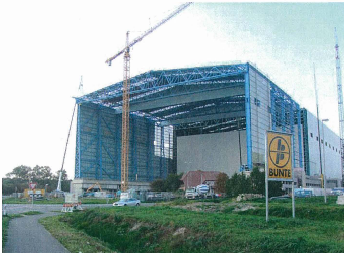
Bild 16: Gesamtansicht der Hallenerweiterung vor Aufbau der Giebelwand
