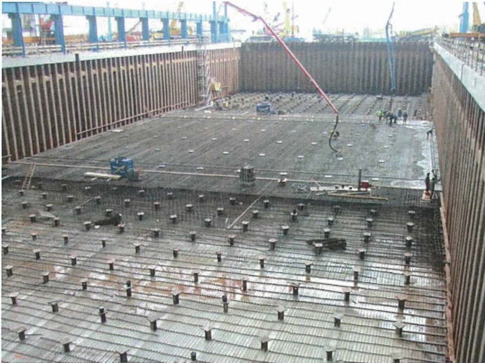
Bild 11: Herstellen der Stahlbetonsohle im gelenzten Baudock
