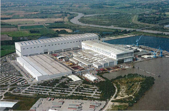
Bild 19: Werftanlage nach Hallenerweiterung
