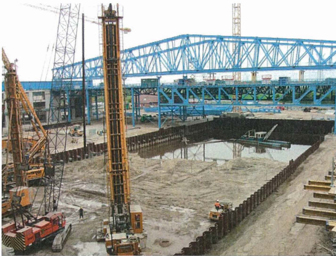
Bild 14: Aufbau der Dachbinder als Stahlfachwerkkonstruktion, Aushub des Baudocks im Spülverfahren
