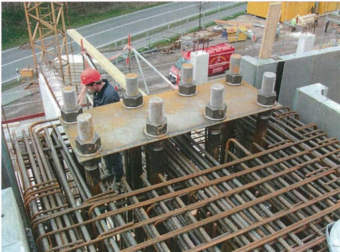
Bild 13: Verankerung für die Fachwerkstützen der Stahlhallenkonstruktion
