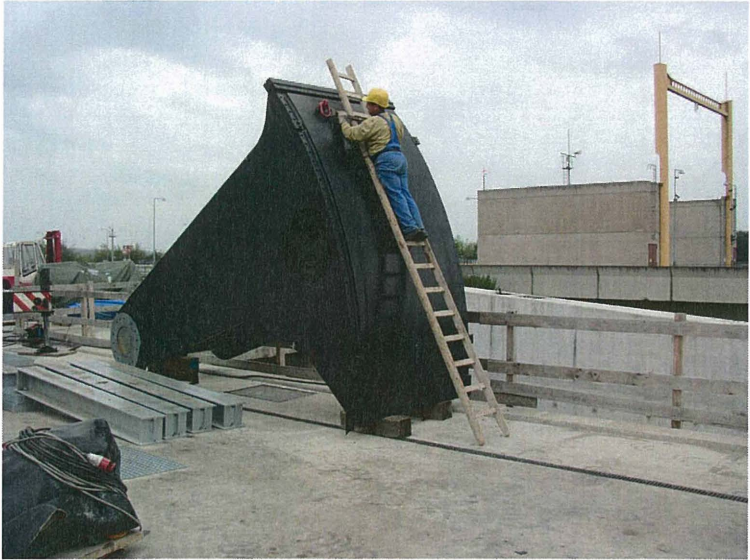
Bild 5: Schleuse Uelzen II - Längskanalverschluss
