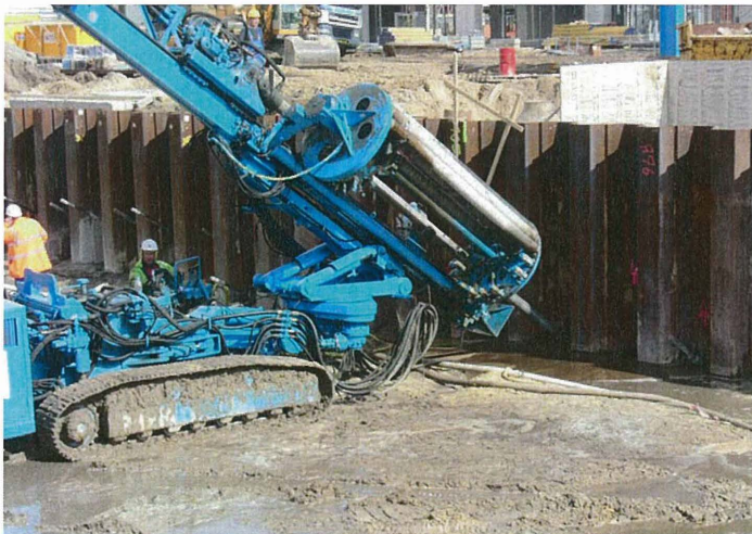
Bild 8: Herstellen der Spundwandverankerung
