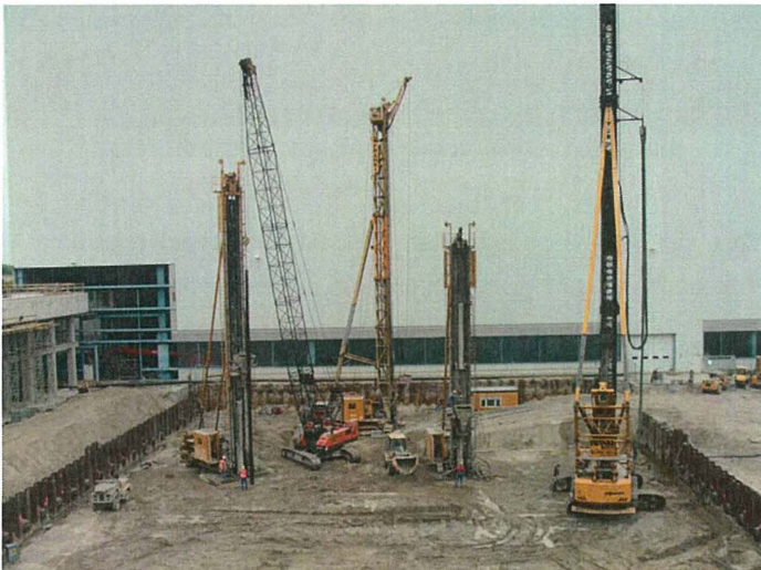
Bild 9: Herstellen der Gründungspfähle – System Franki
