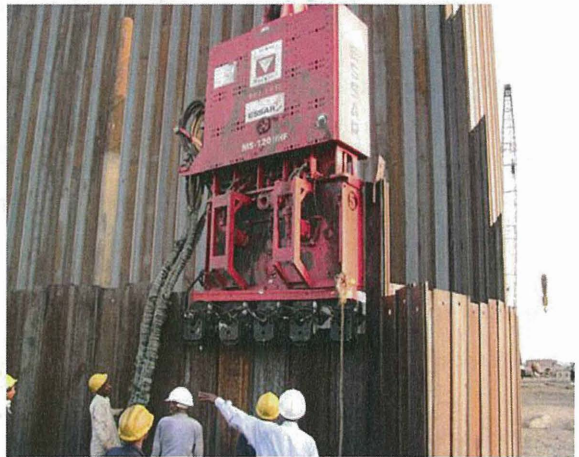
Bild 7: Sonderkonstruktion Vibrator mit fünf Zangen
