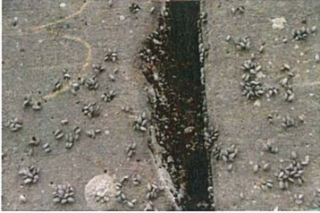
Bild 4 (Fugenschaden)
