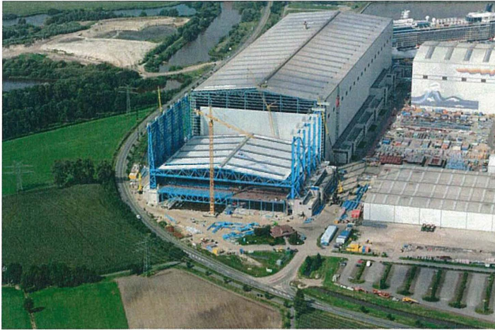
Bild 15: Fertige Dachkonstruktion vor dem Litzenhub in die Endposition
