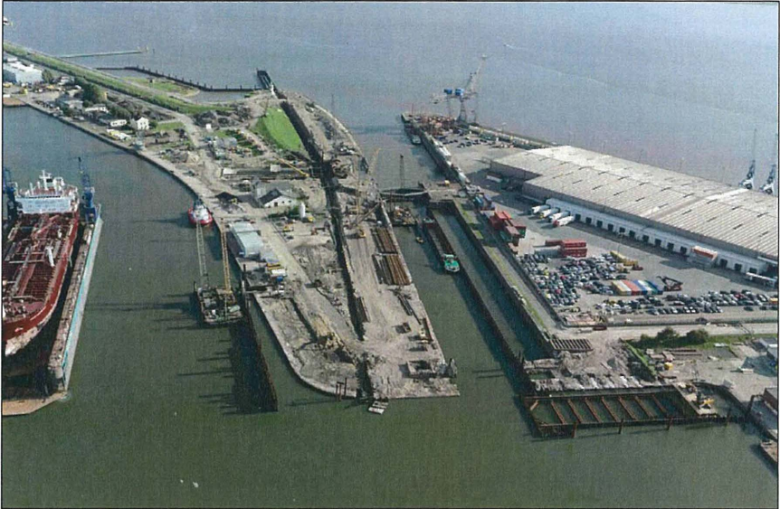
Abb. 4: Überblick über die Baustelle im August 2008
