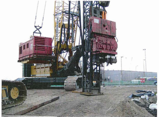
Bild 4: Kaiserschleuse Bremerhaven, Einbringung von Trägern
