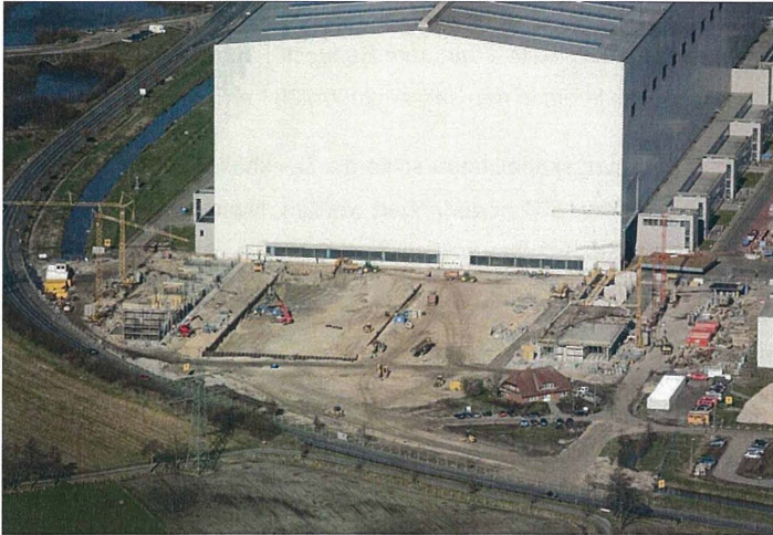
Bild 5: Die Bauarbeiten im Anfangsstadium Einbringen der Spundwände, Herstellen der Seitengebäude
