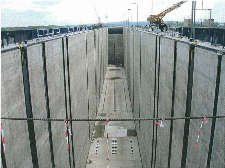
Bild 4: Schleuse Uelzen II - Schleusen-kammer vom Unterhaupt aus gesehen, im Hintergrund das Obertor
