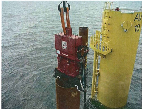
Bild 1: Alpha Ventus, Verankerung von Tripods
