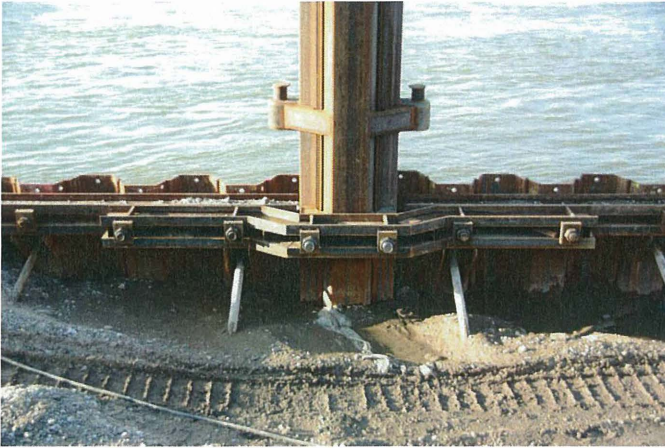
Bild: Dalben mit Gurtumgehung und Verankerung
