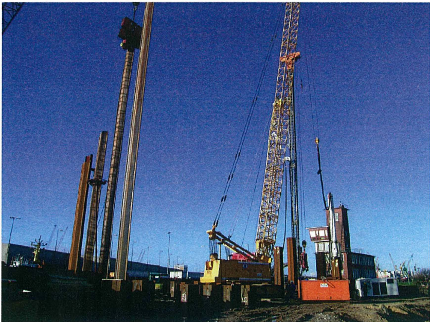
Bild 5: Einbringen der Zwischenbohlen an der Torkammerbaugrube Außenhaupt
