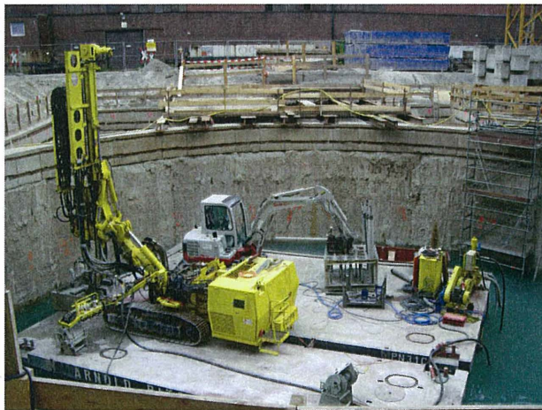
Bild 7: GEWI-Pfahlherstellung vom Ponton
