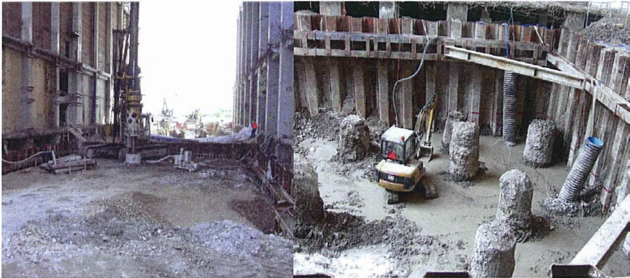
Abb. 12: Bohrpfahlherstellung und Endaushub
