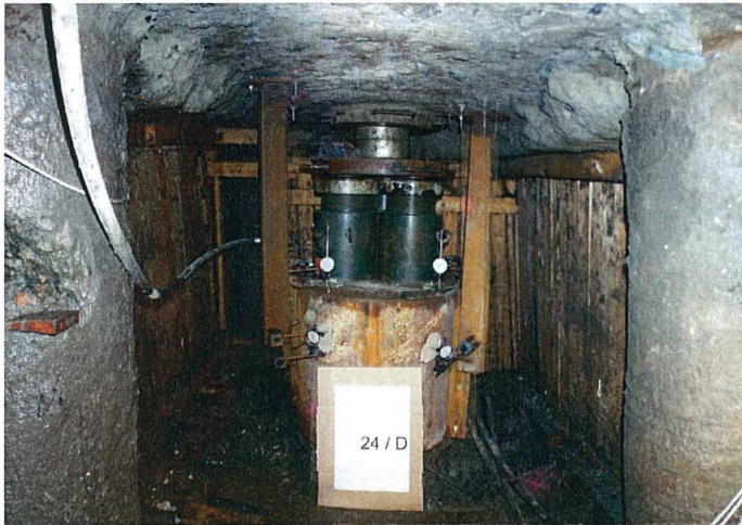
Bild 6: Probelastung an den Bestandspfählen
