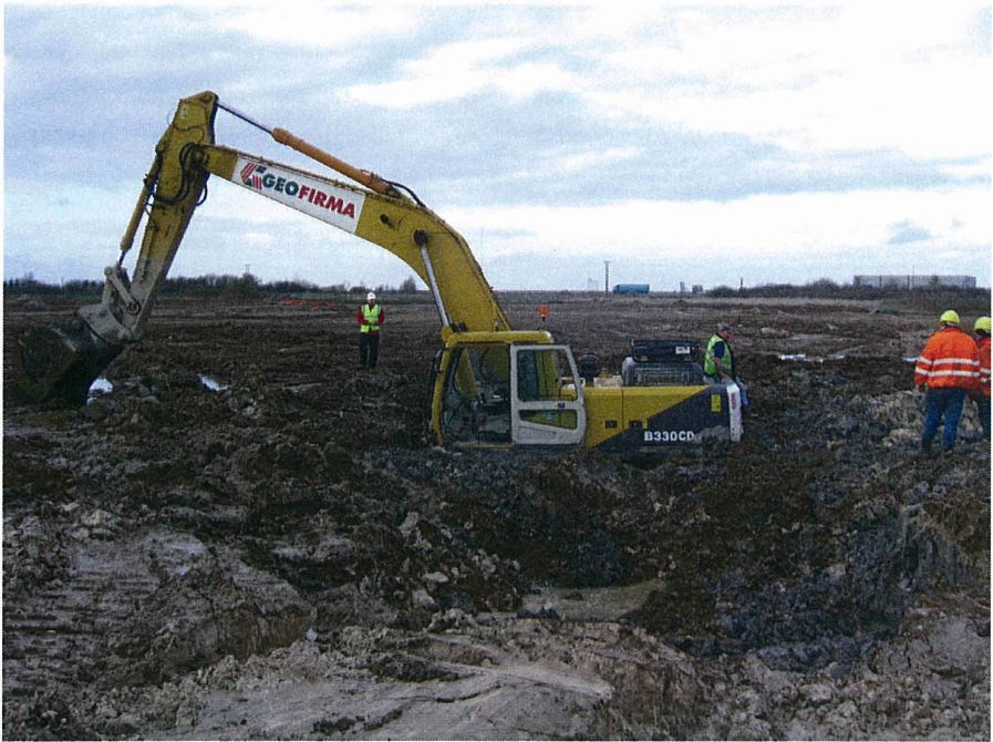
Abb. 5: eingesunkene Bagger vor Herstellung der Arbeitsebene
