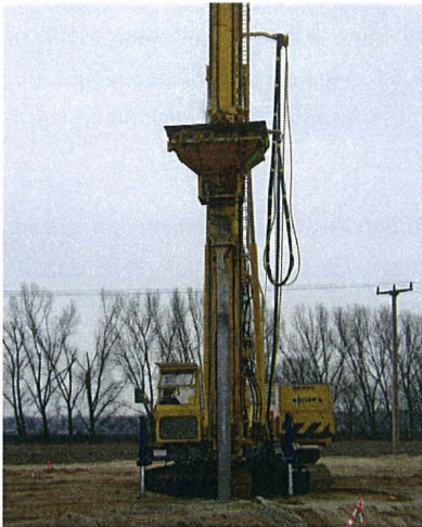
Beispiel der Herstellung einer Rüttelstopfsäule
