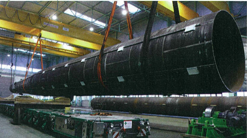
Der fertig instrumentierte Monopile wird verladen
