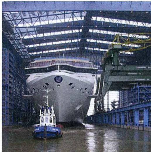
Bild 3: Innenansicht des fertigen Baudocks II
