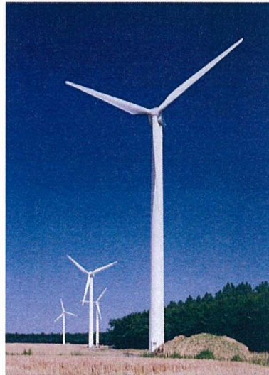
Windpark Grevenbroich (Rüttelstopfverdichtung)
