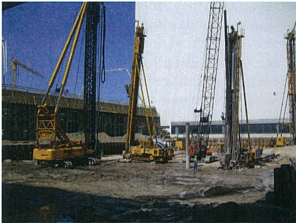
Bild 10: FRANKI-Rammen und KC-Ramme auf der Arbeitsebene 3 m unter OK Gelände
