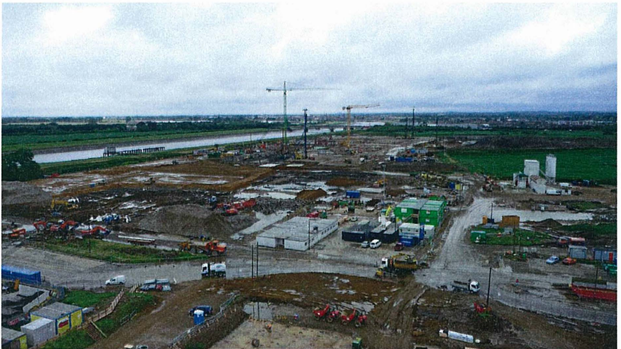
Abb. 16: Gesamtübersicht Baustelle während Pfahlherstellung
