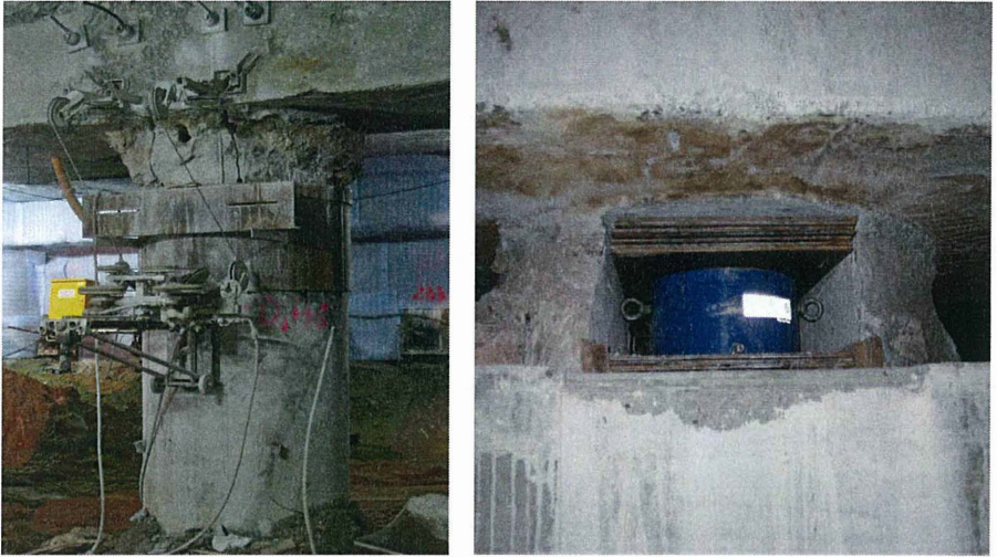
Bild 10: Sägearbeiten und eingebaute Pressen
