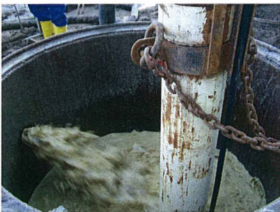
Bild 10: Suspensionsregenerierung
