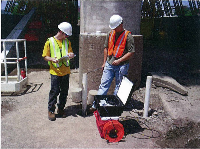
Bild 4: Induktivmessungen in PVC verrohrten Bohrlöchern
