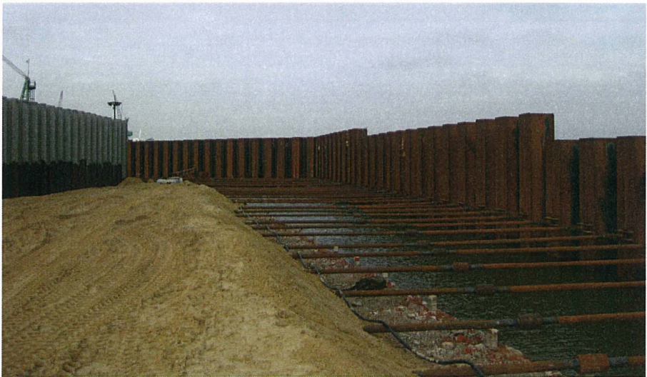
Bild 12: Ansicht des Fangedamms vor der Verfüllung
