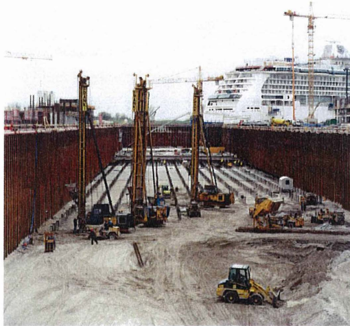
Bild 2: Rammarbeiten in der ausgehobenen Baugrube im Jahr 2000
