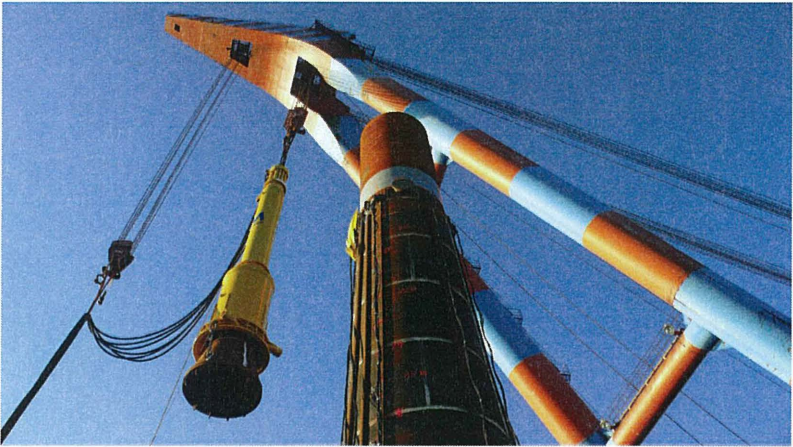
Der Hammer wird aufgesetzt
