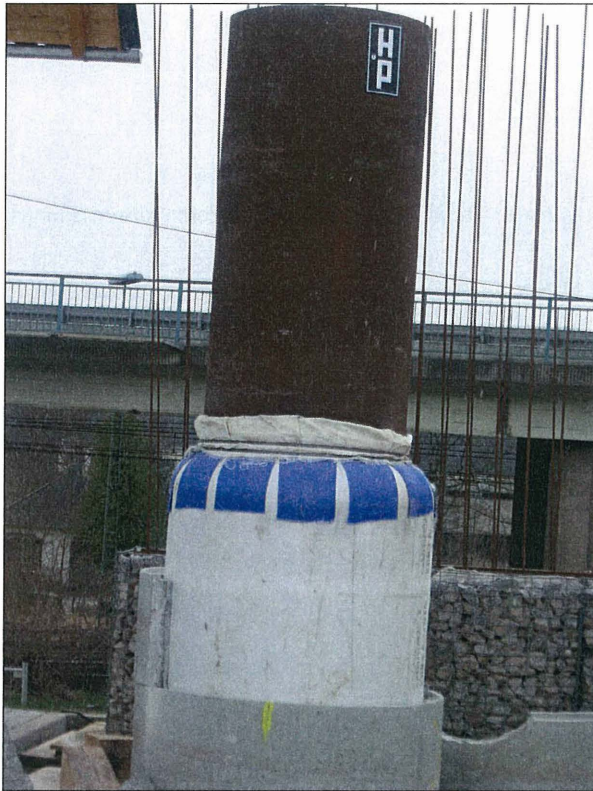
Bild 14: Probepfahl mit Stahlrohrhülse und Übergang zum einbetonierten Gewebeschlauch
