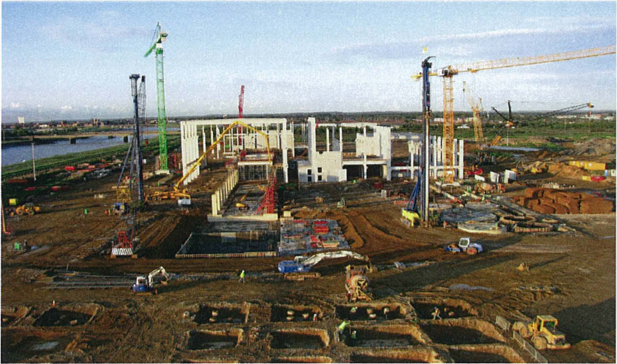
Abb. 19: Rammarbeiten und Herstellung Rohbau laufen parallel
