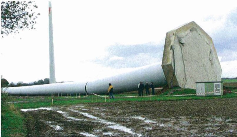
Umgestürzte Windenergieanlage im Windpark Ellenstedt
