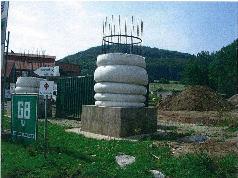
Bild 7: Betonsäulen nach Rückbau des Stützgerüsts
