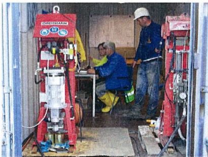
Bild 12: Injektionscontainer mit Online-Messung
