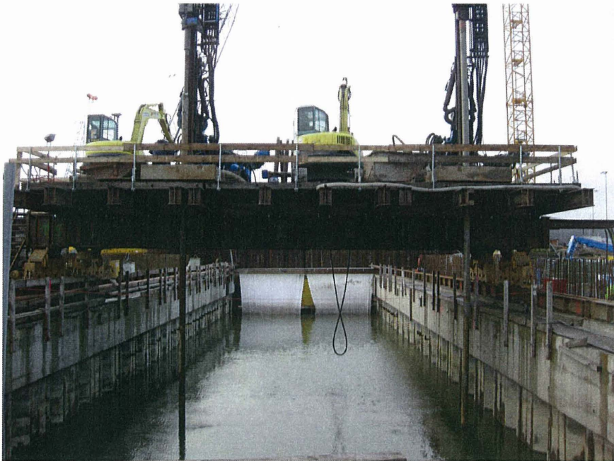
Bild 7: Arbeitsbühne über der Torkammerbaugrube mit zwei Verpresspfahleinheiten
