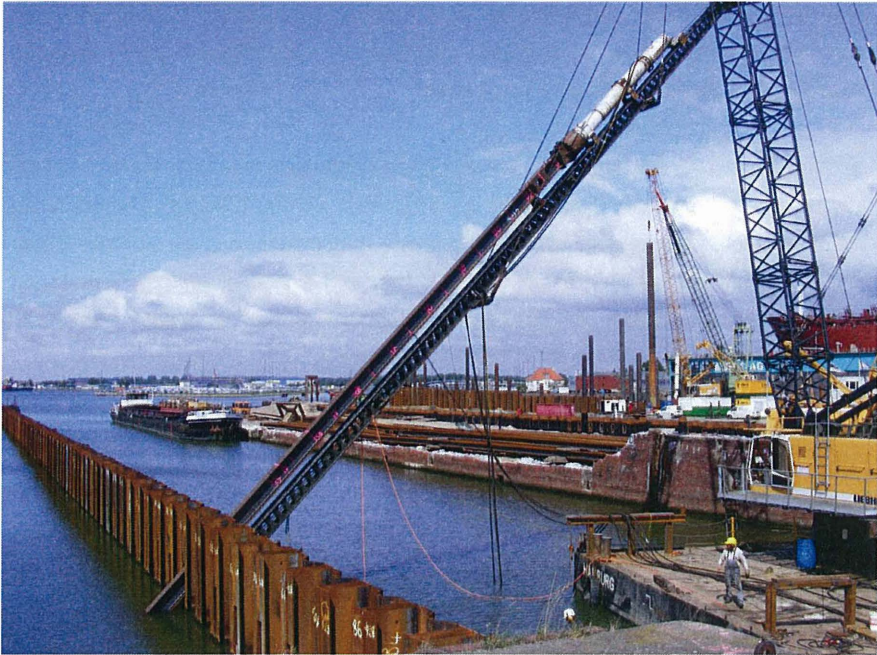
Bild 14: Schleusenammerwand West: Einbringen eines Schrägpfahles
