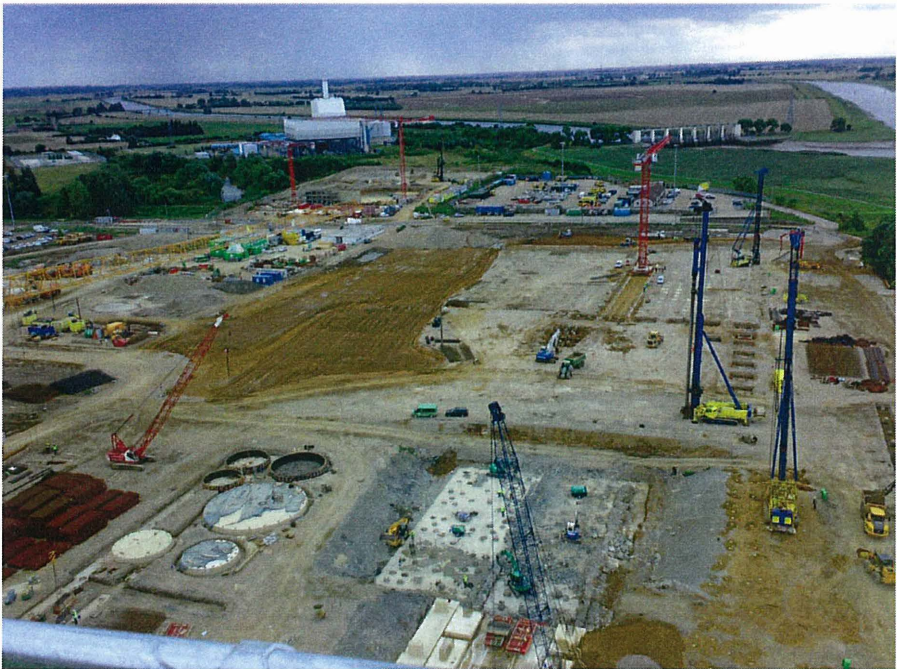
Abb. 17: Rammarbeiten während Erdaushub und Fundamentherstellung
