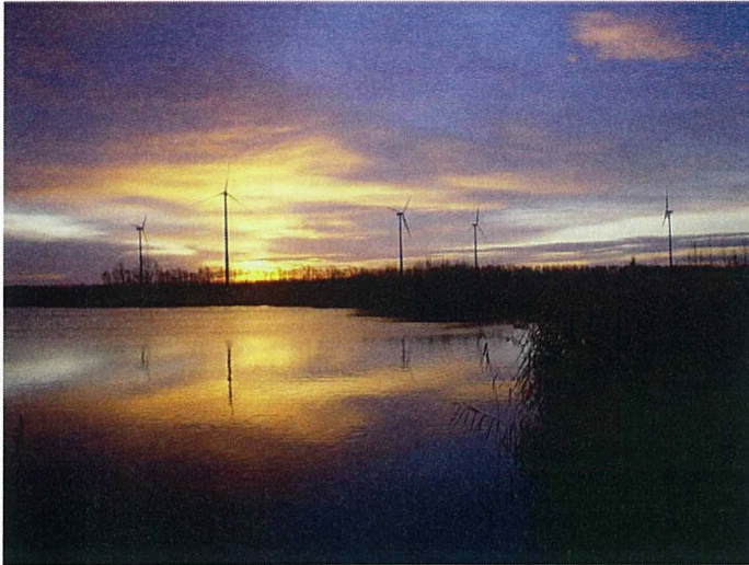
Windpark Kittlitz (Rütteldruckverdichtung und Rüttelstopfverdichtung auf dem Gelände eines ehemaligen Braunkohletagebaus)
