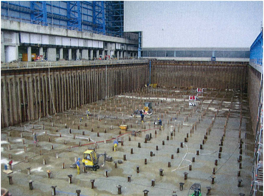
Bild 11: Blick auf die Unterwasserbetonsohle und die HEM-Profiltragglieder
