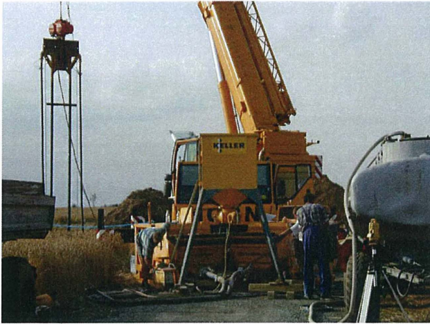
Herstellung der Stabilisierungssäulen mit Doppellanze
