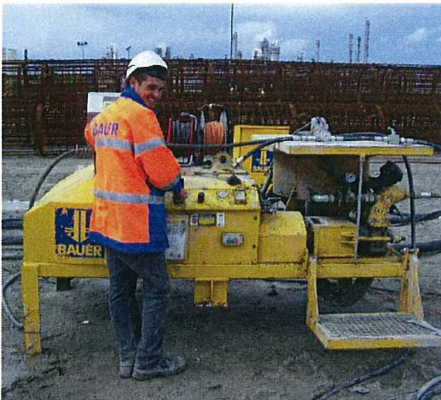
Bild 13 : Füllen der Hubkissen mit Zementleim
