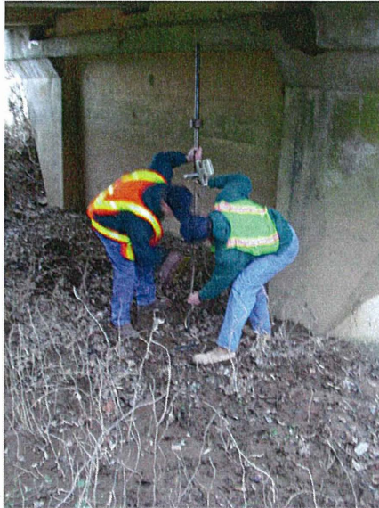
Bild 1: Einsatz einer leichten Rammsonde unter einer Brücke
