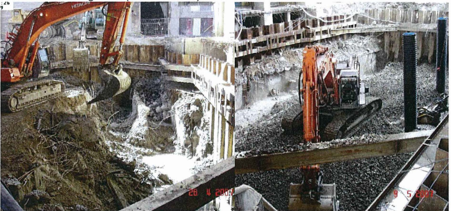
Abb. 11: Aushub und Wiederverfüllung der Spundwandgrube
