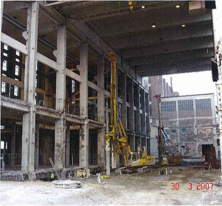
Abb. 4: Drehbohrgeräte im „Gas turbine plant“
