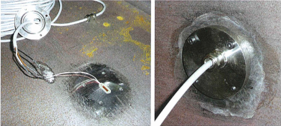
Abbildung 12 : applizierter DMS und wasserdichter Verschluss
