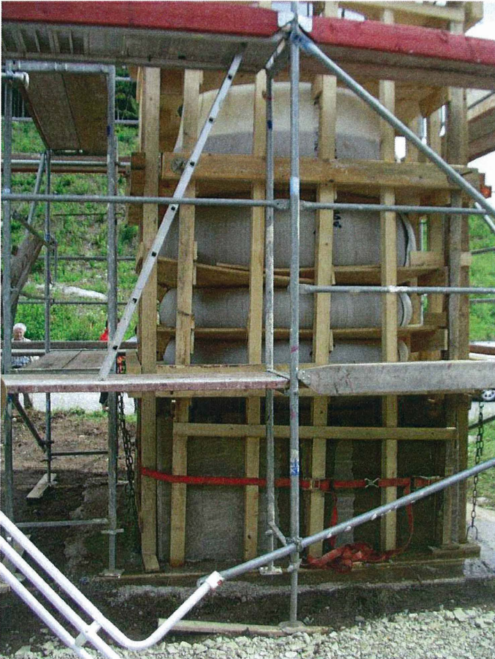
Bild 6: Horizontale Schalttafeln simulieren Hohlräume im Boden
