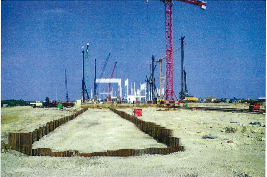
Abb. 18: Hergestellte, noch nicht freigelegte Spundwand
