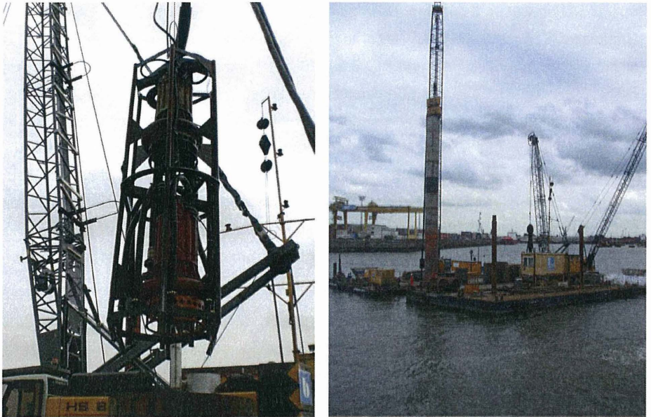
Abb. 4: Arbeiten zum Bodenaustausch im Bereich der Rammachse B
