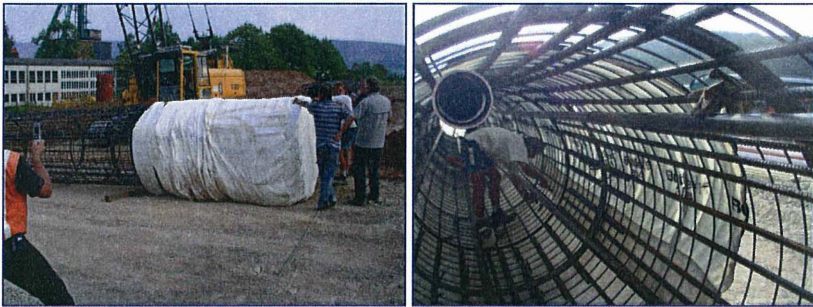
Bild 8 + 9: Aufziehen und Fixieren des Geweschlauches auf dem Bewehrungskorb
