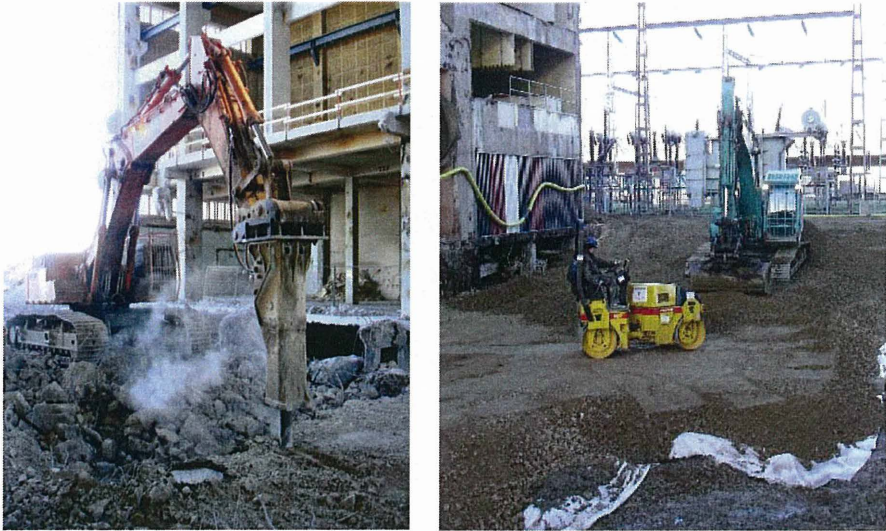
Abb. 5: Beräumen und Herrichten der Arbeitsebene für die Pfahlbohrarbeiten
