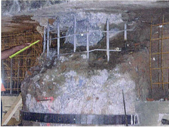
Bild 8: vorgefundener Pfahlkopf in Achse 4
