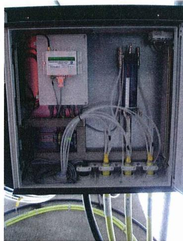
Abb. 2.3-5: Messschrank mit Datenlogger, GSM-Modem und Niveaugefäß
