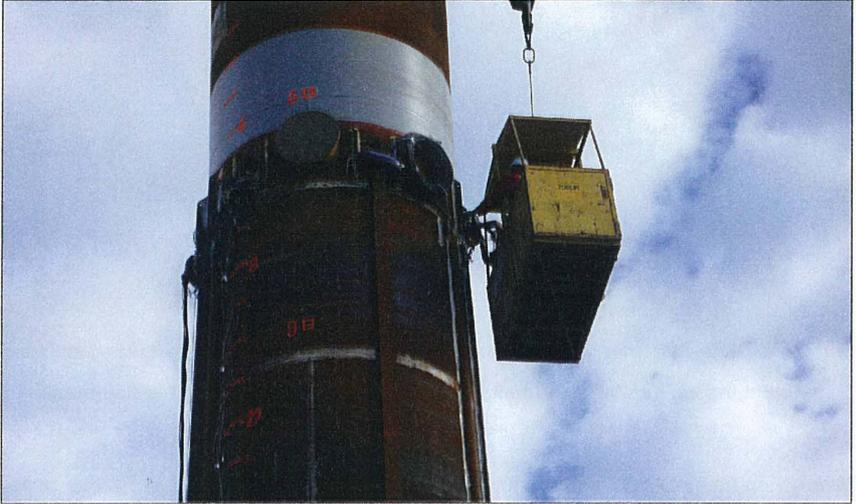
**Abbildung 16: Lösen der Kabel**
