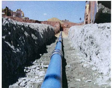
**Abb. 4:** Einbau Streckenmessrohr im Hinterfüllbereich 4 (langer Magerbetonkeil).
