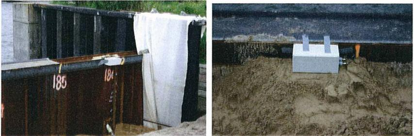
Bild 9: Messbox am Spundwandkopf
