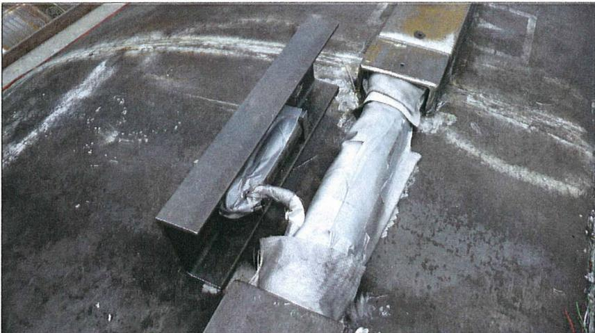
**Abbildung 12: in Schweißermatten eingewickelte Kabel**
