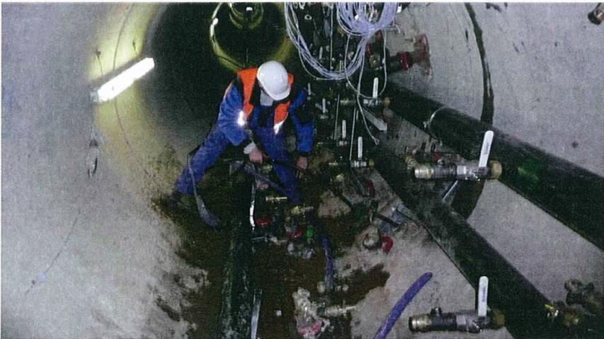
Abb. 5: Einbau der Messlanzen vor Ort
