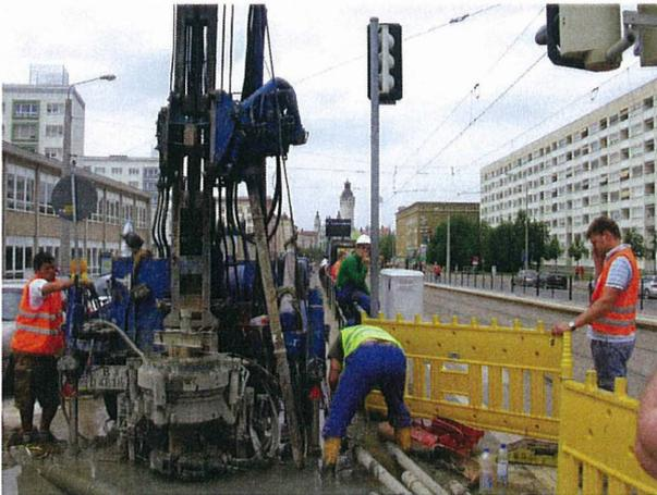
Abb. 3: Messrohrinstallation in Pfählen
