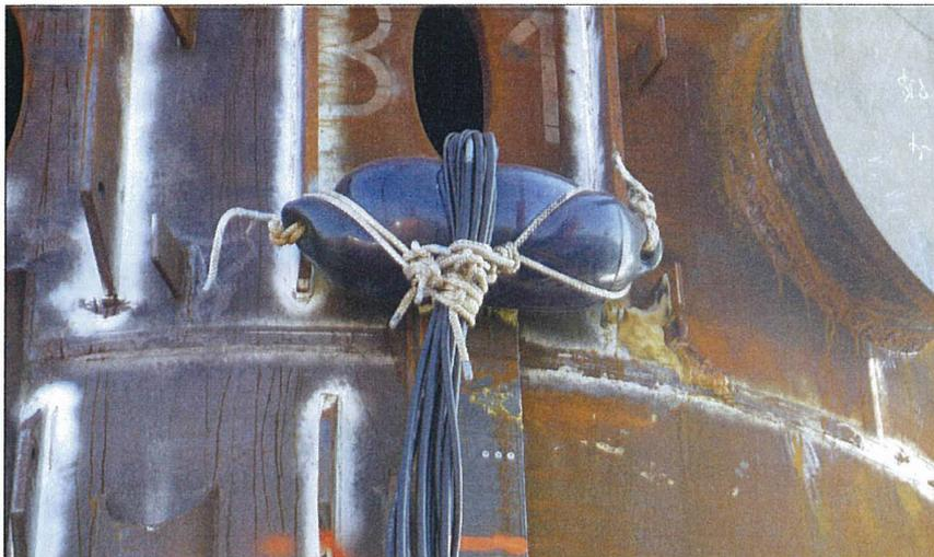
**Abbildung 18: Fender als Abknickschutz für die Kabel während des Rammens**
