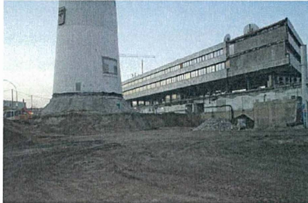
Abb. 11: Aushub an der Nordseite vom Turmfuß
