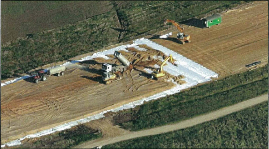
Bild 6: Verlegung der geotextilen Bewehrung
