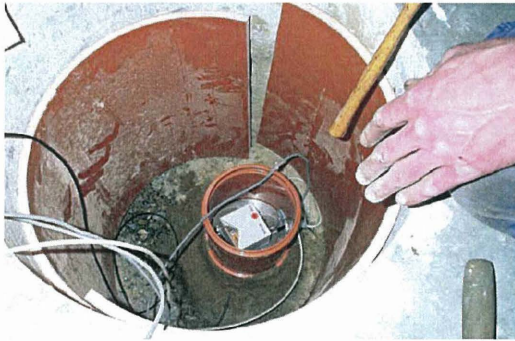
Abb. 7: Montierter Nivel 20 im Schutzgehäuse
