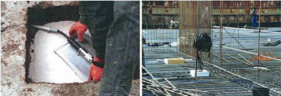
Abbildung 7: Einbau der Sohlspannungsaufnehmer in der Sauberkeitsschicht im April 2000 und zentrale Zusammenfassung der Leitungen vor Betonage
