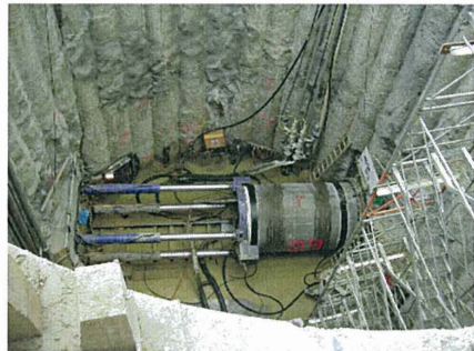
Bild 5: Rohrvorpressung Pilotstollen
