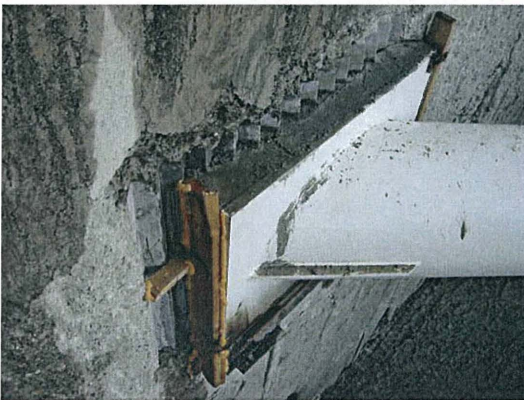
Bild 6: Mit hochfestem Mörtel ausgegossener Anschluss
