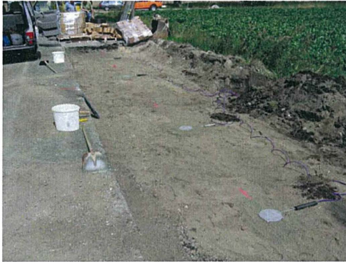
Abb. 8: Einbau der Erddruckmessdosen auf dem Erdplanum mit Ummantelung
