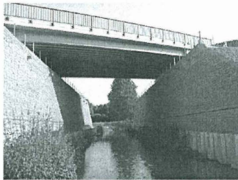
Abb. 4: Ansicht der Brückenwiderlager
