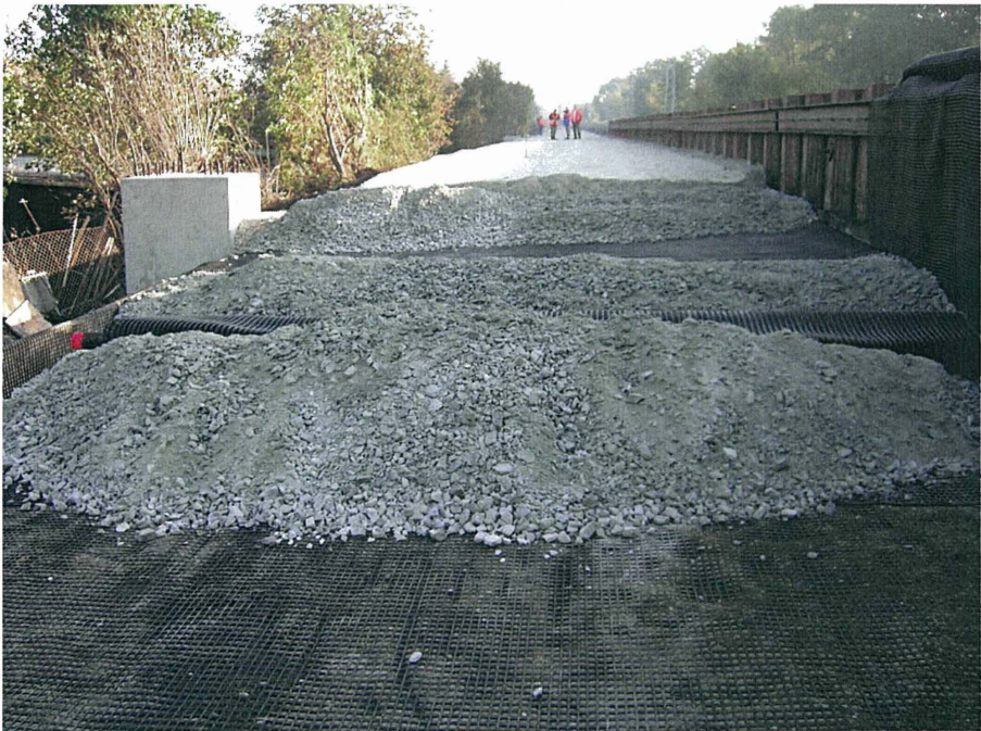
Abb. 3: Zwischenbauzustand Geogitter bewehrtes Polster
