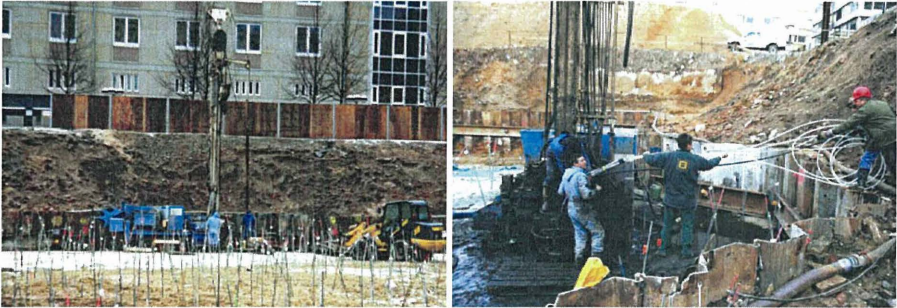
Abbildung 5: Bohrarbeiten und Einbau des 4fach Extensometers innerhalb der Trogbaugrube (Spundwandverbau / gedeckelte Weichgelsohle) im Januar 2000
