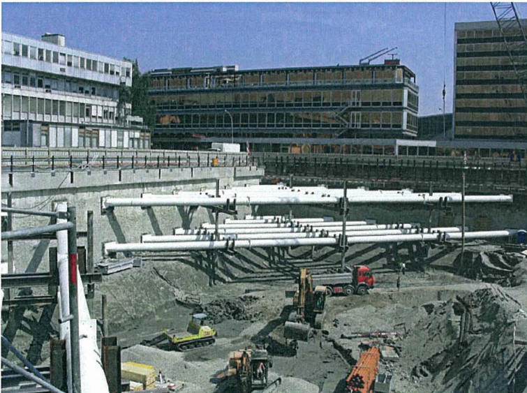
Bild 2: Die Baugrube ROLEX in Genf
