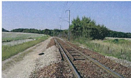
Abb. 11: Verstärkungsmassnahmen an der Bahnstrecke
