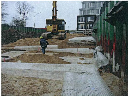
Abb. 18: Einbau des Gründungspolsters
