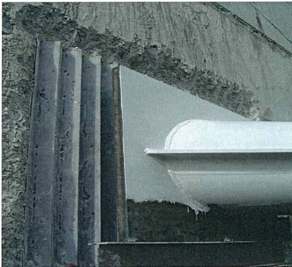
Bild 3: Auflagersystem mit Verzahnungsplatte
