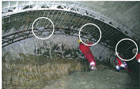
Bild 7: Stellen eines Ausbaubogens
