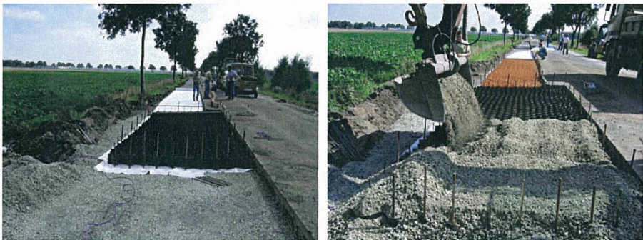
Abb. 6: Aufspannen, Einbau und Verfüllung der Geozellen
