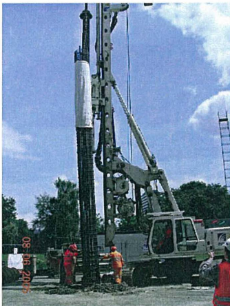
Bild 4: Einbau Pfahlarmierung
