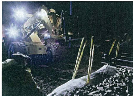
Abb. 15: Einbau des Geodetect-Systems bei Nacht
