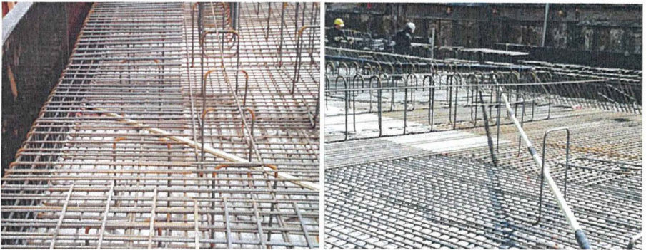
Abbildung 8: Einbau von Inklinometerleerrohren innerhalb der Bewehrung der Bodenplatte des Museums (April bis Mai 2000)
