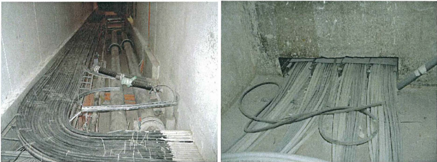
Abbildung 9: Einbau von Kommunikations-/Versorgungsleitungen des Schlauchwaagemesssystems (bis April 04), hier Kreuzung von massiven Kabeltrassen
