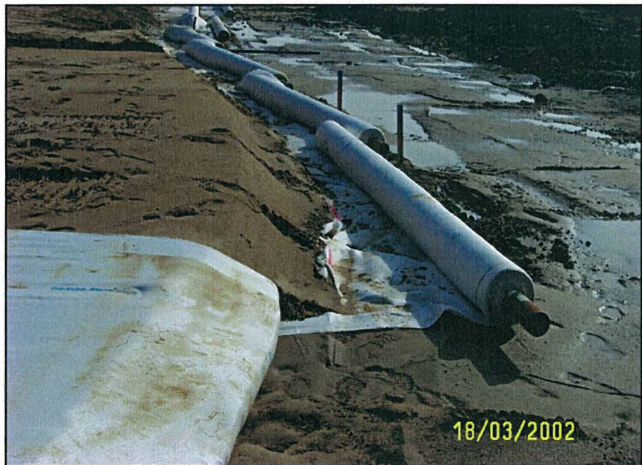
Bild 7: Einbau von hochzugfestem Geotextil
