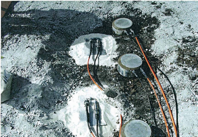
Abb. 8: Position und Einbau der Druckkissen
