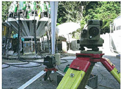
Bild 9: Messungen am Pfahlkopf mit Präzisionsnivellement
