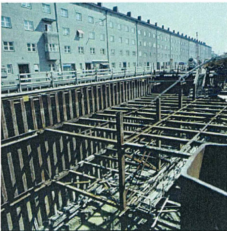
Bild 1: Ausgesteifte U-Bahn- Baugrube
