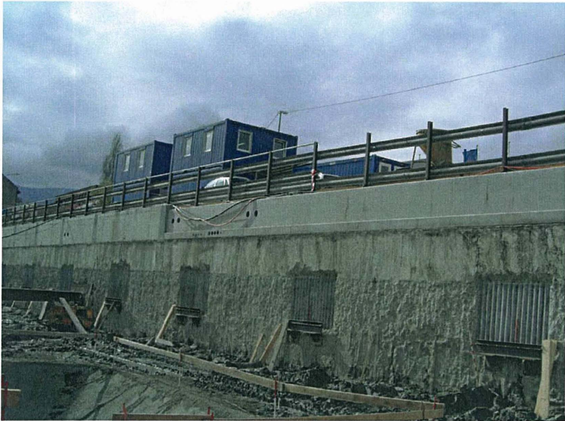
Bild 4: Freigelegte gezahnte Stahltafeln
