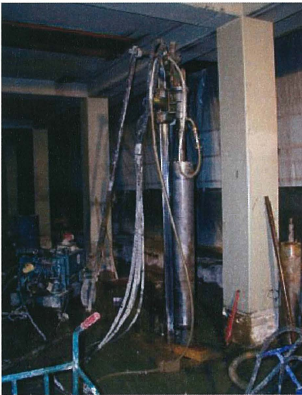
Bild 12: Vorlaufende Kernbohrarbeiten durch den Fundamentblock
