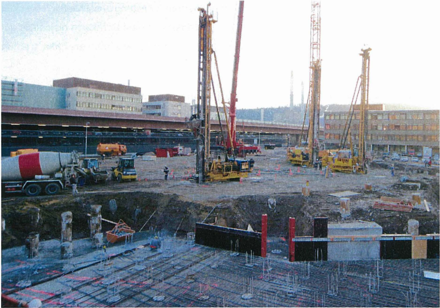
Bild 8: Pfahlherstellung für das Museumsgebäude
