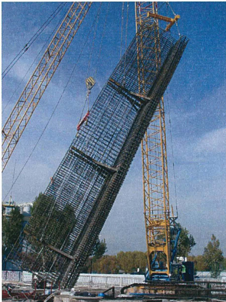
Bild 4: Aufheben eines Bewehrungskorbes mit 35 t in einem T-Element
