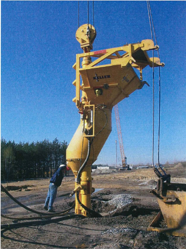
Abb. 4: Schleuse mit Einfülltrichter und seilgeführter Kübel
