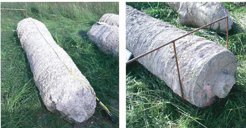
Bild 11: Freigelegte Vollverdrängerpfähle System HARTUNG.
