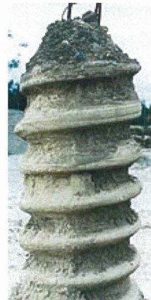
Bild 4: Herstellung eines Atlas-Pfahls und Pfahlschaft (Quelle: FRANKIPILE Australia).
