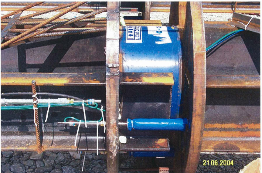
Bild 4: Detail: Osterbergzelle
