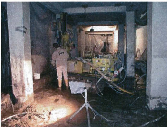
Bild 15: Herstellung der Verpresspfähle
