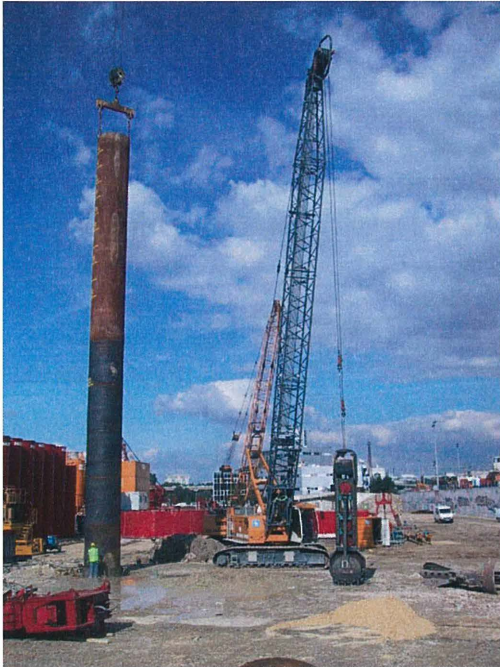
Bild 6: Pfähle mit Primärstützen: links die Teilverrohrung, rechts die Aushubeinheit
