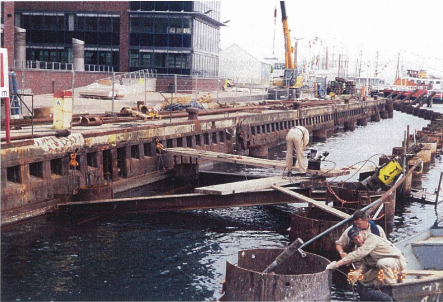
Bild 13: Durchführung der Probelastung
