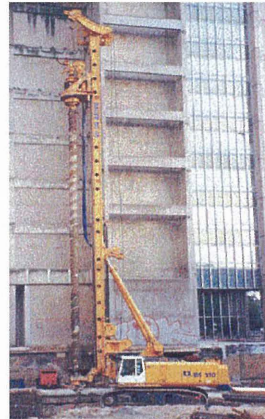
Bild 2: Herstellung Teilverdränger und Gerät (Quelle: BAUER Spezialtiefbau).
