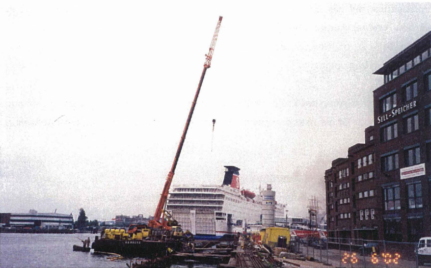
Bild 14: Pfahlherstellung vor dem Sellspeicher
