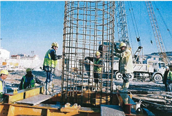
Bild 7: Einheben eines Bewehrungskorbes nach Fertigstellung der Bohrung, (unten die Einstellvorrichtung für den Kopf der Primärstütze)
