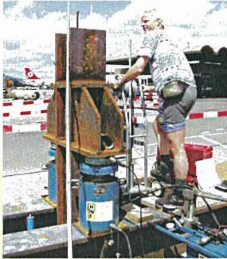
Der Messtechniker führt die Gleitmikrometer-Messung durch
