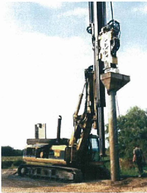
Bild 10: Ort beton-Rüttelsäulen mit Aufsatzrüttler - Verschlussystem (FRANKI Grundbau).
