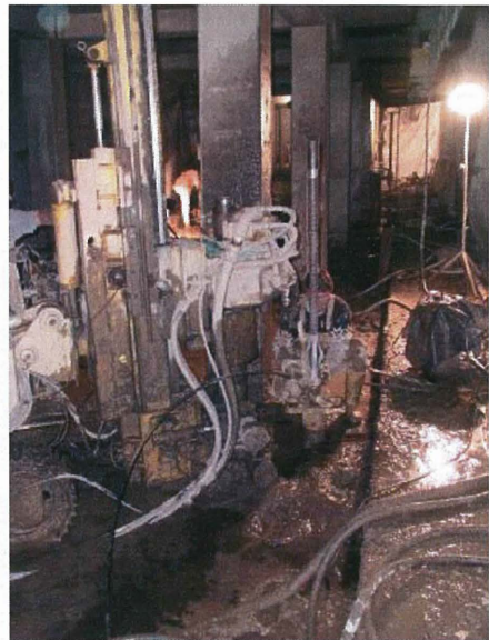
Bild 13: Herstellung der Verpresspfähle
