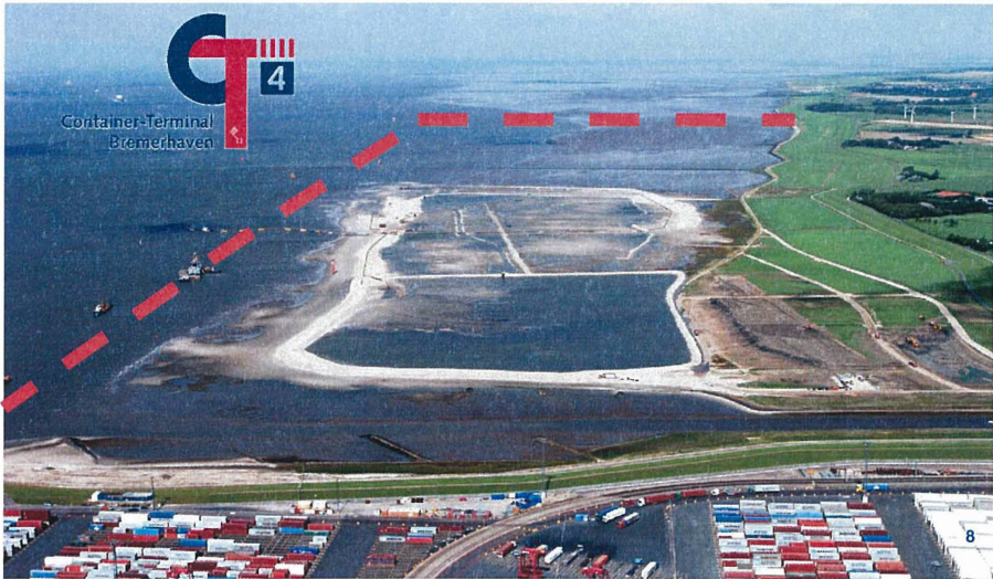
Abbildung 1: Luftaufnahme der geplanten Erweiterung
