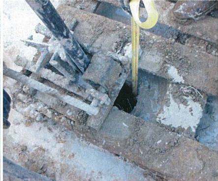
b) Aufweitung und Kontrolle der Absenkung
