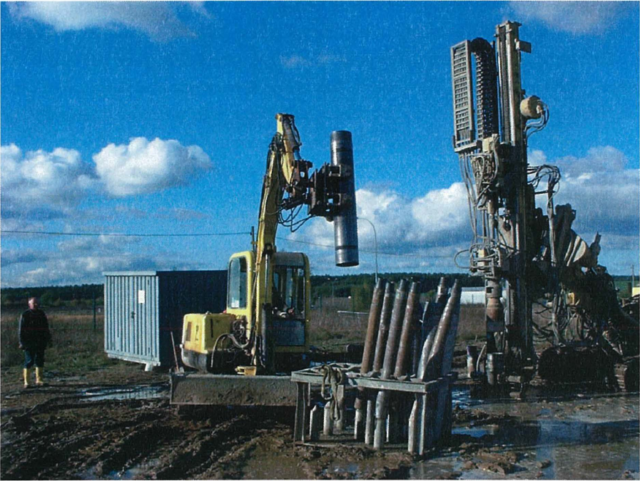
Bild 4: Herstellung der Vertikalpfähle / Bohrarbeiten
