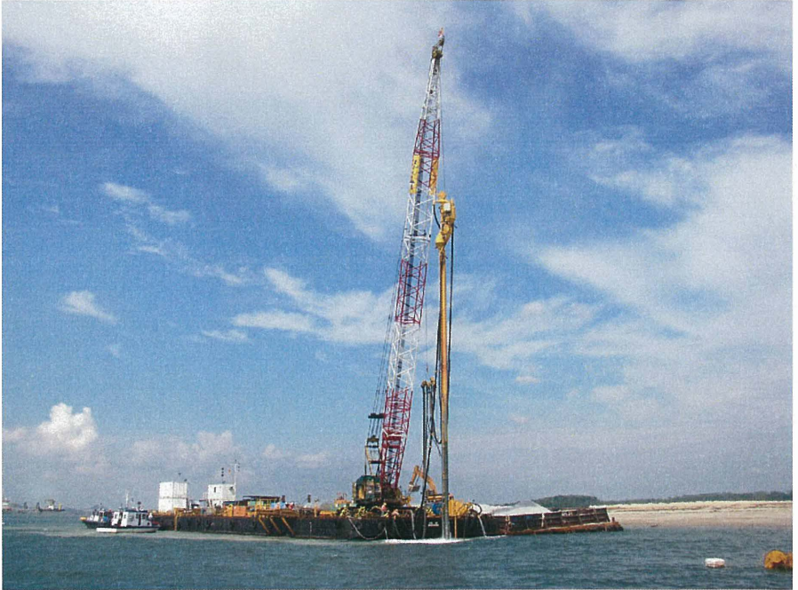
Abb.10: Arbeitsponton links und Schotterponton rechts
