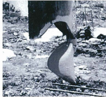
Bild 9: Ort beton-Rüttelsäulen mit Aufsatzrüttler - Verschlussystem (SELCO Costruzioni).
