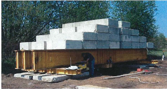
Bild 12: Belastungseinrichtung zur Probelastung von Fertigmortelstopfsäulen.
