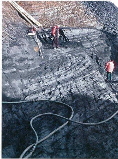
Abbildung 12: Reinigen der Gründungsebene mit Druckluft
