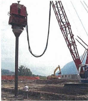
Bild 9: Ort beton-Rüttelsäulen mit Aufsatzrüttler - Verschlussystem (SELCO Costruzioni).
