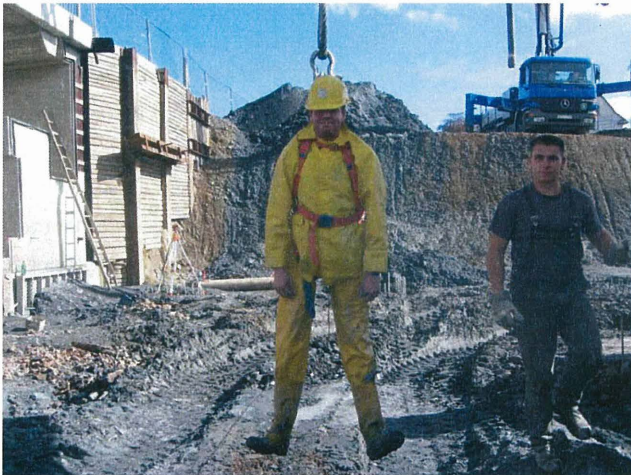
Abbildung 15: Befahren der Bohrpfähle
