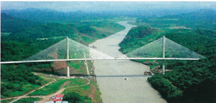
Bild 27 Die neue Schrägkabelbrücke Puente Centenario über den Gaillard Cut des Panama-Kanals nach der Fertigstellung im August 2004
