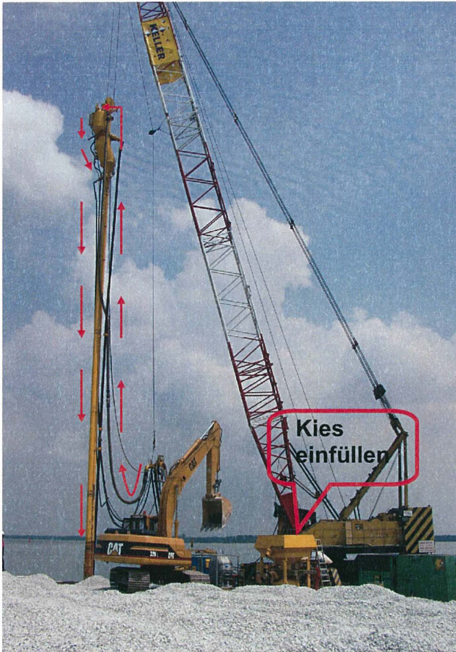
Abb. 11: Einfüllen des Schotters und Schleuse
