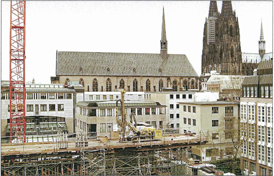
Neubau Diözesanmuseum St. Kolumba, Köln. Gründung mit Kleinbohrverpresspfählen System Stump, Gebrauchslast bis 1.500 kN
