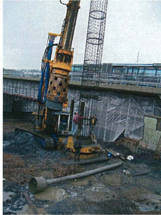
Abbildung 13: Einbau der Pfahlbewehrung
