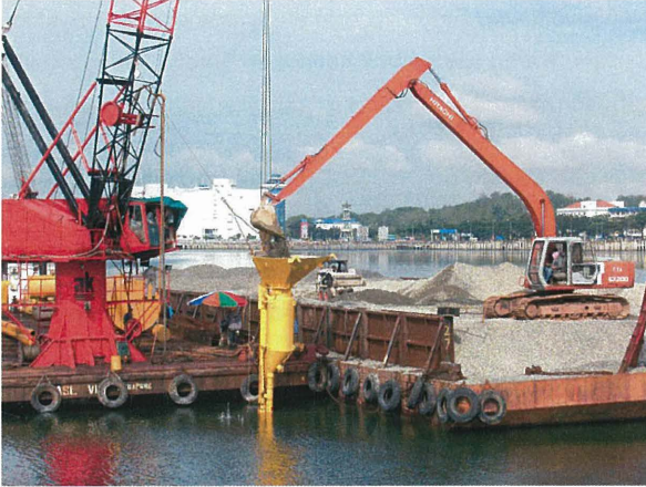
Abb. 7: Ausführung mit zwei Pontons und Langarmbagger
