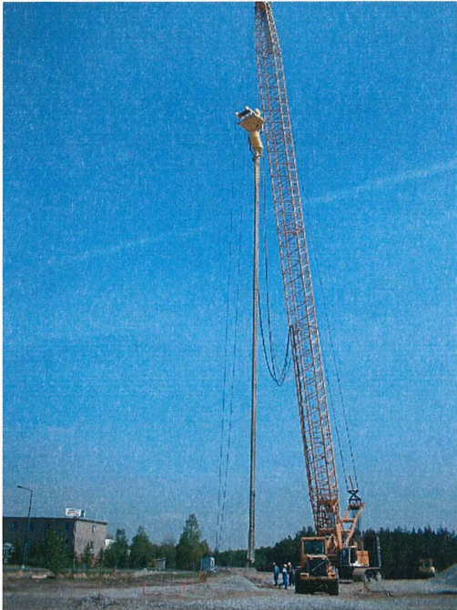
Abb. 3: Kran mit 43m langem Vibratorstrang
