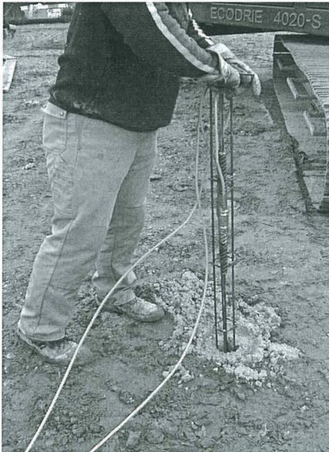
**Abb. 9: Einbringen des Bewehrungskorbes eines instrumentierten Pfahls**
