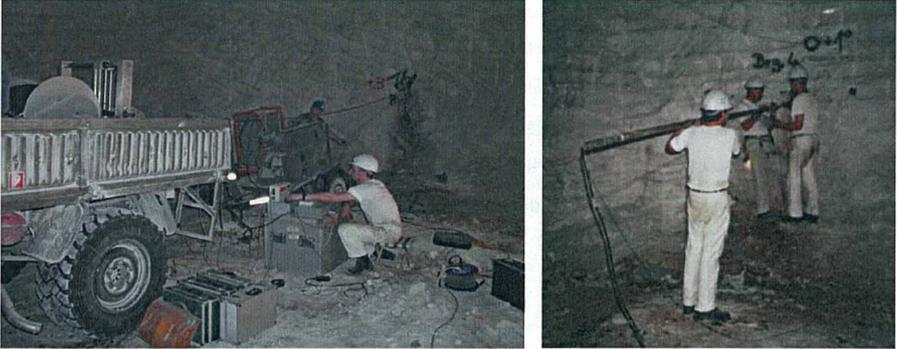
**Abb. 7 und 8:** Einsatz der Bohrloch-Radartechnologie zur Vorfelderkundung von Salinarlagerstätten aus Horizontalbohrungen – Momentaufnahmen der praktischen Messdurchführung
