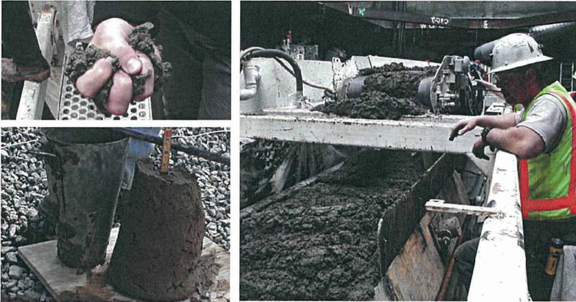
Bild 15. Konditionierter schluffiger Sand (Ausbreitmass 50 mm im Slump Test)
