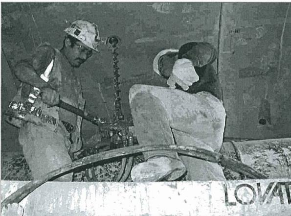
Bild 16. Bohren und Nachverpressen vom Nachläufer der TBM aus
