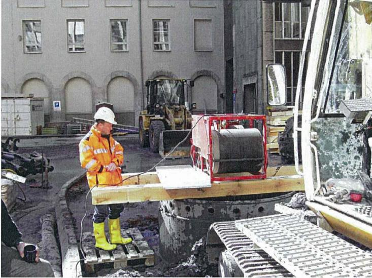
Bild 6: Vertikalitätsmessung mit dem Kodan Drilling Monitoring
