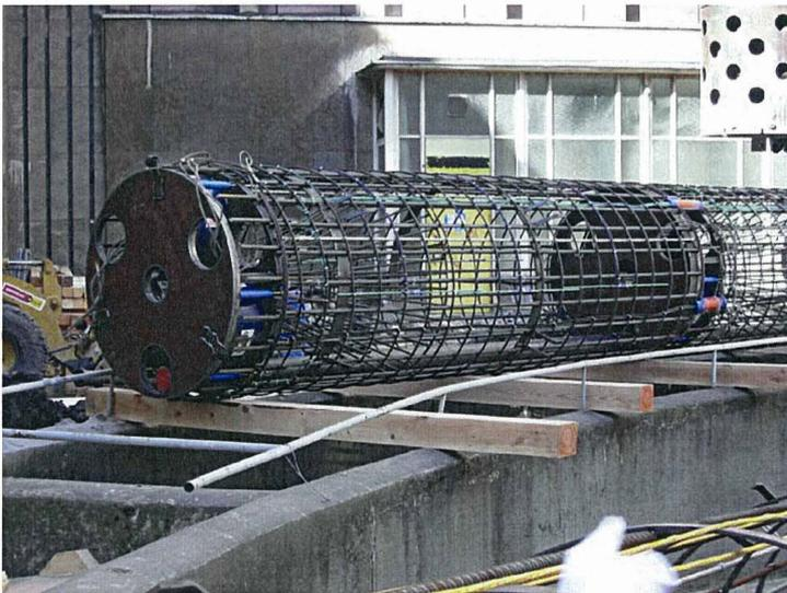
Bild 7: Bewehrungselement mit den zwei Pressenebenen vor dem Einbau
