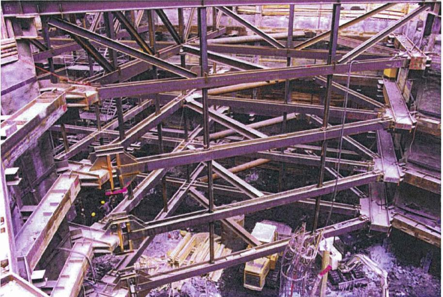
**Bild 2** Blick in den ausgesteiften Startschacht bei Erreichen des Endaushubniveaus, im Vordergrund die vorgespannten Steifen ST4
