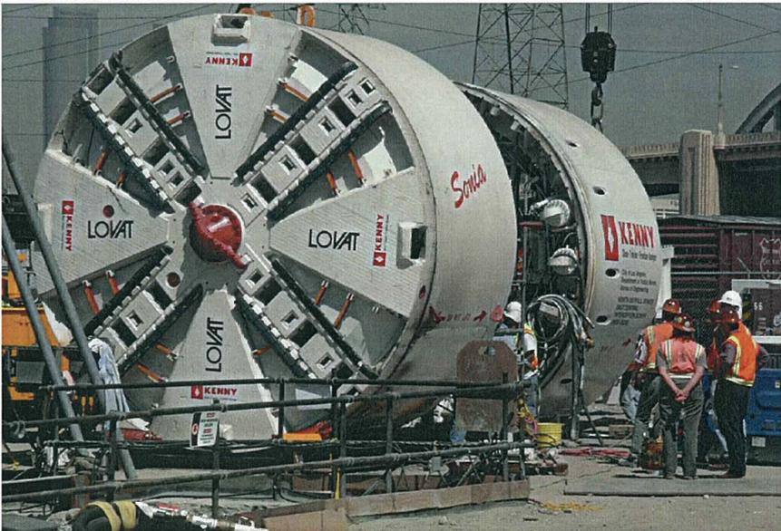
Bild 6. Montage der EPB-TBM am Startschacht Unit 4
