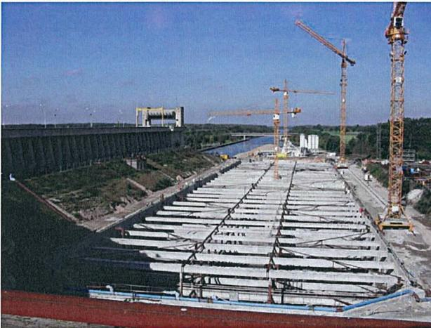
Bild 2: Mit Betonträgern ausgesteifte Baugrube neben der alten Schleuse Uelzen I (links)
