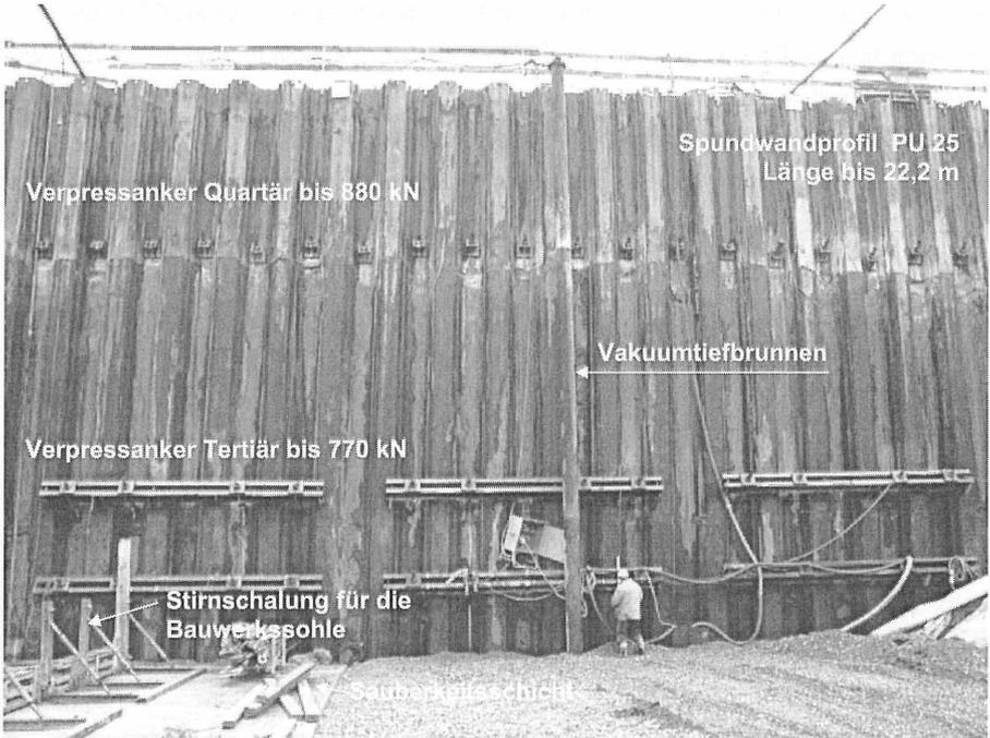
**Bild 6:** Ansicht der Spundwand nach Einbau der Filterschicht im Tunnel Rheinschlinge
