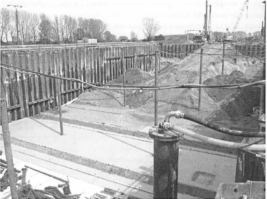
**Bild 13:** Baugrube mit erweiterter Brunnenanordnung
