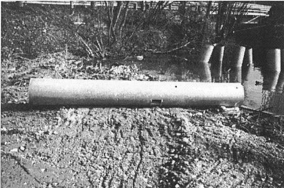
Abb. 4 Verzinkte Rohrsteelhülsen als Übergangselement zum Brückenüberbau / aufgehende Bauwerkskonstruktion in der Wasserwechselzone (im Hintergrund eine bereits auf Solltiefe gerammte Pfahlgruppe)
