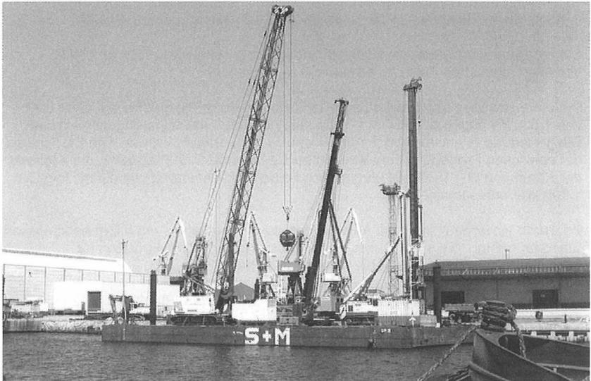
Bild 5 : Schwimmende Baustelleneinrichtung
