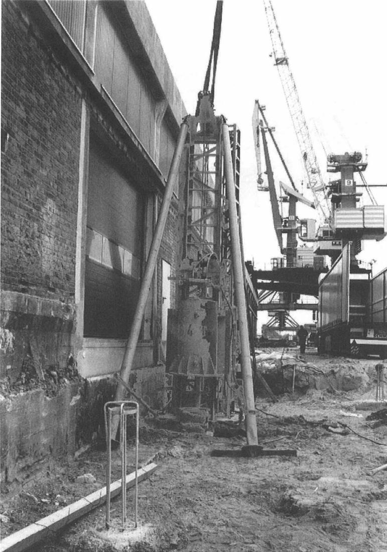
Bild 10 : Durchführung eines dynamischen Pfahltests unter beengten Platzverhältnissen
