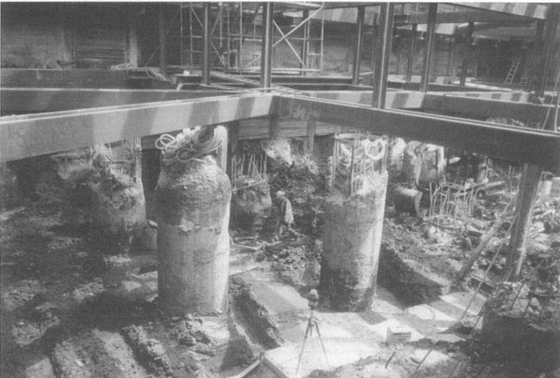
**Bild 2** Freigelegte Großbohrpfähle im Startschacht des Hochhauses MAIN TOWER
