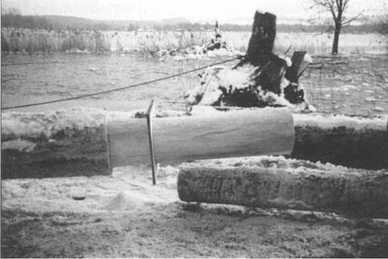
Abb. 7 Vorbereitete Pfahlköpfe zur Aufnahme der Stahlrohrhülsen.
