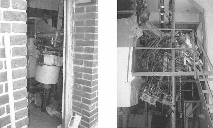
Bild 5: Baustelle Allwetterpark Velbert, Herstellung von Verpresspfählen unter beengten Verhältnissen
