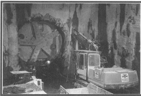
Zielschicht eines im Schildvortrieb hergestellten Hauptabwassersammlers
