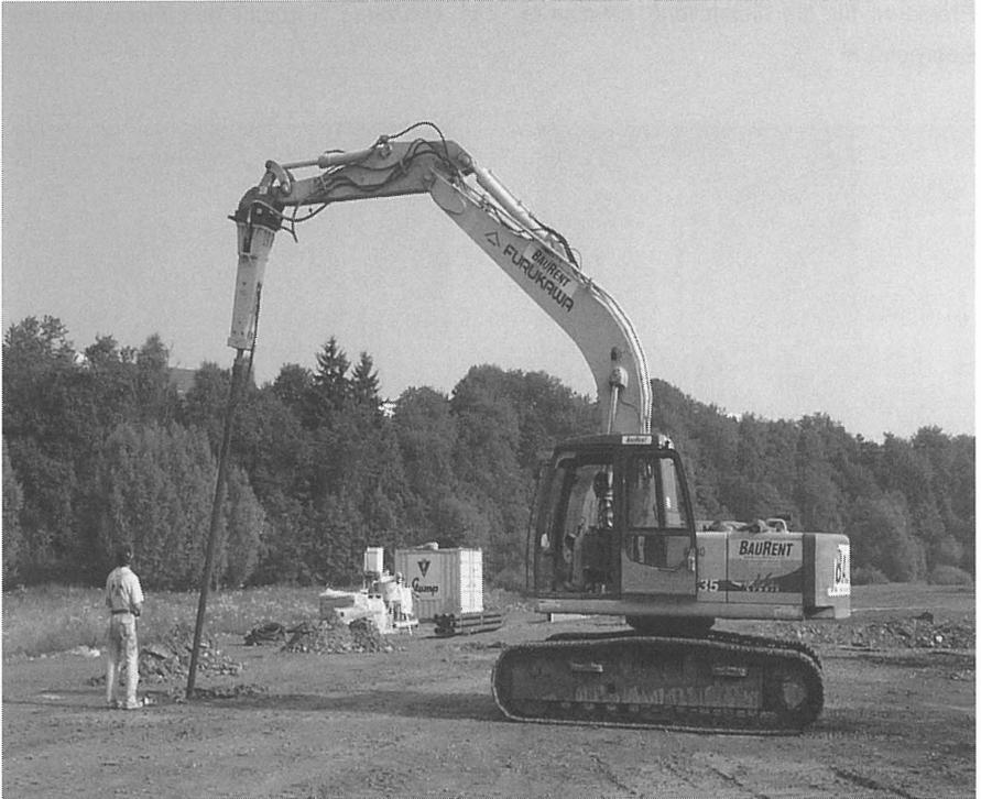
Bild 4: Baustelle Breidenbach, Herstellung Duktile Pfähle
