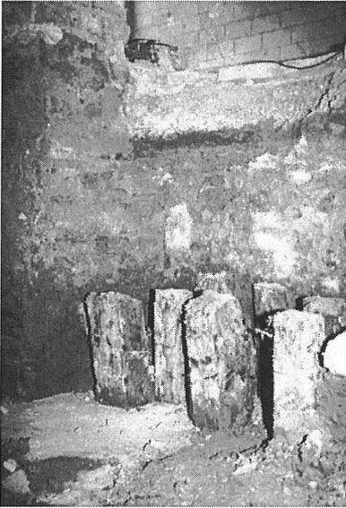
Abb. 2 Freigelegte Eichenpfähle einer Gründung aus dem 17. / 18. Jahrhundert. Die Pfähle lagen zwar innerhalb der Wasserwechselzone, waren jedoch durch die umgebenden bindigen Böden (Auelehme) weitgehend vor Sauerstoffzutritt geschützt.
