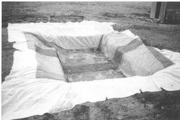
Abb. 9 Vorbereitung des mit Geogitter bewehrten Kieskoffers über dem Holzpfahlrost der Widerlager
