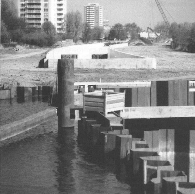
Abbildung 9: Spundwandgrube des zweiten Bauabschnitt mit dem ersten Bauabschnitt im Hintergrund
