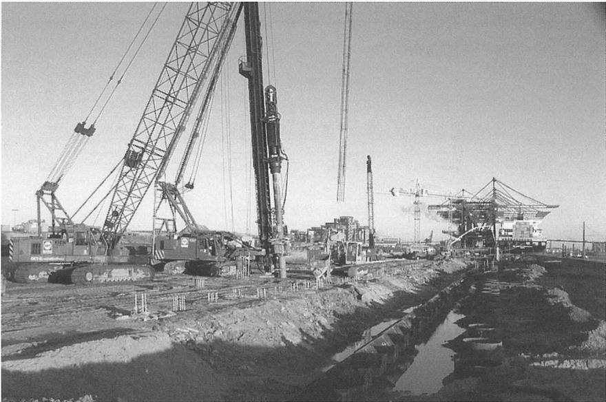
**Bild 3: Herstellung der Ortbeton-Verdrängungspfähle**
