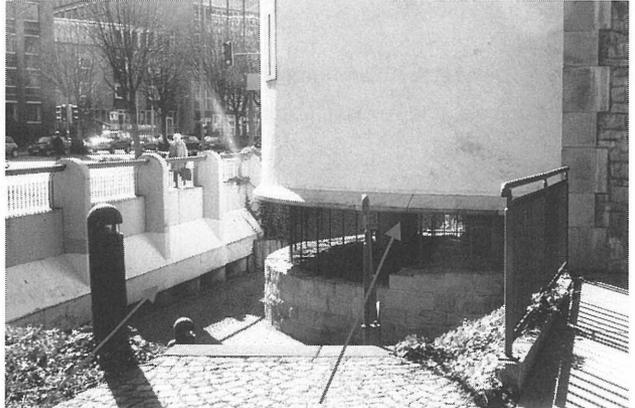
Stützwand als aufgelöste Bohrpfahlwand mit Spritzbetonverzug (unten) und Pfahlkopfbalken mit Brüstung (oben)
