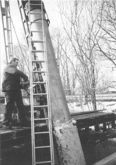
Abb. 8 Stahlrohrhülsen bei der Montage.
