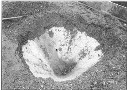
Bild 13: Freigelegte Vliesmatte nach dem Absenkversuch
