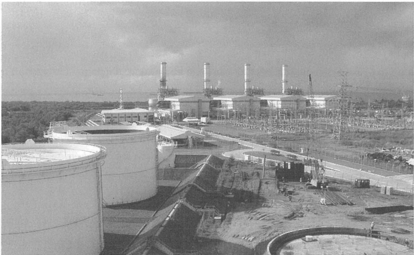
Abb. 1: Das Kraftwerk Santa Rita
