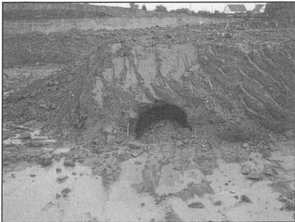
Bild 2: Freigelegter Hochbruch
