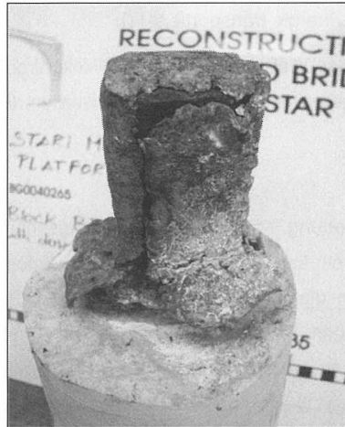
Abbildung 4: Mittels Kernbohrung aus einem Stein entnommener Dübel
