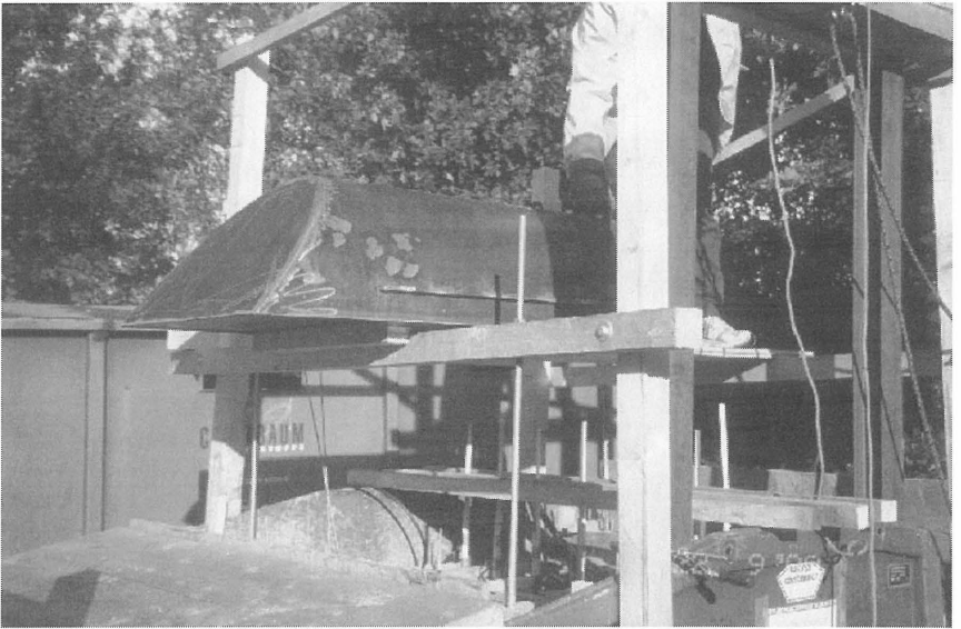
Bild 3: Versuchscontainer mit Verdrängerrohr vor dem Absenken
