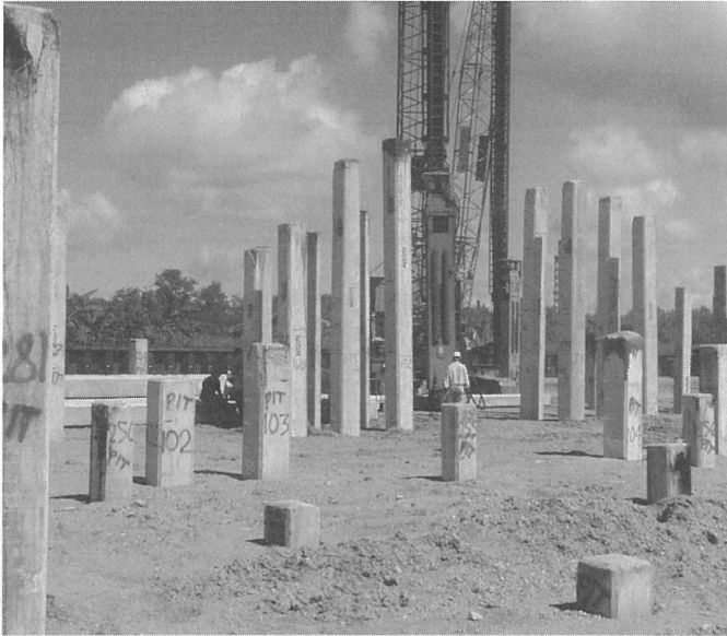
Abb. 4: Meßtechnische Überwachung bei den Rammarbeiten
