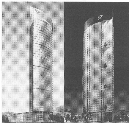
Bild 3: Ansicht des Hochhauses der Deutschen Post AG in Bonn
