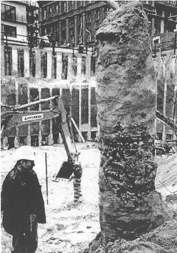
Bild 7: Soil-Jet-Gewipfahl im Berliner Sand
