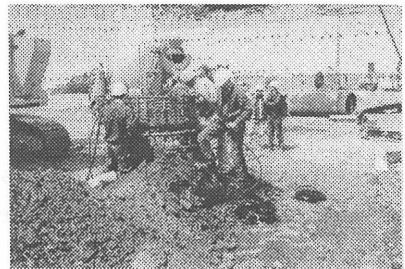
Bild 9: Einbau der messtechnischen Elemente bei der Pfahlherstellung
