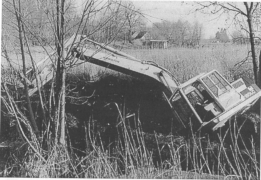
Bild 6 Versinken eines Baggers im Moor
