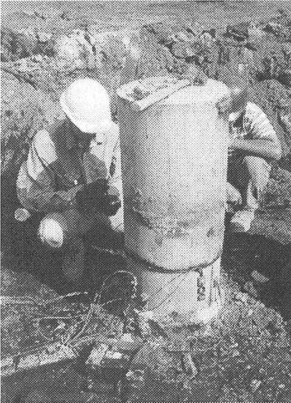
Bild 1: Vorbereitungen am Bohrpfahl
