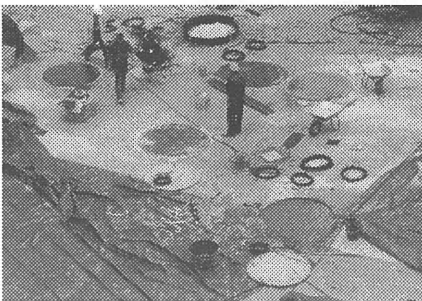
Bild 10: Einbau der Pufferschicht und der Meßelemente auf den Pfahlköpfen
