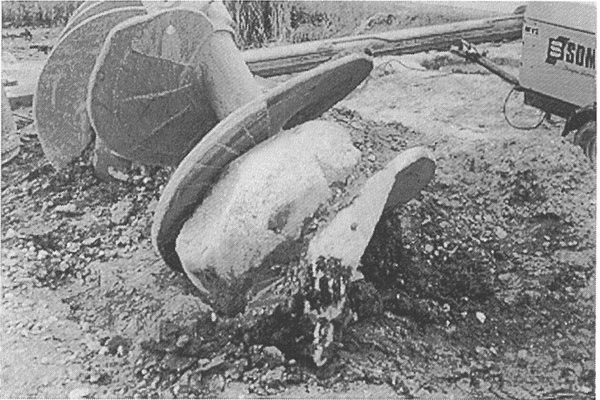
Bild 9 In der Bohrschnecke eingeklemmter Findling
