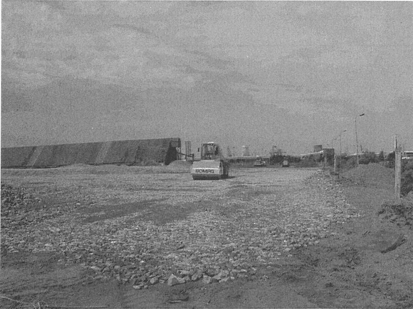
Abb. 4: Einwalzen von RC-Material in das Deponieplanum
