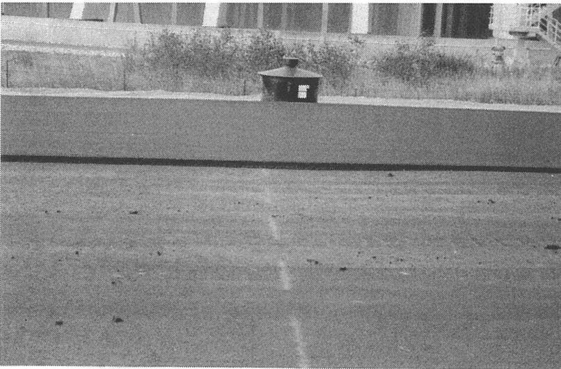
Abb. 4: Ausgleich der Setzungen der Deponieasphalttragschicht durch überhöhten Einbau der Binderschicht
