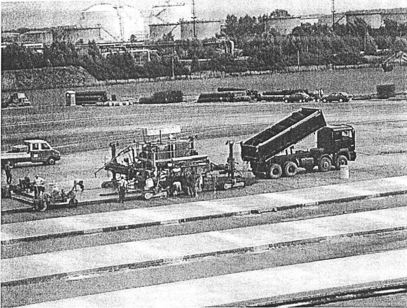
Abb.5: Einbau der Betonfahrbahn
