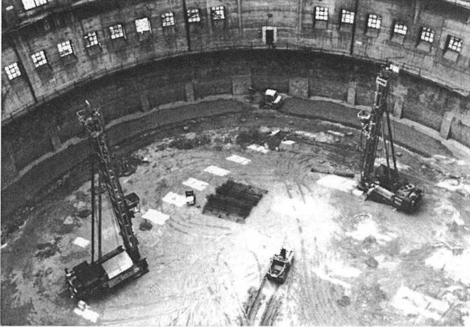
Bild 9: Herstellung der *FRANKIPFÄHLE* innerhalb des Behälters
