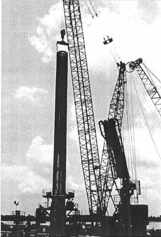
Bild 8: Einbau des Bewehrungskorbes
