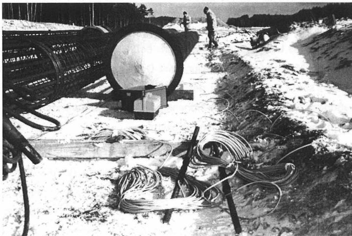
Bild 1: Liegende Bewehrungskörbe mit Stahlhülse und Meßwertgebern
