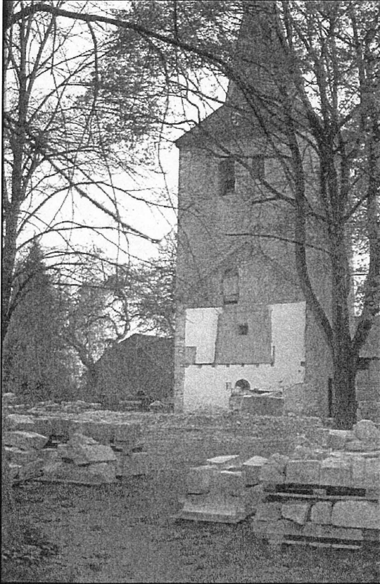
Bild 5: Kirchengelände der Ortschaft Hedeper nach Abtrag des Kirchenschiffes
