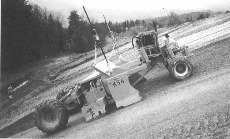
**Bild 3:** Verdichtung des Bentokies mit Fertiger (Prototyp)
