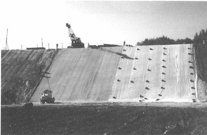
Foto 3: Klärschlammdeponie Asten. Arbeitsablauf auf der Böschung (von links nach rechts): Nachdem der Untergrund mit der FDVK geprüft worden ist, wird das REALIT von unten nach oben aufgebracht, anschließend verdichtet und arbeitsintegriert mit der FDVK überprüft. Abschließend wird die Basisabdichtung mit einem Vlies abgedeckt.
