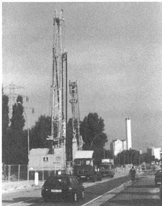
Abb. 7: Fräsen unter beengten Verhältnissen in der Andreas-Meyer-Straße, Fräse BC 20 mit Verdreheinrichtung
