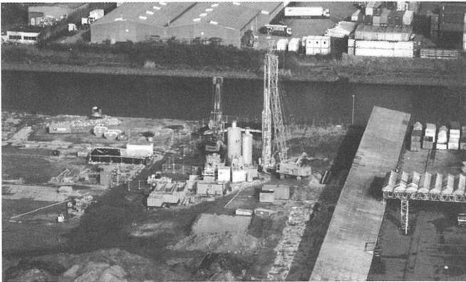
Abb. 5: Baustelleneinrichtung für den Bau der Testdichtwand
