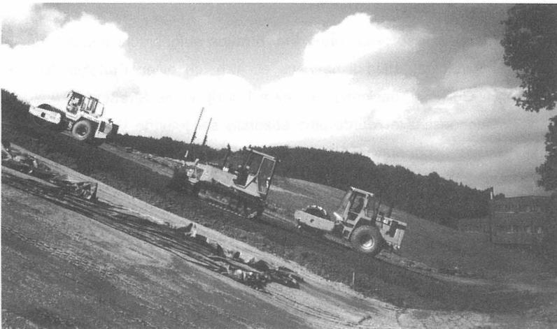
**Bild 4:** Einbau und Verdichtung mit Raupe und Walzen
