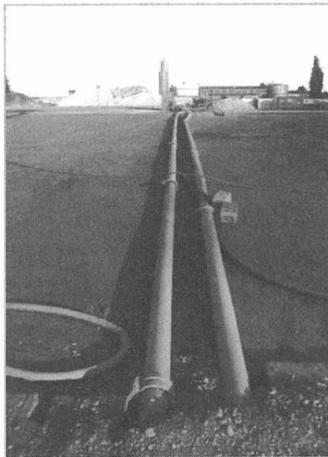
Abb. 10: Zwischenpumpstation für große Abstände zwischen dem Fräsenbagger und der Entsandungsanlage
