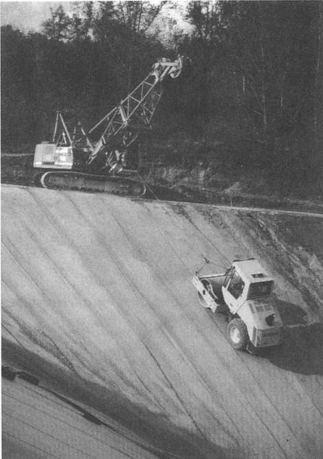
Foto 2: Klärschlammdeponie Asten. Meßwalze BOMAG BW 177 DH-3 während einer Meßfahrt auf steiler Böschung; die Walze wird vom Seilbagger LIEBHERR HS 832 HD mit konstanter Geschwindigkeit gezogen.
