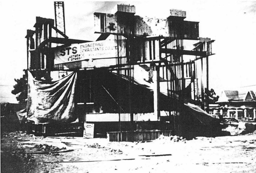
**Bild 6:** Versuchseinrichtung einer Pfahlprobebelastung mit acht Ankerpfählen
