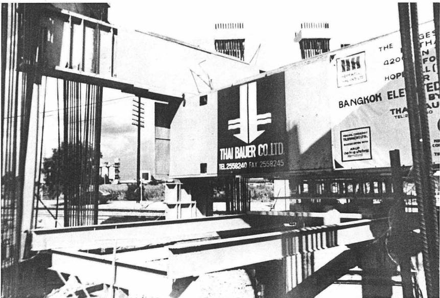
**Bild 5:** Versuchseinrichtung einer Pfahlprobelastung mit sechs Ankerpfählen
