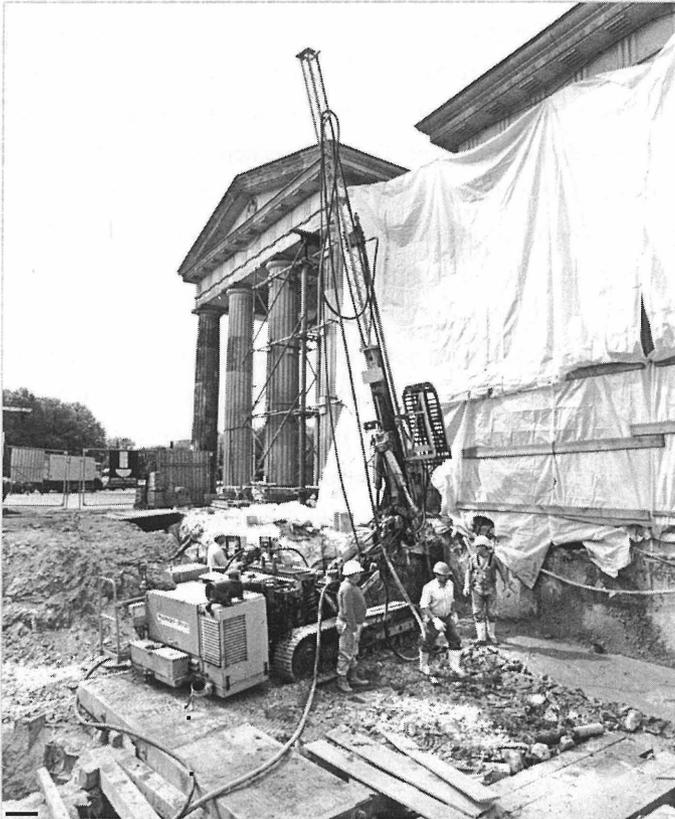
**Bild 7:** Herstellung der Unterfangung unter dem Südlichen Torhaus
