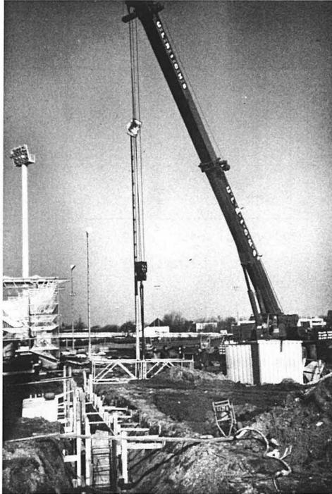
Bild 3: Lasteinleitung mit Autokran
