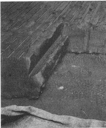
Bild 73: Herstellung eines Versuchsfeldes aus homogenisierten Tonziegeln
