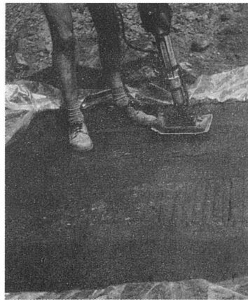
Bild 73: Herstellung eines Versuchsfeldes aus homogenisierten Tonziegeln
