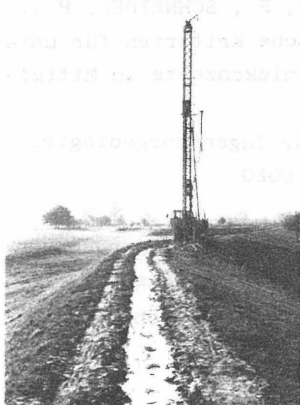
Rütteldichtwand Rheindeich Neuwied
