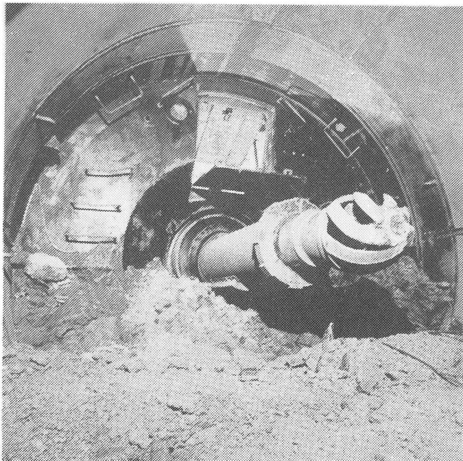
Bild 14: Blick auf das Abbauwerkzeug des Thixschildes, den Cutter
