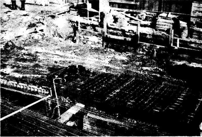
Bild 17: Einbau der Rohre in den Bewehrungskorb
