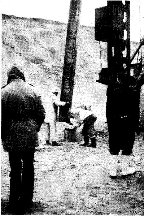
Bild 2: Anheben des zweiten Pfahlteiles (Oberpfahl)
