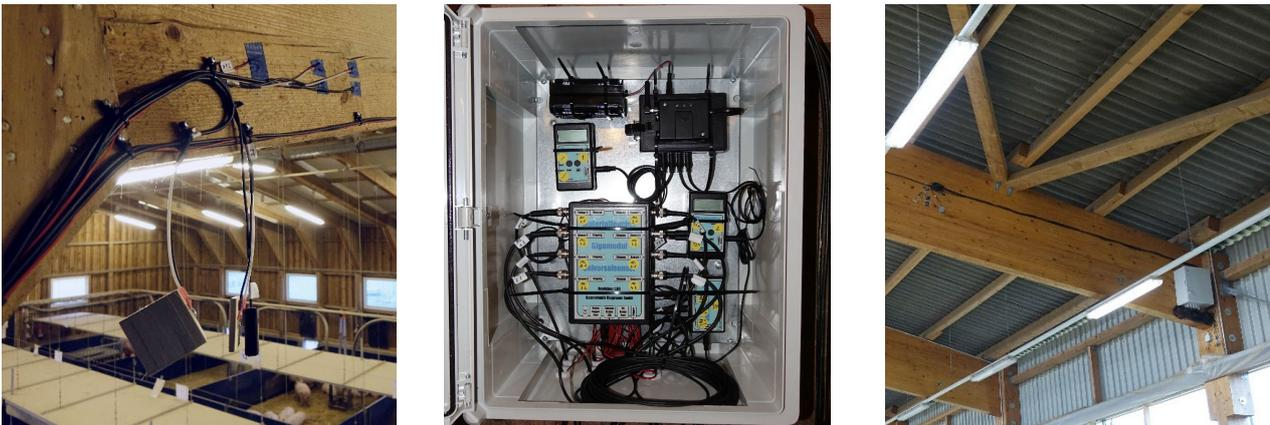
Abbildung 11: Eindrücke der installierten Messtechnik in landwirtschaftlichen Gebäuden (v.l.n.r.: Installierte Messstellen im Schweinestall Echem, Messtechnikbox mit Funkmodul für die Datenübertragung, Installierte Messstellen und Messbox in der Reithalle), Fotos © holz[bau]physik
