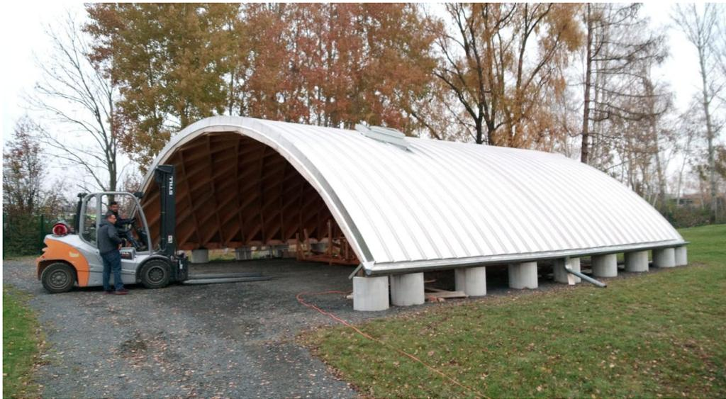
*Abbildung 54: Großdemonstrator einer Halle nach dem Prinzip ReFlexRoof (TimberPlan+) auf dem Gelände der MFPA Leipzig inkl. Dacheindeckung und Rautenfenster, Grafik: FLEX @ HTWK Leipzig, Marius Zwigart, M.A. | Architekt*
