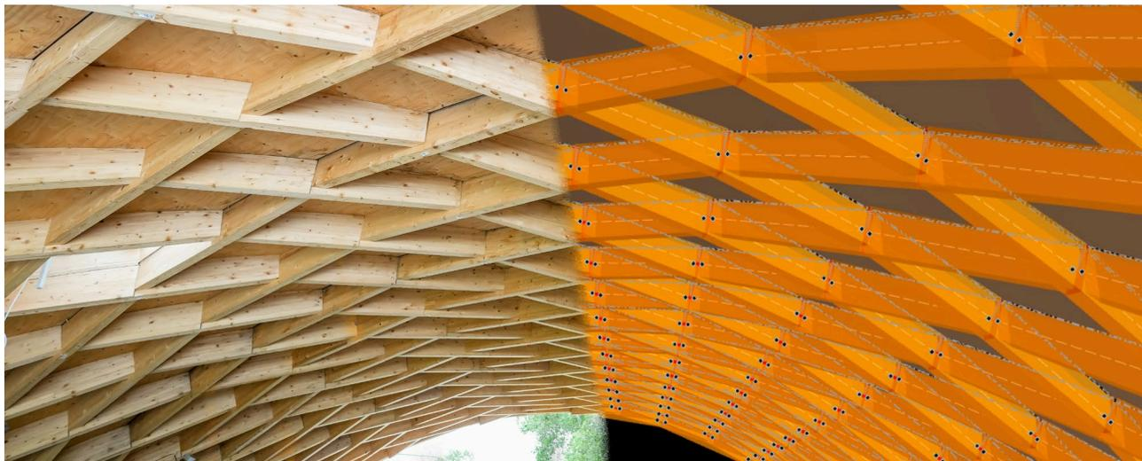
Abbildung 32: Erarbeitung des Statikmodells (rechts) auf Grundlage der konstruktiven Ausführung (links), Grafik: HTWD
