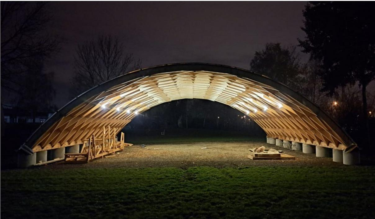
Abbildung 1: Großdemonstrator einer Halle nach dem Prinzip ReFlexRoof (TimberPlan+) auf dem Gelände der MFPA Leipzig, Grafik: MFPA Leipzig, Mike Kolbig
