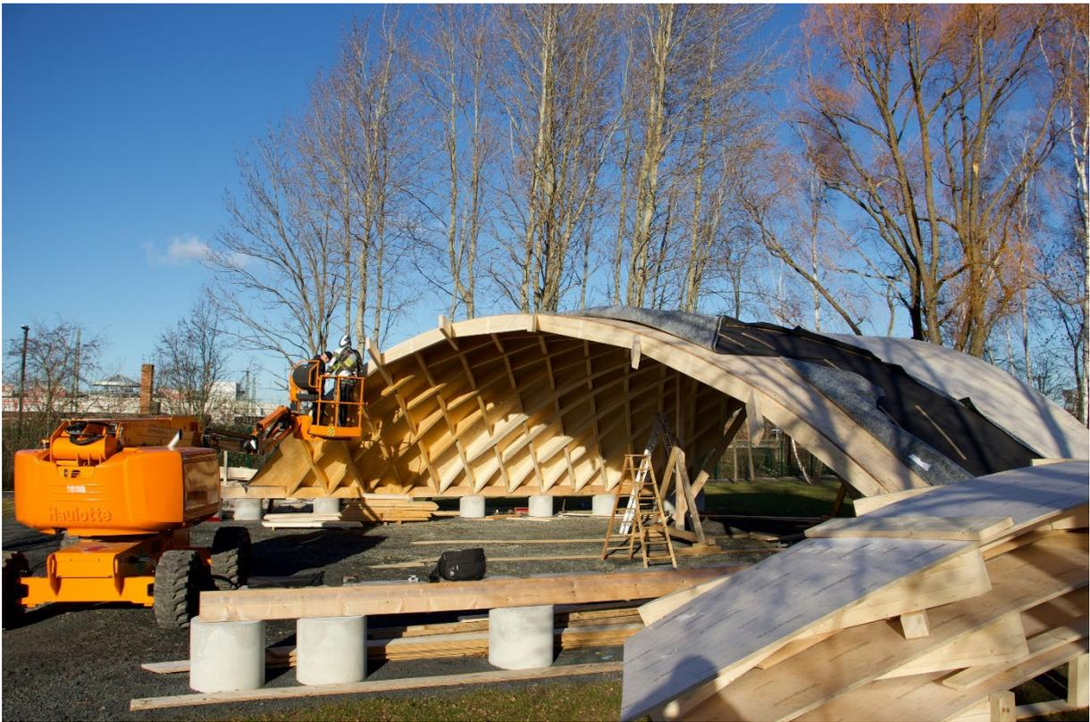
Abbildung 42: Aufbau der Halbschalenelemente zum Demonstrator auf der Baustelle,
