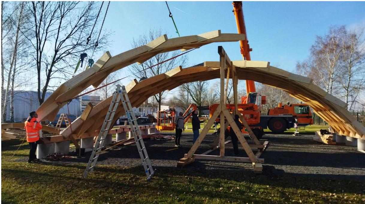
*Abbildung 10: Fügung der Halbschalenelemente des Demonstrators auf der Baustelle,
