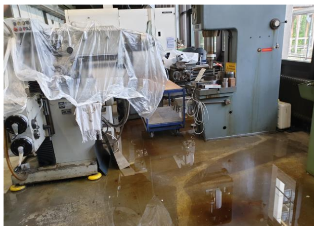
Mai 2022 Wassereinbruch in den Laboren
