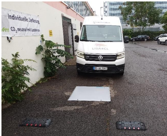
Fertig installierte Ladestation in Berlin
