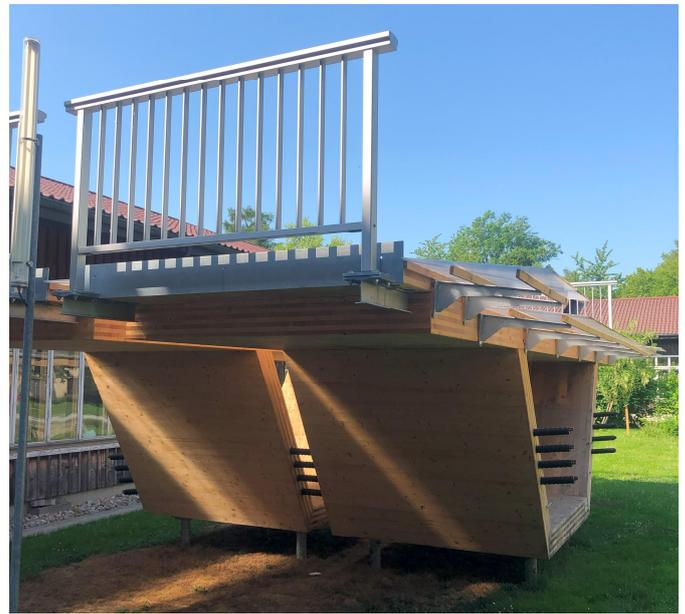
10 Arbeitsmodell zur TS3-Technologie für Schwerlastbrücken
