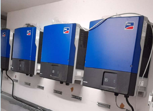
1328, Einbau Wechselrichter - Bildnachweis: GB3
