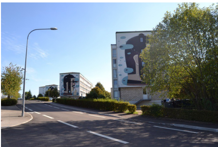
Abbildung 2: Drei Wohnhäuser der Résidence Colette
