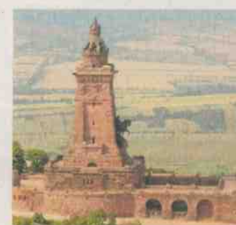
Das Kyffhäuserdenkmal. H. KOLBE
