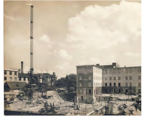
Bild 5: Baustelle des Neubaus der elektrotechnischen Institute, die auf der Basis eines modernen Eisenbetongerüsts gebaut wurden. Quelle: elenia Institut.
