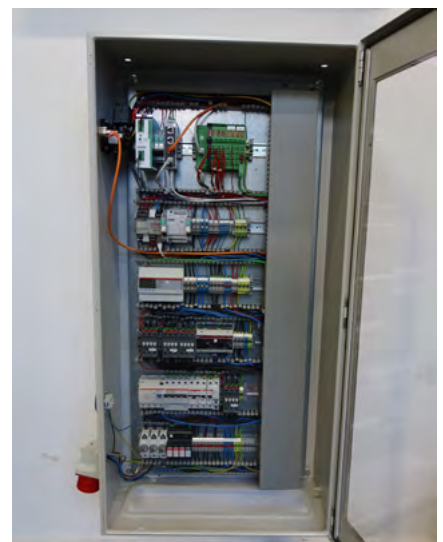
LABORLADESÄULE DES PRAKTIKUMS ELEKTROMOBILITÄT
