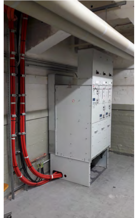
SWITCHGEAR
