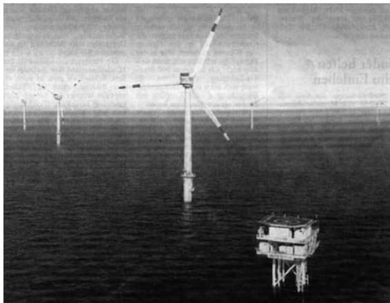
Erster deutscher Offshore-Windpark „Alpha Ventus“, rund 45 km vor der ostfriesischen Insel Borkum (Kreis Leer). Im Vordergrund die Trafo-Plattform mit dem Helikopterdeck. Das Testfeld besteht aus zwölf Windkrafträdern. Mit dem erzeugten Strom können 50 000 Haushalte versorgt werden
