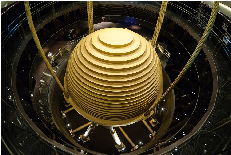
Abbildung 5.2: Beispiel einer Feder–Dämpfer Erdbebensicherung im Taipei 101. Foto: Armand du Plessis, CC BY 3.0, via Wikimedia Commons
