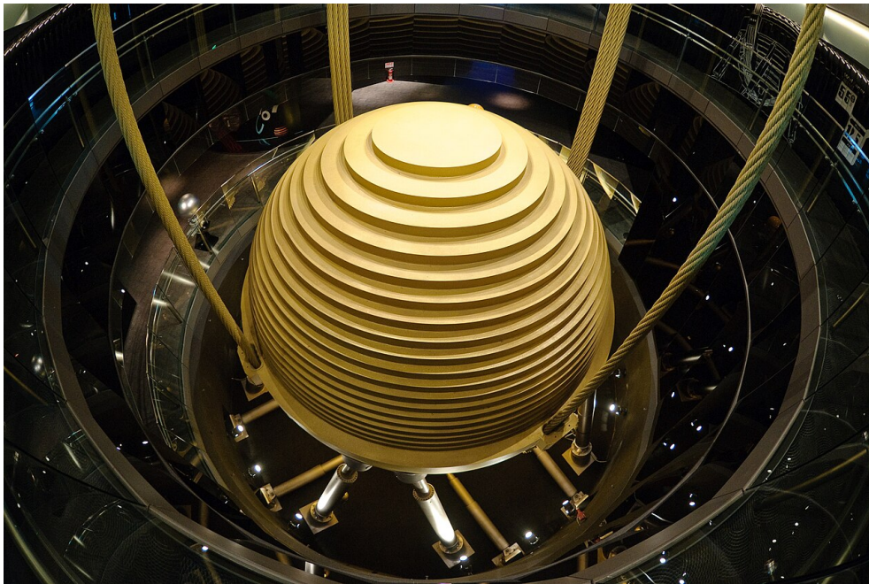
Abbildung 2.6: Beispiel einer Feder–Dämpfer Erbebensicherung im Taipei 101. Foto: Armand du Plessis, CC BY 3.0, via Wikimedia Commons
